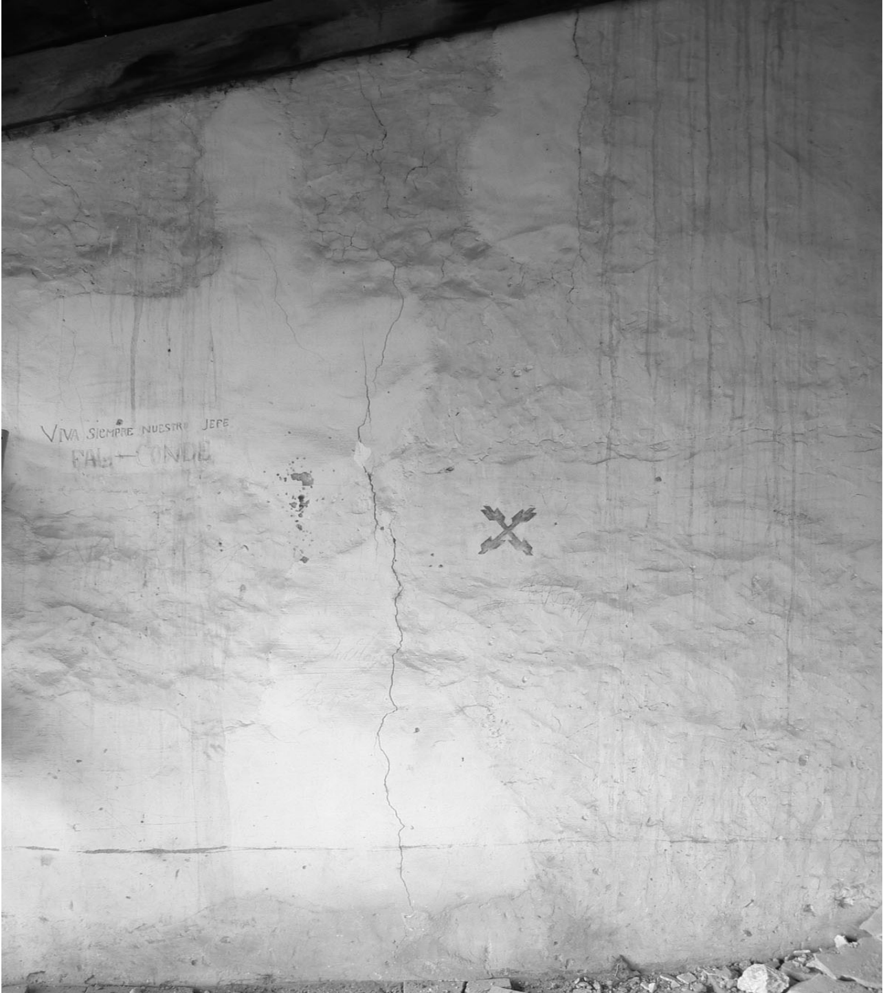
Figura 4. Alzado de uno de los muros del solar con los graffiti antes del arranque
