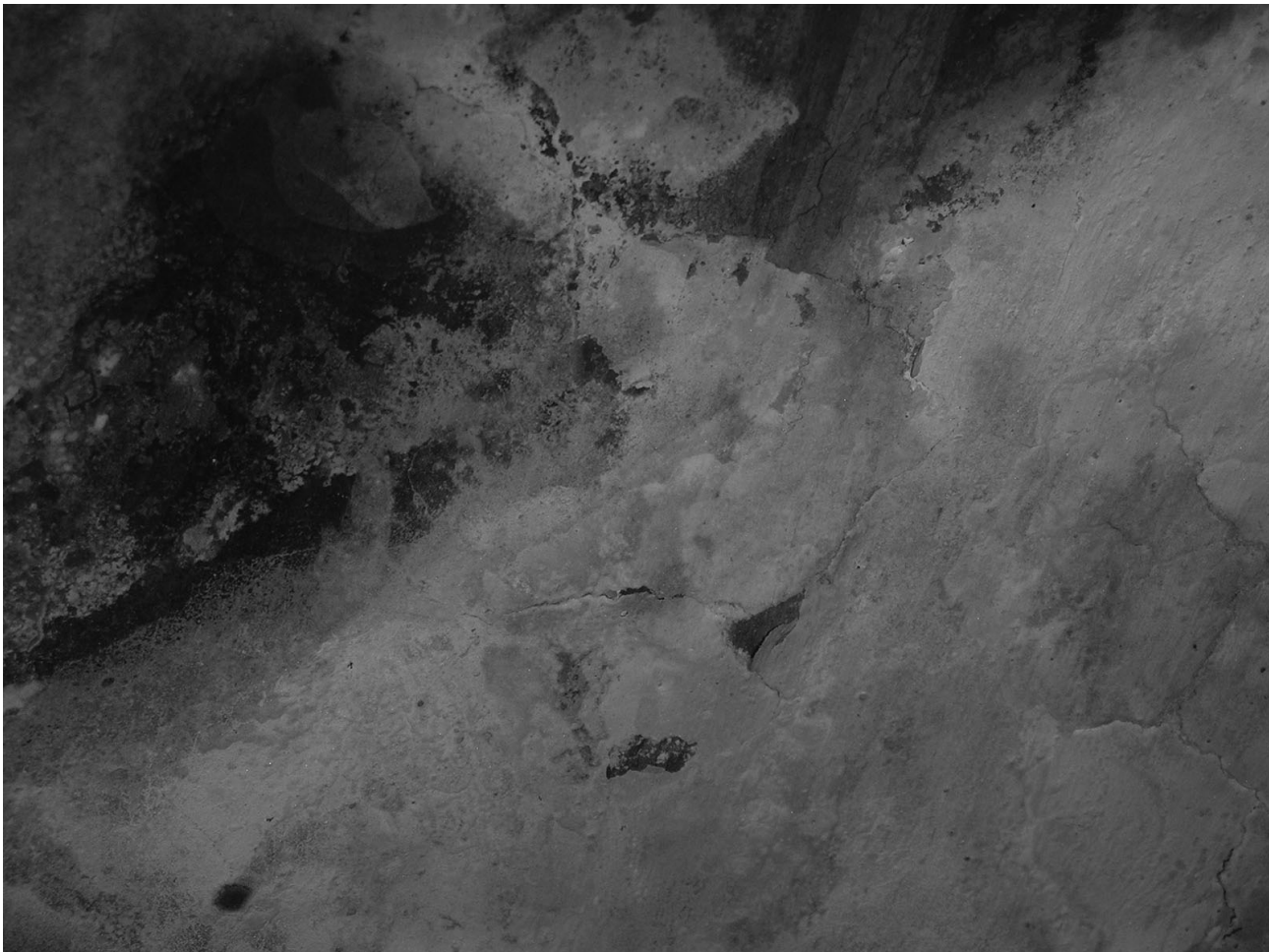
Figura 1. Imagen de las eflorescencias blanco-grisáceas presentes sobre los frescos de uno de los lunetos de bóveda central de la Iglesia de los Santos Juanes de Valencia
