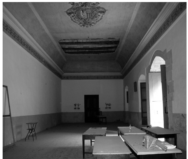
Figura 4. Vista actual del refectorio
