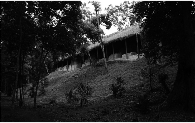
Figura 5. Fachada oeste de la Acrópolis vista desde la calzada
