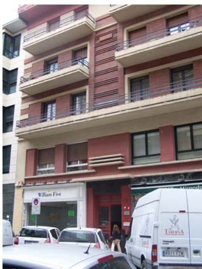
Fig. 314 Edificio de viviendas en calle García Castañón 2 y 4. Pamplona. 1932. Detalle de la zona de acceso
