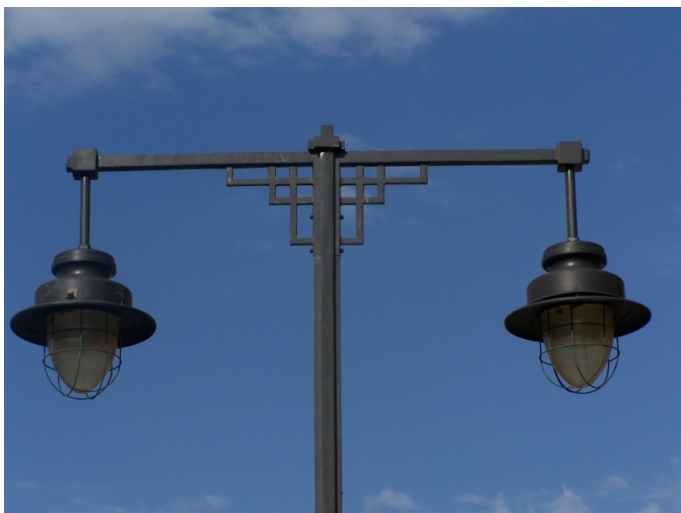
Fig 581, 582 y 583 Distintos remates de farola de dos brazos con luminarias Carandini, globos DGC y Socelec. (JFPS 2010)
