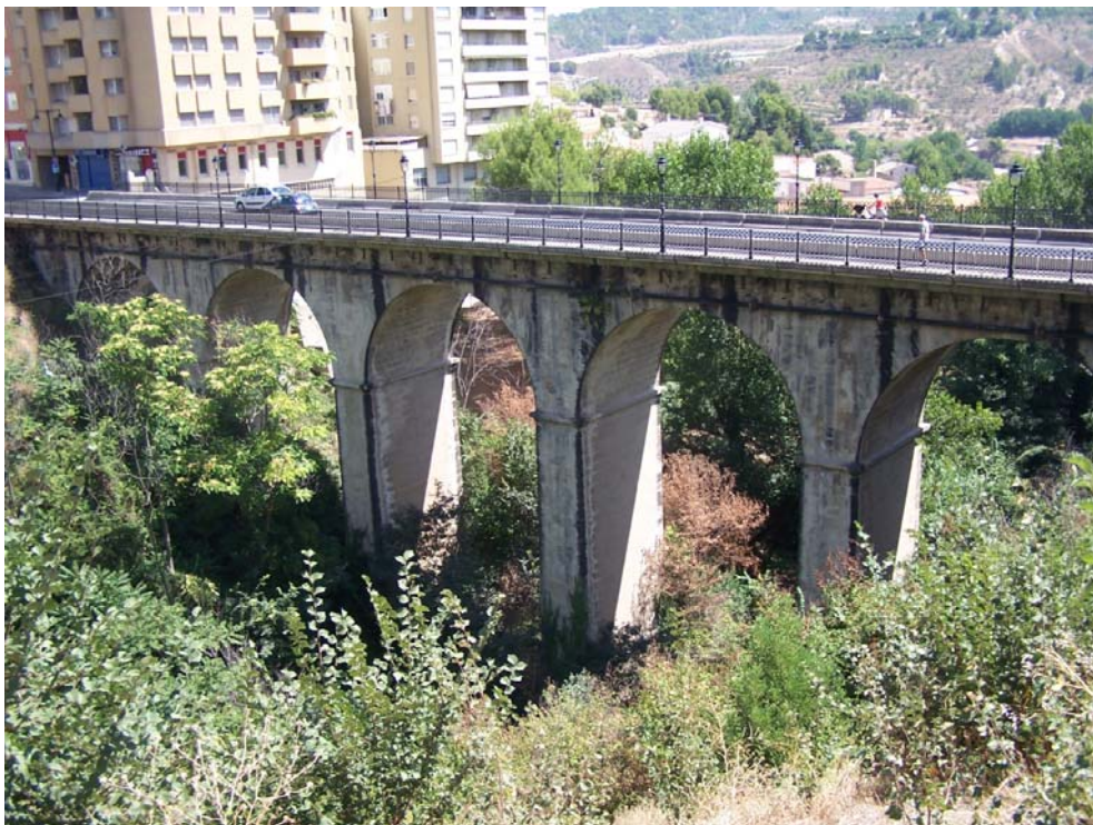
Fig. 106 Puente de la Petxina . Alcoy. 1863. Vista desde aguas arriba. (JFPS 2011)
