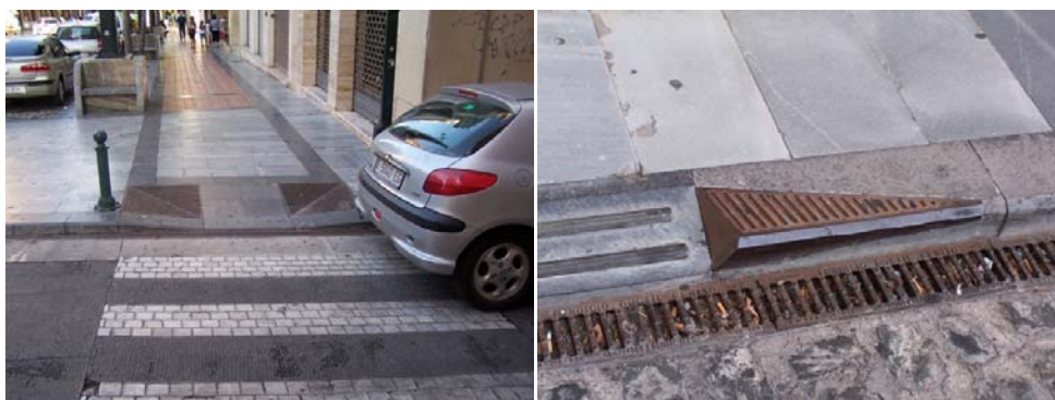
Fig. 642 y 643 Detalle de dos vados para peatones (JFPS 2010)
