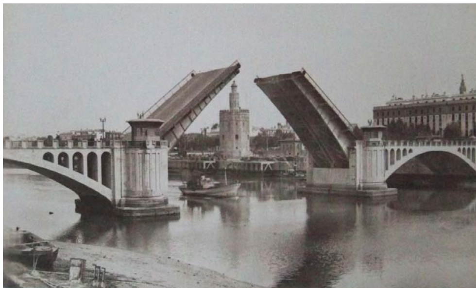
Fig. 137 Puente de San Telmo (Sevilla). J.E. Ribera, 1920-1931 (WP)
