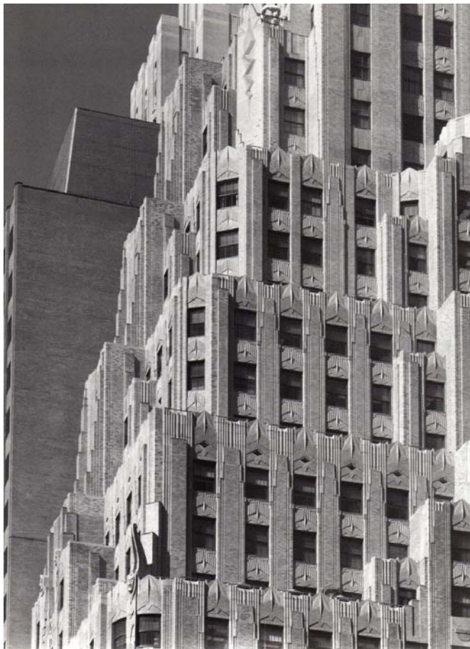
Fig. 51 Detalle del edificio de la General Electric. New York 1931 (AU)
