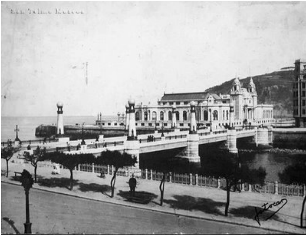
Fig. 130 Puente del Kursaal o de la Zurriola. San Sebastián. 1916-1921. Imagen histórica del puente con el edificio del Gran Kursaal al fondo. (MG)
