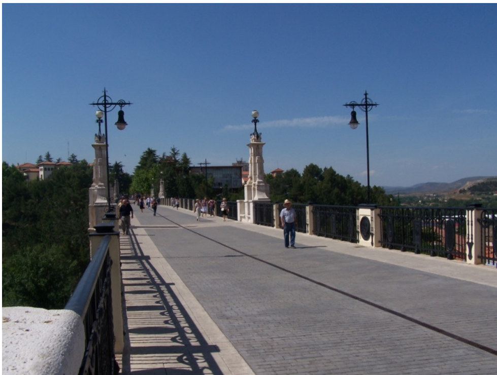
Fig. 372 Detalle de la pila y los arcos del Viaducto de Madrid. 1932-1942.
