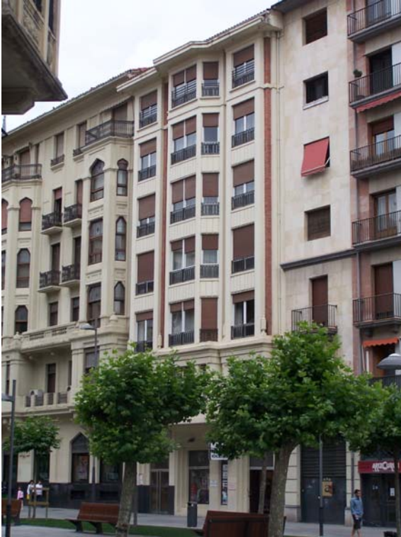
Fig. 260 Edificio en la Av. Roncesvalles, 8. Pamplona. 1928. (JFPS 2011)
