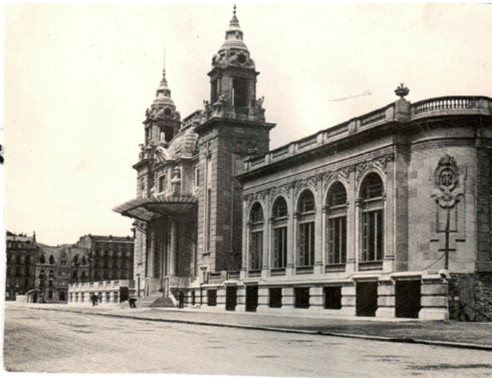
Fig. 236 Edificio Gran Kursaal. San Sebastián. 1921. Detalle de la parte derecha de la fachada principal. (PK)
