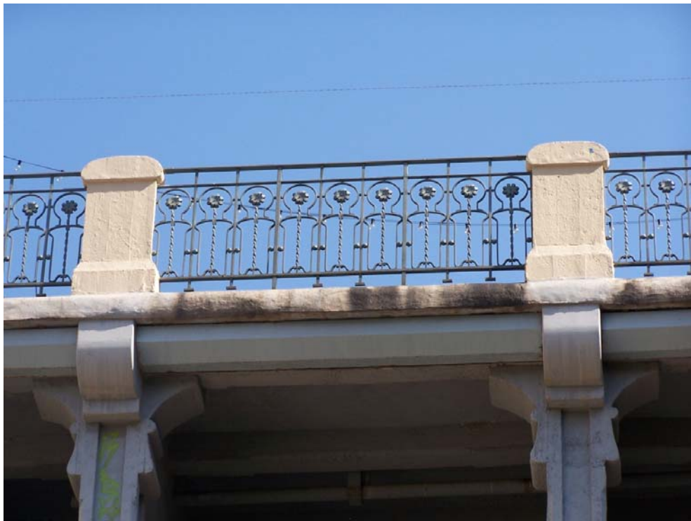
Fig. 129 Viaducto de Canalejas. Elche. 1913. Detalle de la barandilla. (JFPS 2011)
