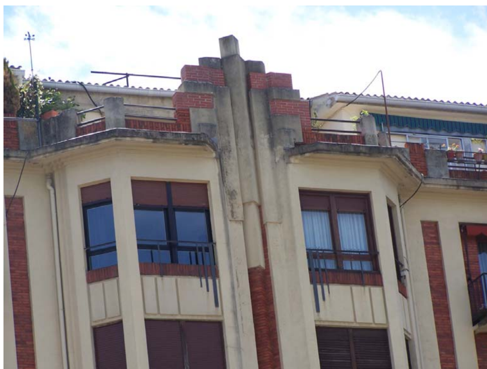
Fig. 287 Edificio de viviendas en la calle Arrieta, 9. Pamplona. 1930. (JFPS 2011)
