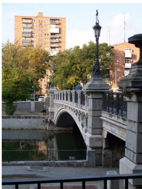
Fig. 123 Puente de la Reina Victoria. Madrid. 1907-1909. Vista Tangencial del frente desde aguas abajo. (JFPS 2011)
