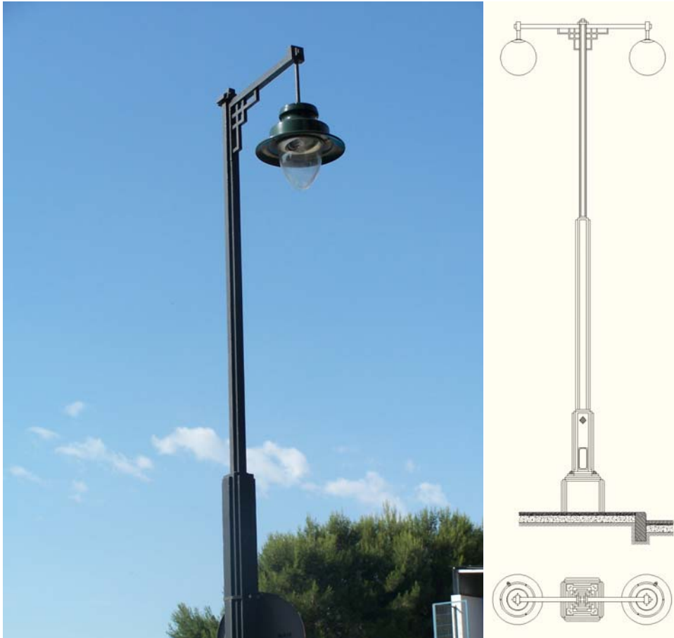
Fig. 588 y 589 Detalle de la farola de un brazo y plano de alzado con luminaria esférica DGC. (JFPS 2010, IGS)
