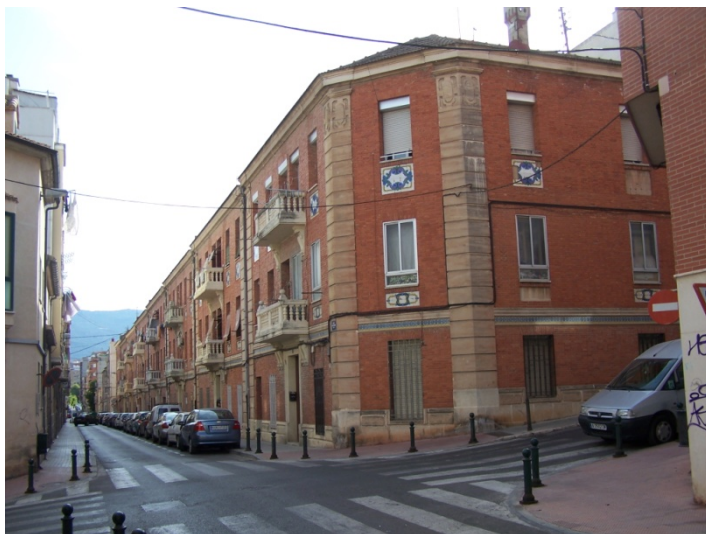
Fig. 504 Edificio de viviendas baratas del Retiro Obrero. C/ Pintor Cabrera. Alcoy Enrique Viedma Vidal, arquitecto. 1929-1931 (JFPS 2012)
