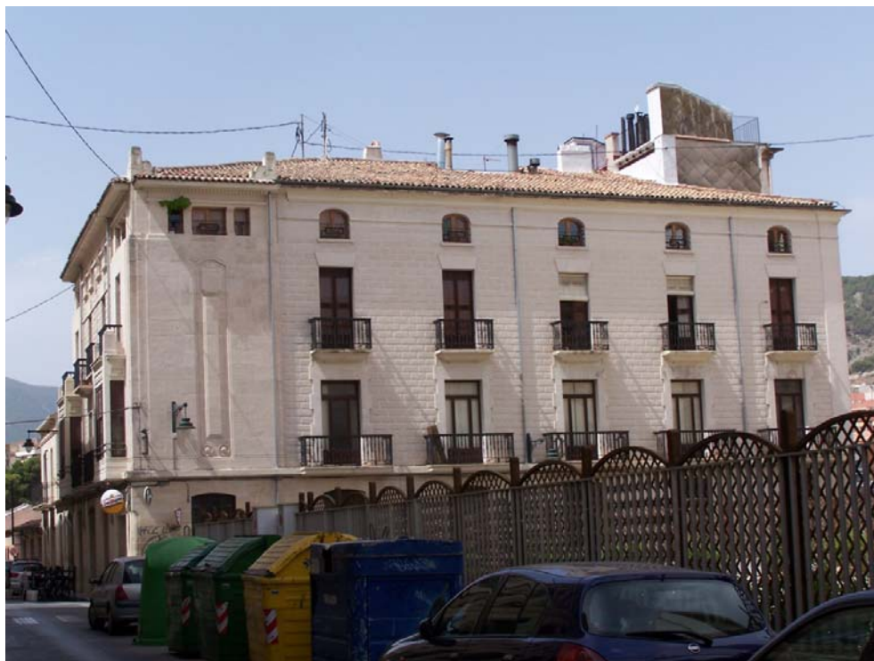
Fig. 492 2ª proyecto y edificio de viviendas en la esquina de las calles Orberá – Cura Belloch. Alcoy Vicente Valls Gadea, arquitecto. 1927 (JFPS 2012)
