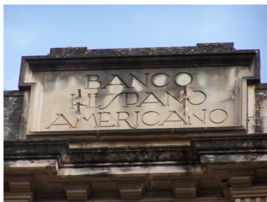
Fig. 500 Rótulo del edificio Av. País Valencià, 29. Alcoy. J. Aracil, arqto. 1928 (JFPS 2012)
