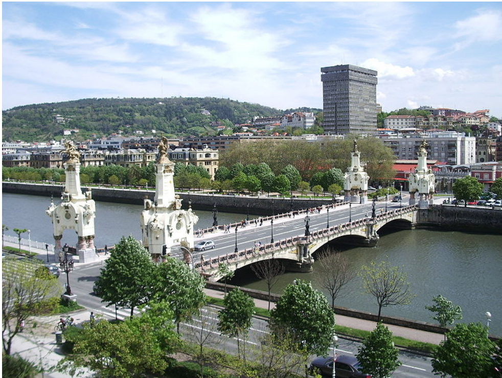
Fig. 117 Puente de María Cristina. San Sebastián. 1903-1905. Vista desde la margen izquierda aguas arriba (GE)
