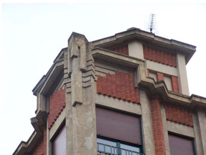
Fig. 275 Edificio de viviendas en Plaza Príncipe de Viana. Pamplona. 1929. Detalle del remate del pináculo de las esquina. (JFPS 2011)
