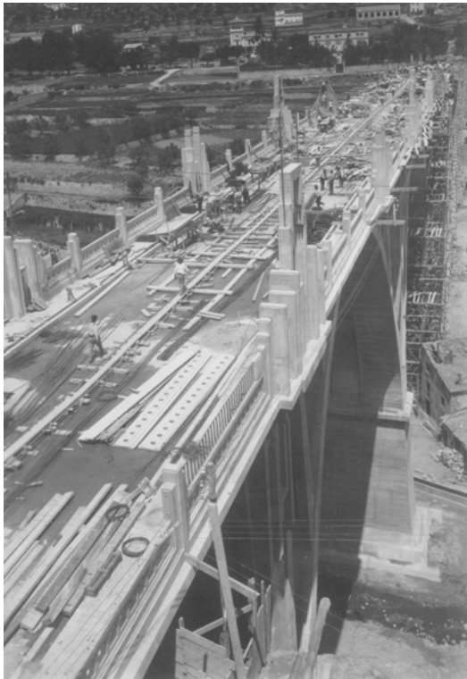
Fig. 220 Puente de San Jorge en construcción. Alcoy (JN)
