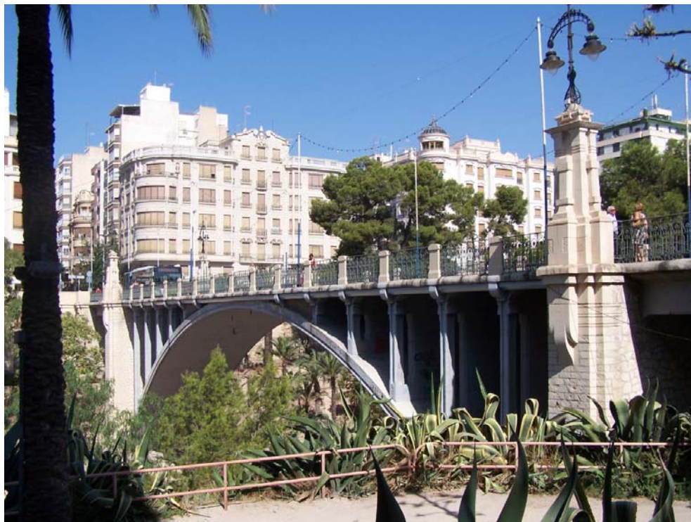
Fig. 128 Viaducto de Canalejas. Elche. 1913. Vista lateral desde aguas abajo. (JFPS 2011)
