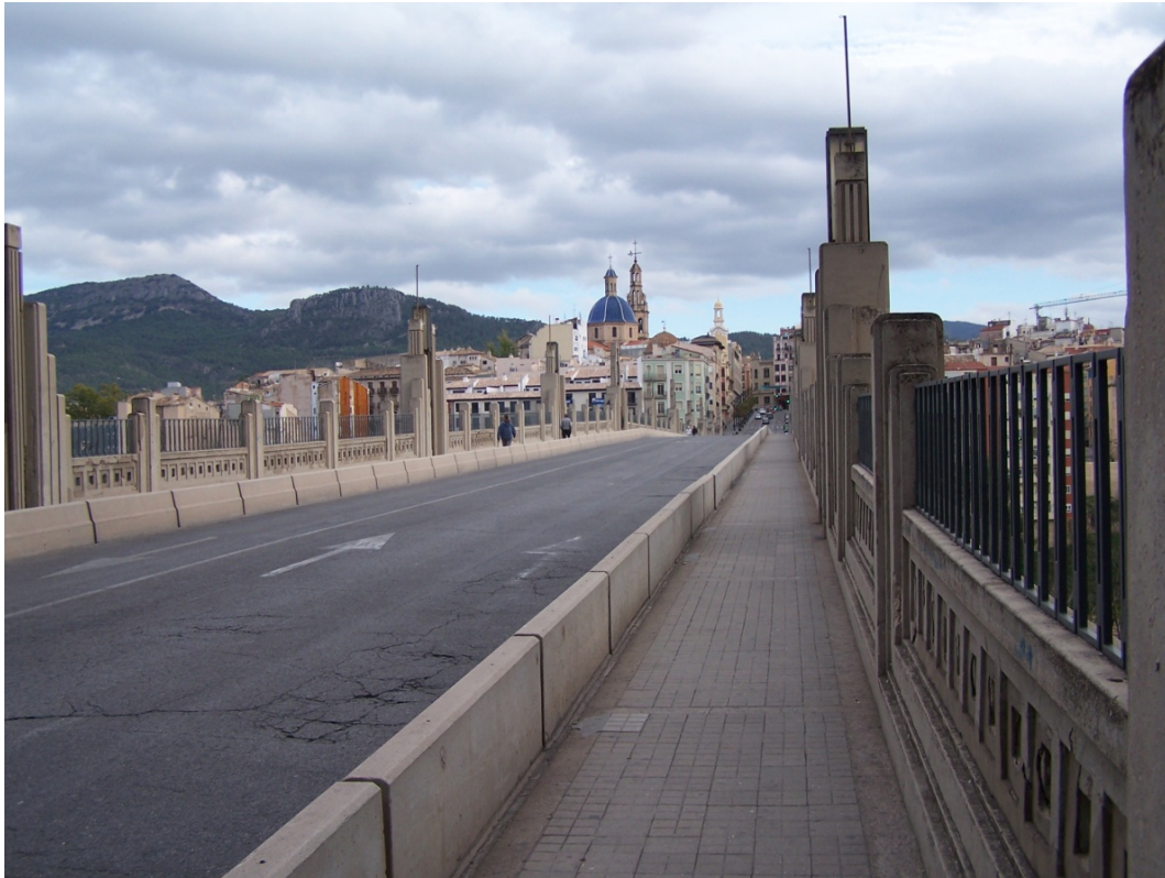
Fig. 324 Margen derecha del interior del tablero del puente hacia el centro de la ciudad (JFPS 2009)
