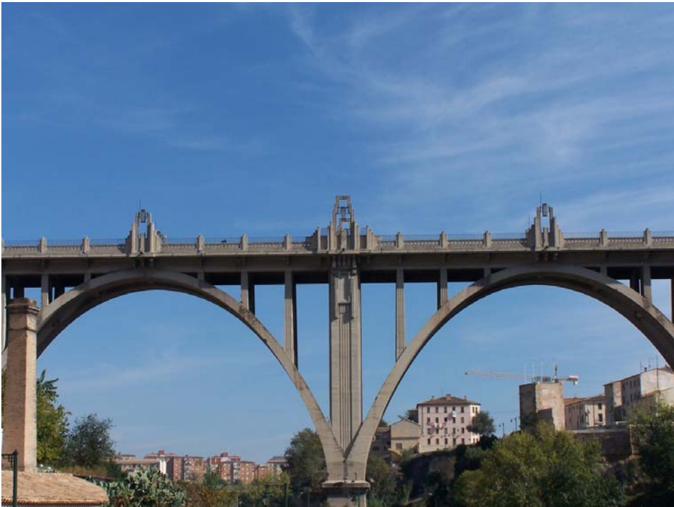
Fig.342 Detalle de una de las pilastras centrales del puente con el arranque de dos de los arcos. (JFPS 2009)
