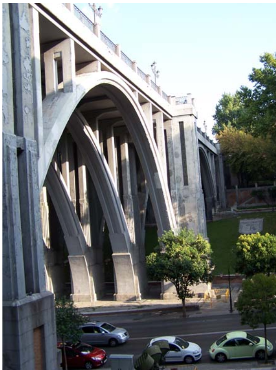
Fig. 163 Viaducto de Madrid. 1934. Vista lateral superior. (JFPS 2011)
