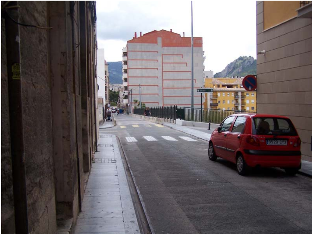
Fig. 406 Visión del tablero del Pontón de S. Jaime desde la calle S. Jaime. (JFPS 2012)
