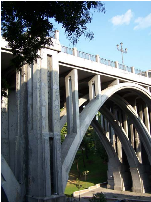
Fig. 159 Viaducto de Madrid. 1934. Vista lateral superior. Detalle. (JFPS 2011)
