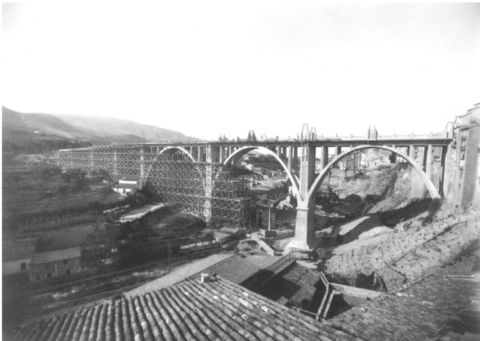
Fig. 221 Puente de San Jorge en construcción. Alcoy Vista del desmontado de la cimbra desde aguas arriba. (JN)
