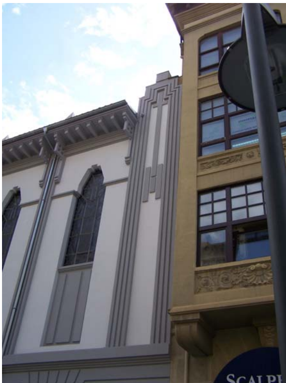
Fig. 250 Convento de las Hijas de María Inmaculada. 1924. Detalle del elemento de unión en la medianera de la Av. De Roncesvalles. (JFPS 2011)
