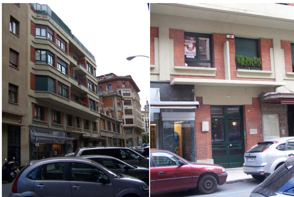
Fig. 311 y 312 Edificio de viviendas en la calle García Castañón, 1. Pamplona. 1932. (JFPS 2011)
