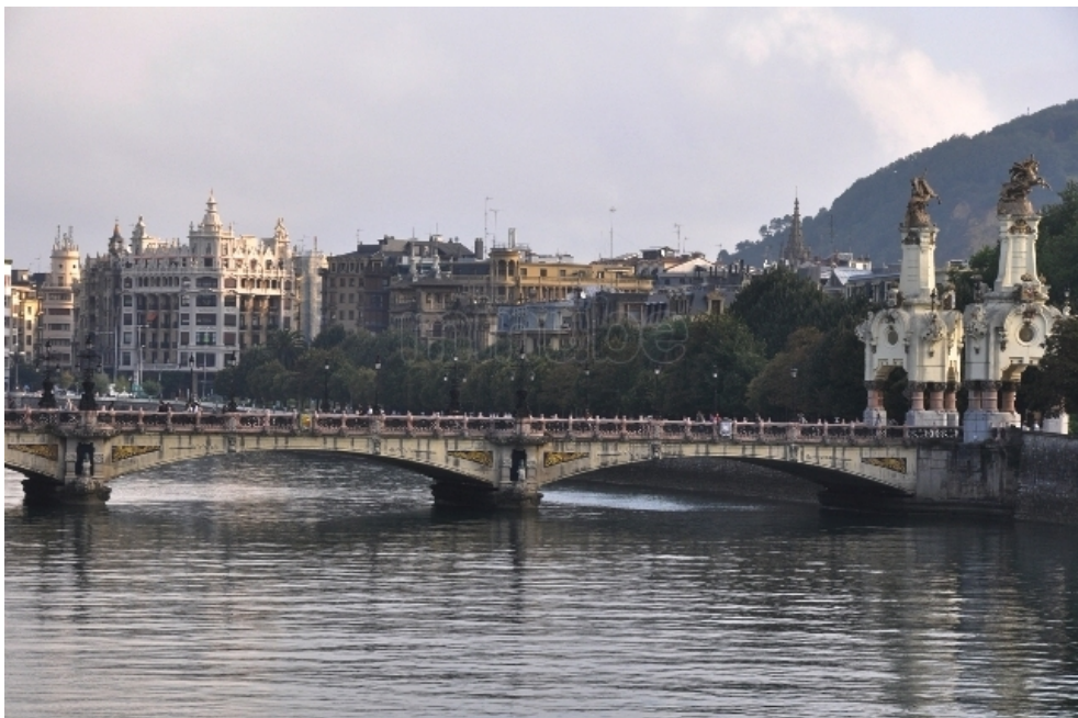
Fig. 118 Puente de María Cristina. San Sebastián. 1903-1905. Vista parcial desde aguas arriba (GE)
