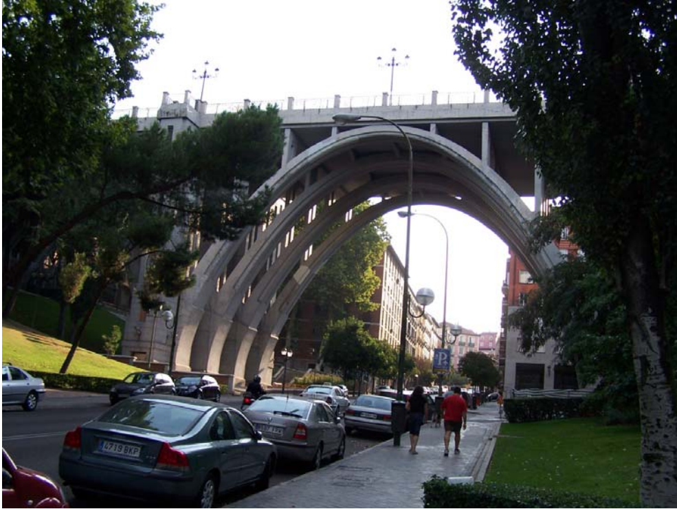
Fig. 160 Viaducto de Madrid. 1934. Vista de la parte inferior de la calle Segovia. (JFPS 2011)
