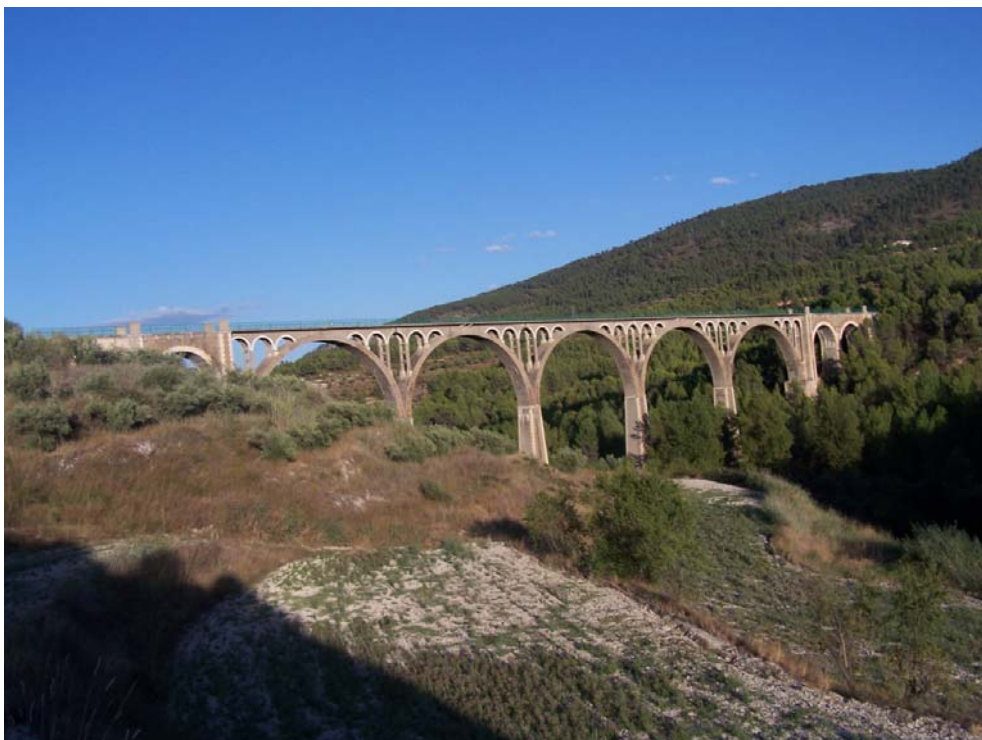
Fig. 151 Viaducto sobre el río Polop en el trazado del ferrocarril Alcoy-Alicante. 1926-1931. Vista lejana desde aguas arriba. (JFPS 2011)
