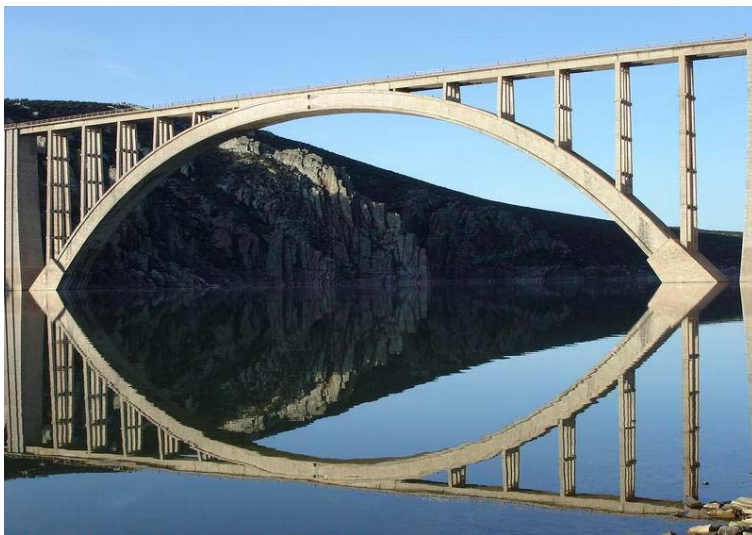
Fig. 139 Viaducto Martín Gil. Provincia de Zamora. 1929-1942. Vista lateral del puente. (TZ 2004-2008)
