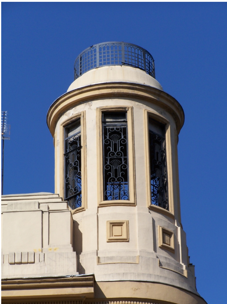
Fig. 59 y 60 Cine Callao. Fachada a la Gran Vía y Detalle. Madrid Luis Gutiérrez Soto, arquitecto. 1926. (JFPS 2011)
