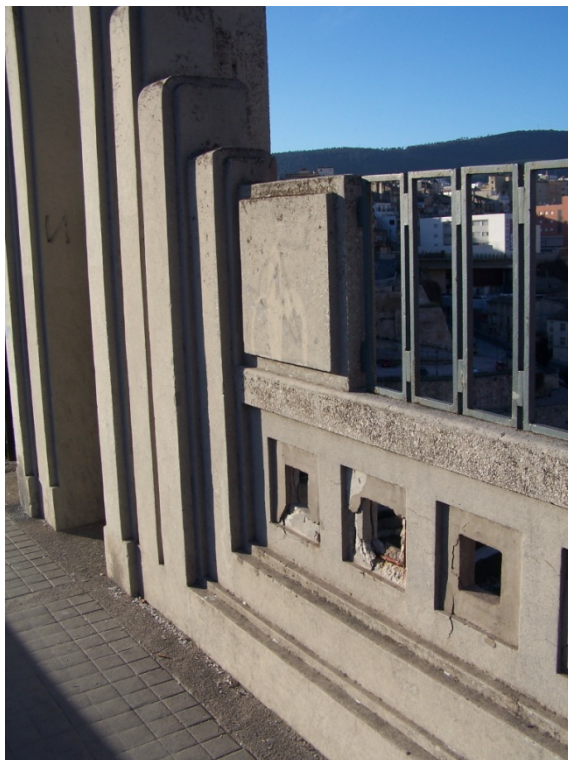
Fig. 363 Detalle de la pieza cuadrada del final de la cerrajería en el encuentro con la "columna decorativa" (JFPS 2012)
