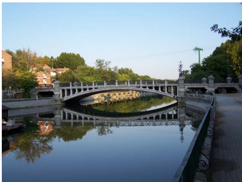
Fig. 122 Puente de la Reina Victoria. Madrid. 1907-1909. Vista del frente desde aguas abajo (JFPS 2011)
