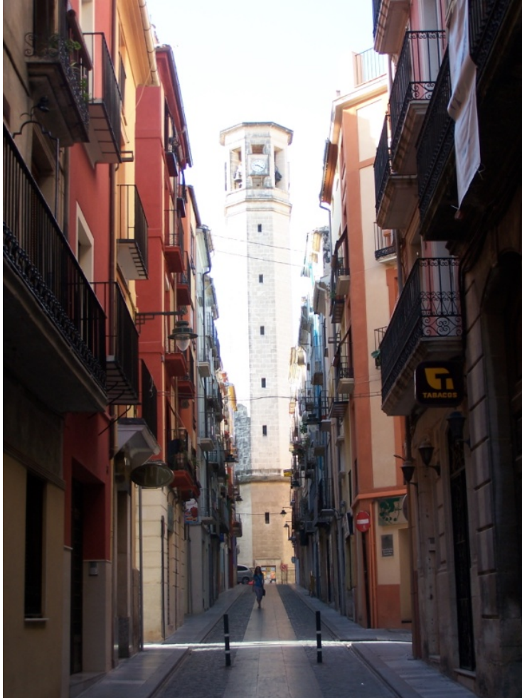
Fig. 633 Vista de la calle San Francisco (JFPS 2010)
