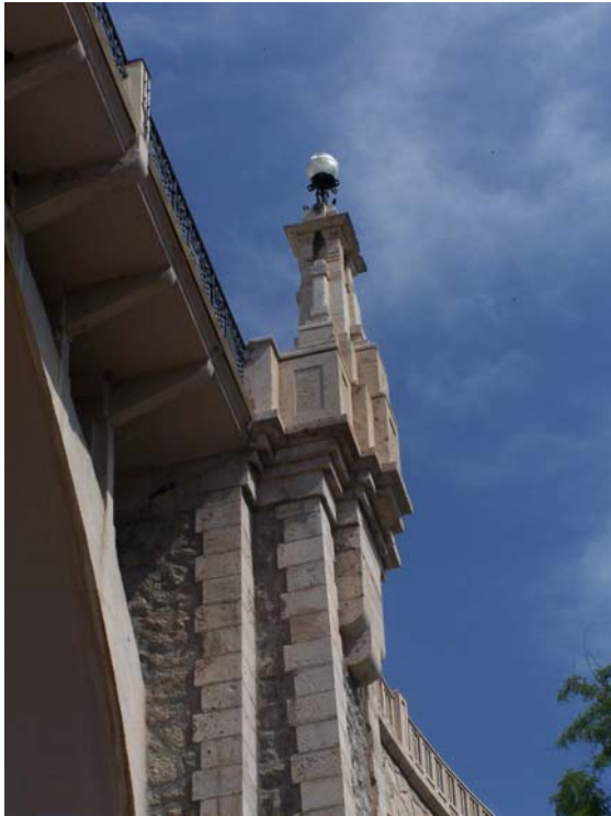
Fig. 134 Viaducto Fernando Hué. Teruel. 1920-1929. Detalle del exterior del remate de las pilas. (JFPS 2011)
