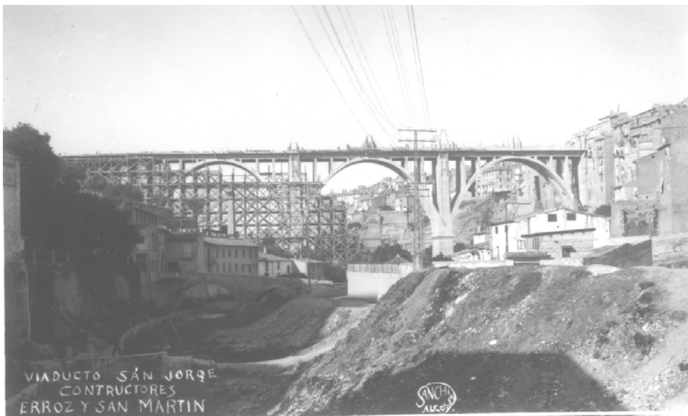
Fig. 217 Puente de San Jorge en construcción. Alcoy Mitad de la cimbra desmontada desde aguas arriba. (JN)
