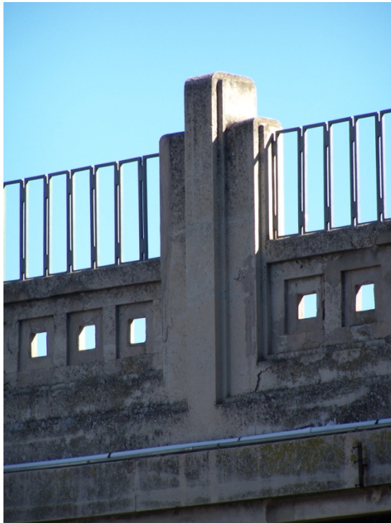
Fig. 360 Detalle del machón de las barandillas visto desde el exterior del Puente. (JFPS 2012)
