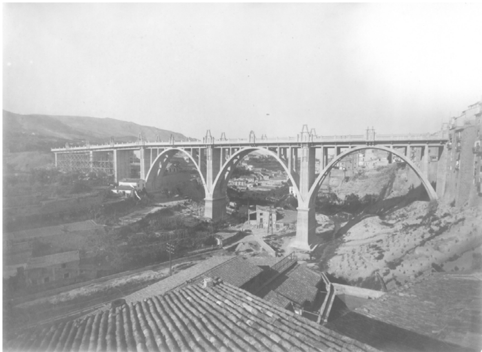
Fig. 223 Puente de San Jorge en construcción. Alcoy Vista del puente con la cimbra prácticamente desmontada desde aguas arriba. (JN)
