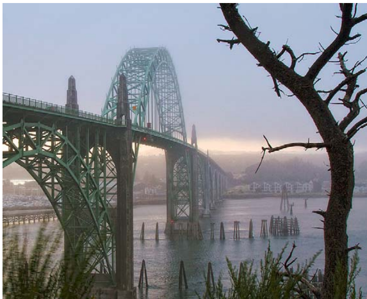
Fig. 165 y 166 Puente de St. John (Portland, Oregón, E. U. A.) 1931. David B. Steinman, ingeniería. (CV y WK)
