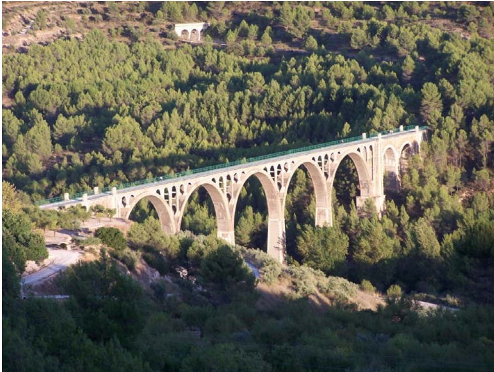
Fig. 150 Viaducto sobre el río Polop en el trazado del ferrocarril Alcoy-Alicante. 1926-1931. Vista lejana desde aguas arriba. (JFPS 2011)
