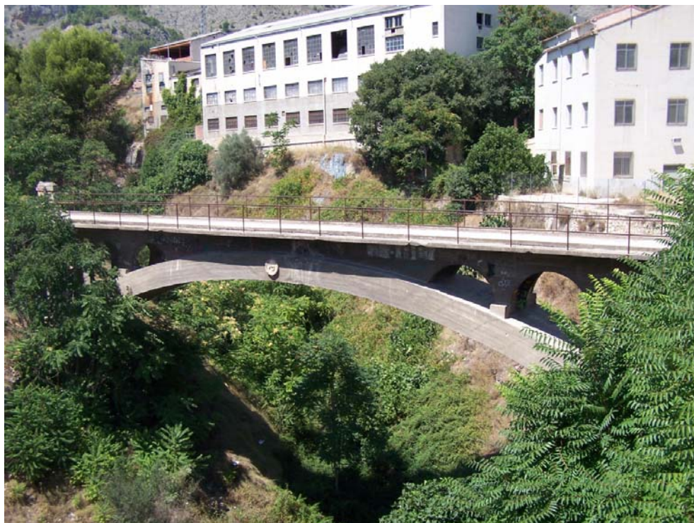
Fig. 145 Viaducto del Cint en el trazado del ferrocarril Alcoy-Alicante. 1926-1931. Vista desde aguas abajo. (JFPS 2011)
