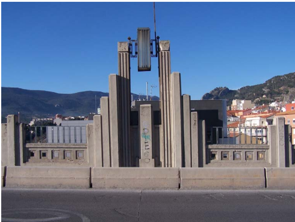
Fig. 359 "Columna decorativa" dispuesta sobre la clave de los arcos vista desde el interior del Puente. (JFPS 2012)
