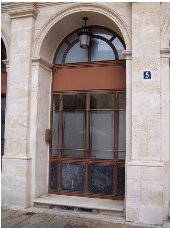
Fig. 574 Vista Actual parcial de la intervención en la Plaça de Dins
