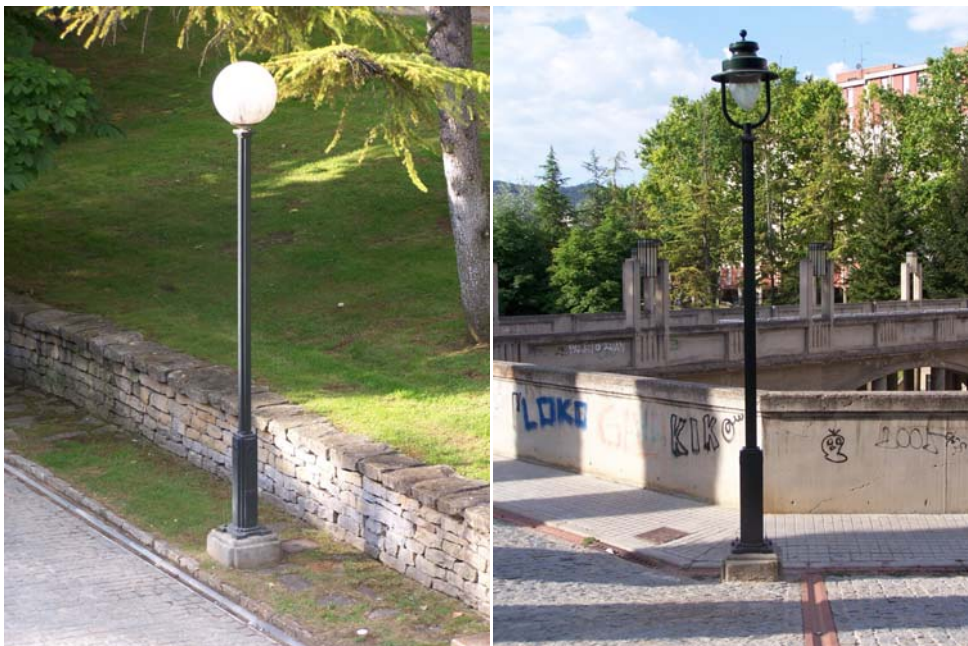
Fig. 590 y 591 Farola de báculo de 4m con luminaria esférica y adaptación a la luminaria Socelec (JFPS 2010)
