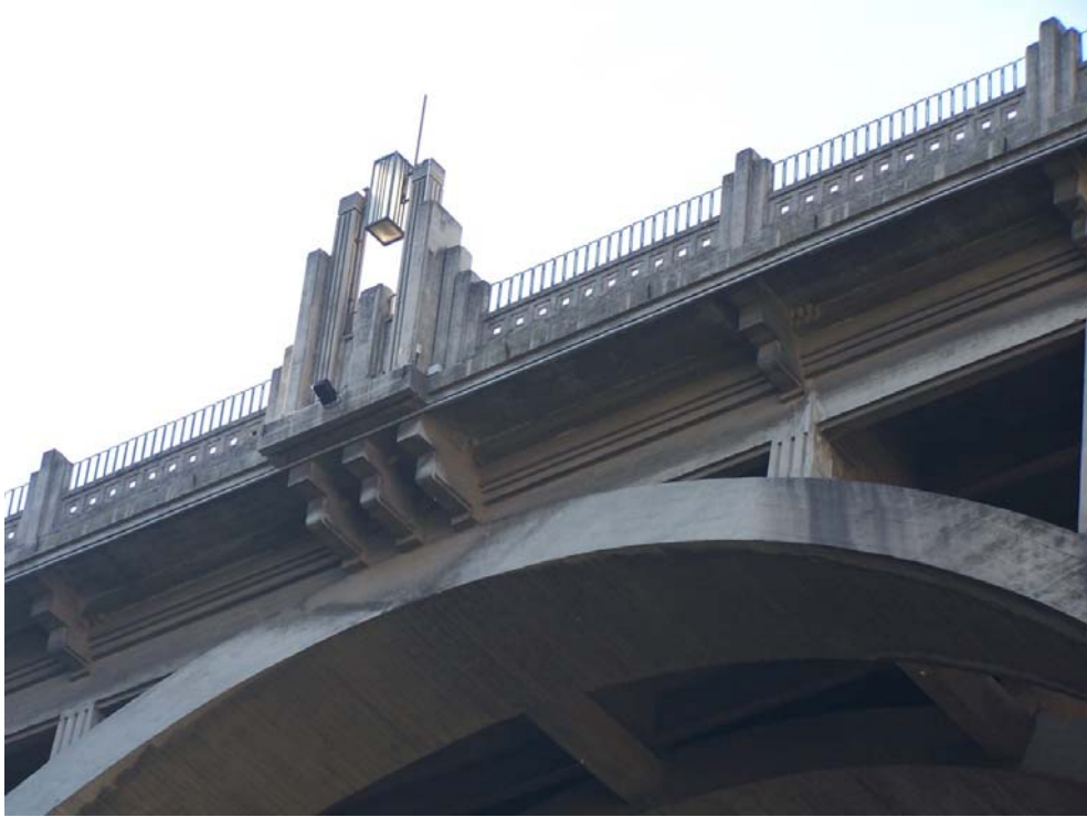
Fig. 358 "Columna decorativa" dispuesta sobre la clave de los arcos vista desde el exterior del Puente. (JFPS 2009)
