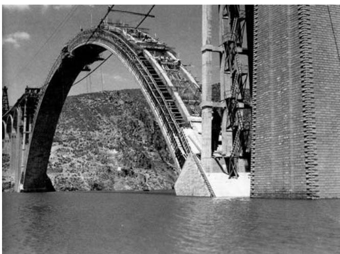
Fig. 143 Viaducto Martín Gil. Provincia de Zamora. 1929-1942. Imagen histórica de la construcción de la cimbra. (TZ)
