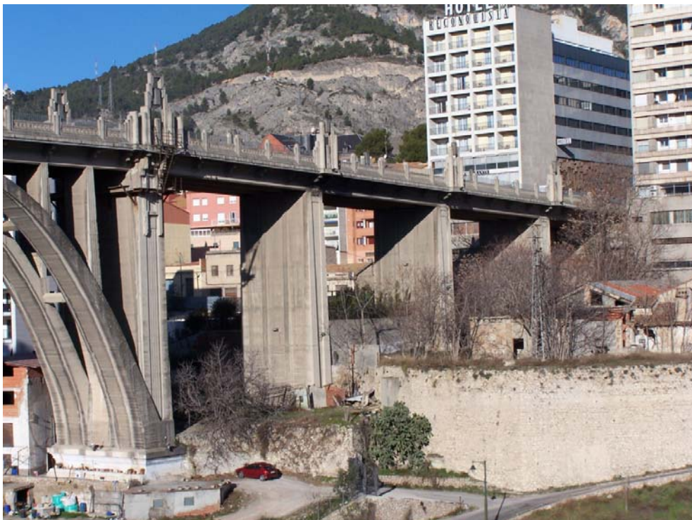
Fig.347 El tramo apilastrado en la zona del estribo izquierdo (JFPS 2012)
