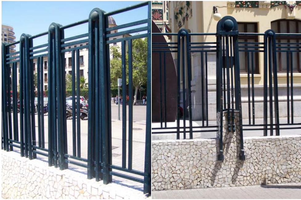
Fig. 629 y 630 Detalles del cerramiento de la Estación del Norte de Valencia. Demetrio Ribes, arquitecto (JFPS 2010)
