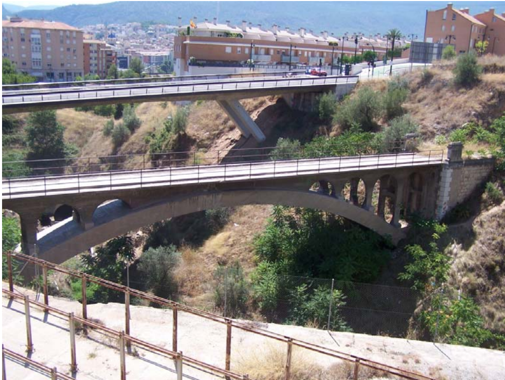
Fig. 146 Viaducto del Cint en el trazado del ferrocarril Alcoy-Alicante. 1926-1931. Vista desde aguas arriba. (JFPS 2011)
