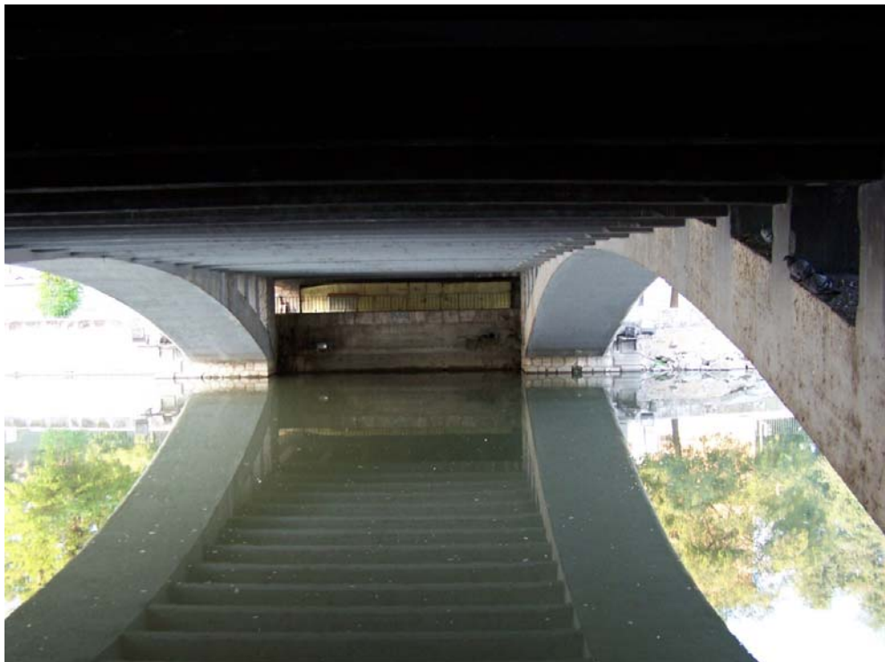
Fig. 125 Puente de la Reina Victoria. Madrid. 1907-1909. Vista desde el interior del paso de la avenida izquierda. (JFPS 2011)
