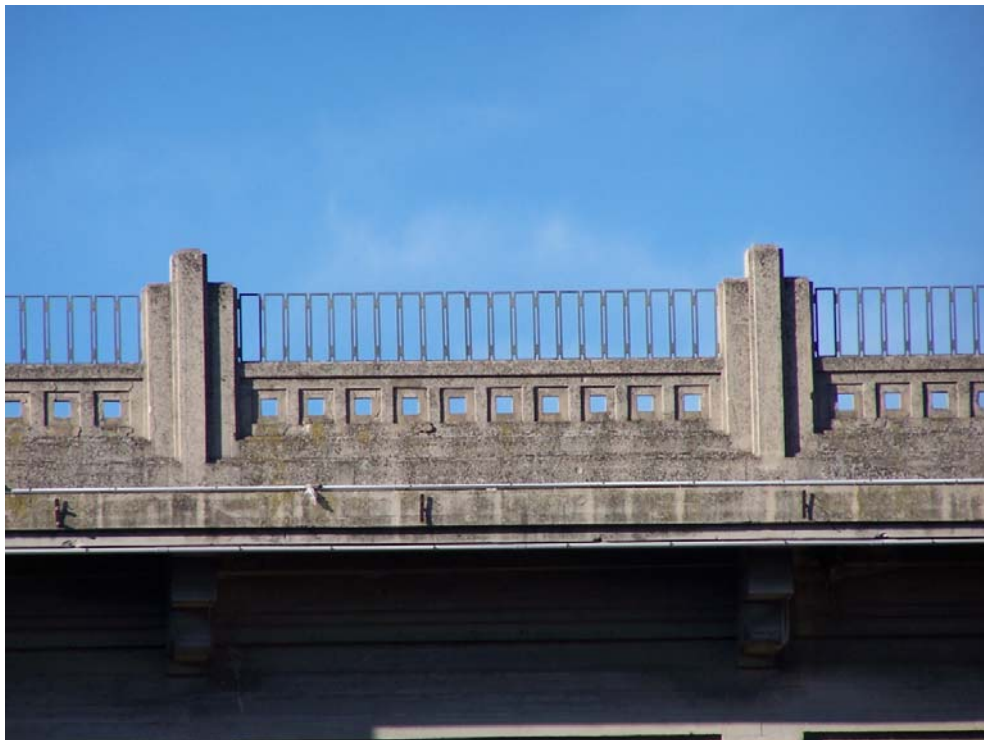
Fig. 361 Detalle del módulo de barandilla visto desde el exterior del Puente. (JFPS 2012)
