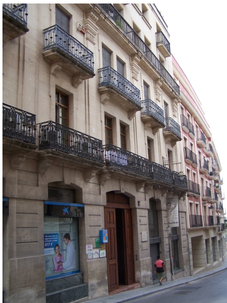
Fig. 505 Reforma de la Fachada del antiguo Hostal de la Viuda. C/ Gonzalo Barrachina. Alcoy Vicente Pascual Pastor, arquitecto. 1930. (JFPS 2012)
