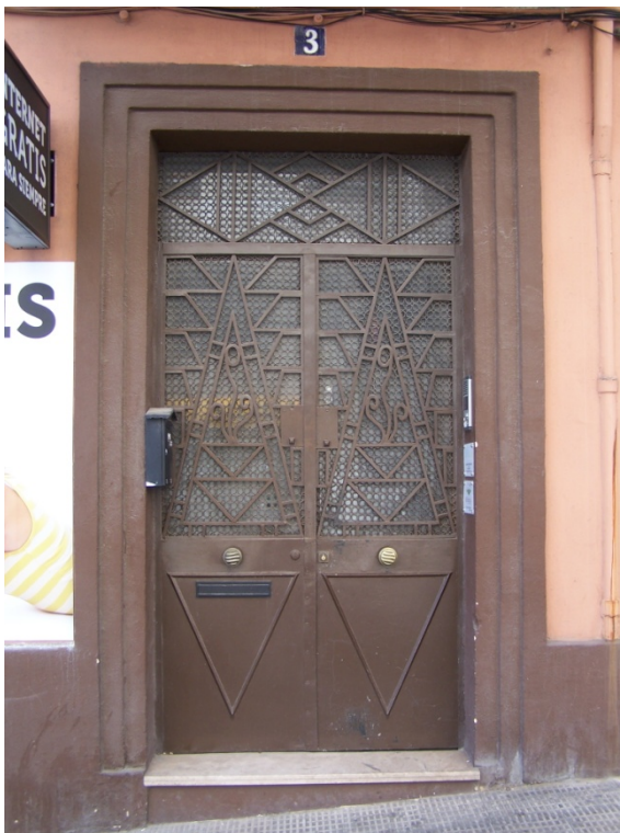
Fig. 466 Puerta de acceso al edificio de la calle Góngora, 3. Alcoy Joaquín Aracil Aznar, arquitecto. 1935 (JFPS 2012)
