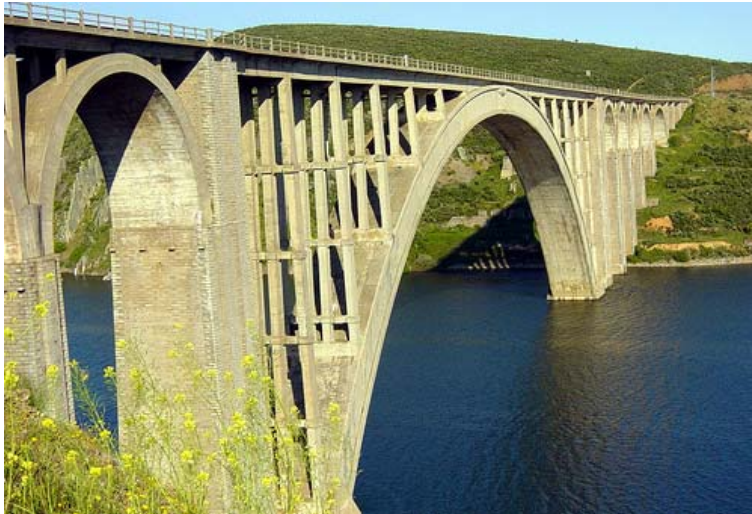
Fig. 138 Viaducto Martín Gil. Provincia de Zamora. 1929-1942. Vista lateral del puente. (TZ 2004-2008)
