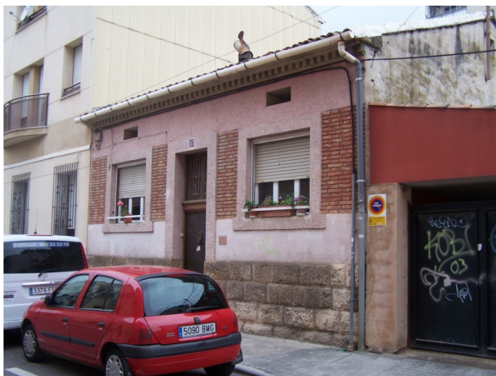
Fig. 526 Vivienda unifamiliar en la calle Pintor Cabrera, 107. Alcoy J. Aracil Aznar, arquitecto (AMA Expte. 7555/073 octubre 1933) (JFPS 2011)
