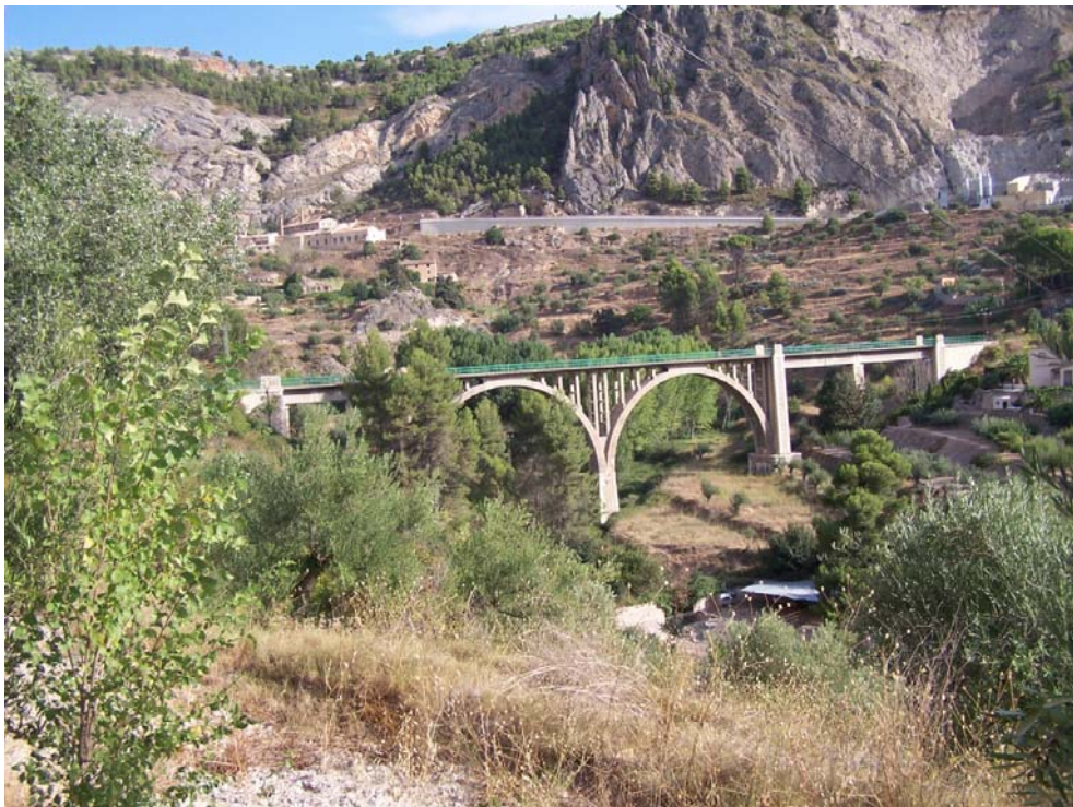
Fig. 149 Viaducto sobre el río Barxell en el trazado del ferrocarril Alcoy-Alicante. 1926-1931. Vista desde aguas abajo. (JFPS 2011)
