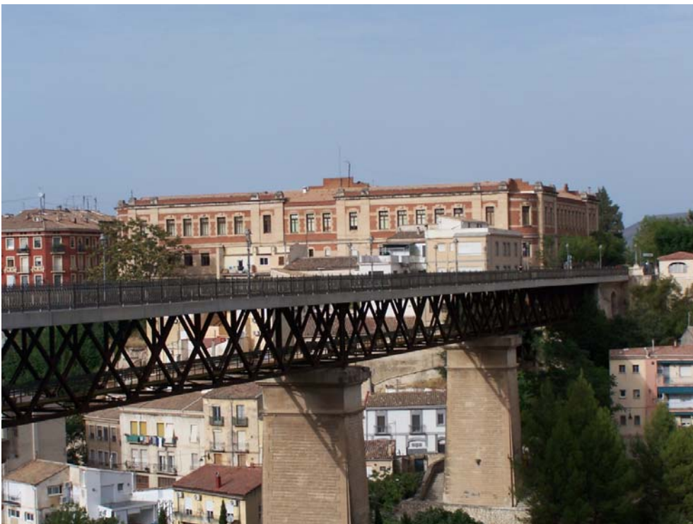
Fig. 478 Esquina y fachada posterior del edificio de las Escuelas Industriales de Alcoy
