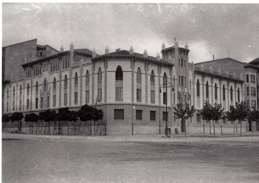
Fig. 247 Convento de las Hijas de María Inmaculada. 1924. Vista del edificio tal y como se construyó. (VE)
