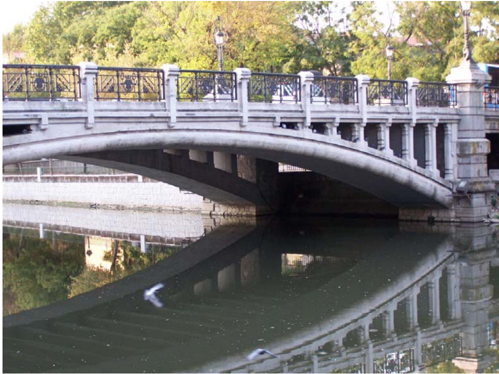
Fig. 124 Puente de la Reina Victoria. Madrid. 1907-1909. Vista parcial del frente desde aguas arriba (JFPS 2011)
