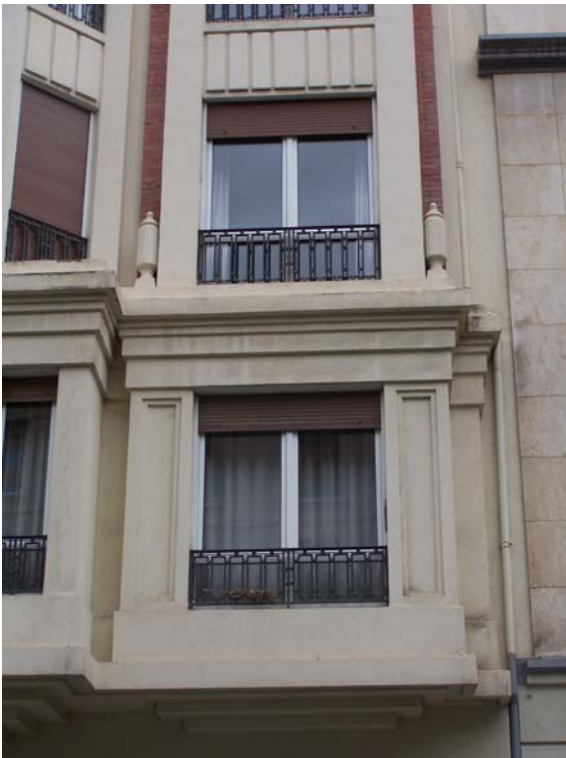
Fig. 261 Edificio en la Av. Roncesvalles, 8. Pamplona. 1928. Detalle de los miradores extremos. (JFPS 2011)
