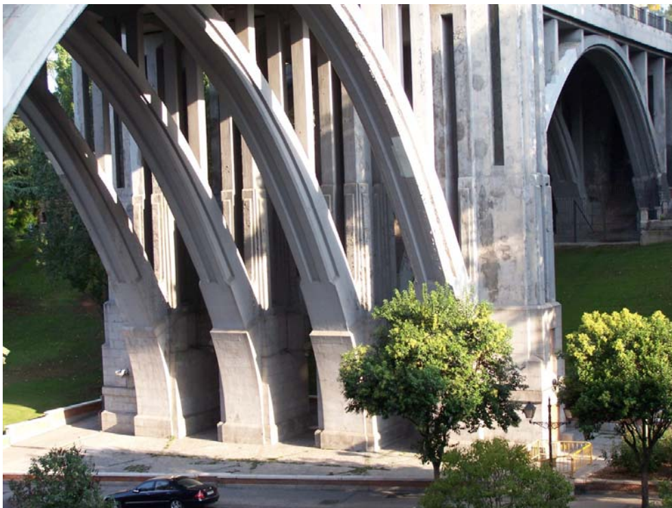
Fig. 164 Viaducto de Madrid. 1934. Detalle de los arranques de los arcos y de las pilas intermedias. (JFPS 2011)
