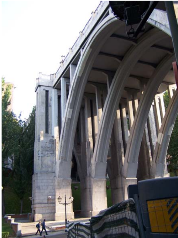
Fig. 162 Viaducto de Madrid. 1934. Vista inferior de los arcos y del tablero. (JFPS 2011)
