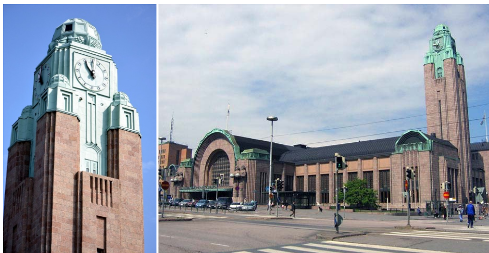
Fig. 652 y 653 Estación ferrocarriles de Helsinki (Finlandia) 1904-1914 Eliel Saarinen, arquitecto (SC y TA)
