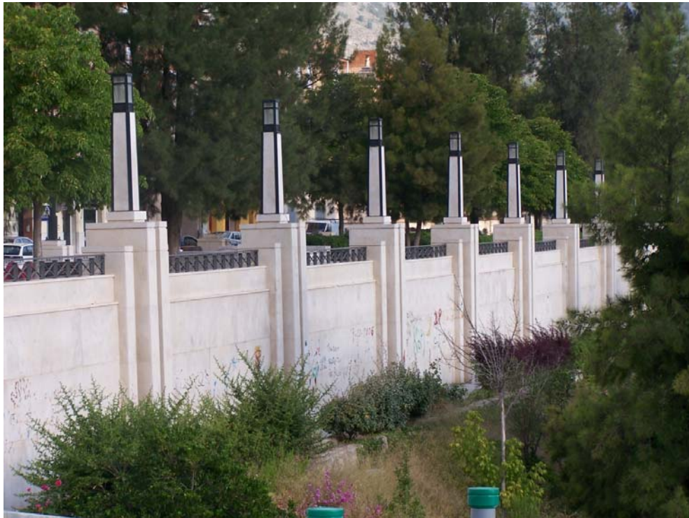
Fig. 623, 624 y 625 Detalles del cerramiento del Parque del Viaducto (JFPS 2010)
