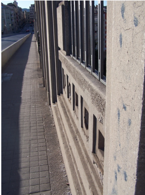
Fig. 362 Detalle los escalonamientos de la base del módulo de barandilla visto desde el interior del Puente. (JFPS 2012)
