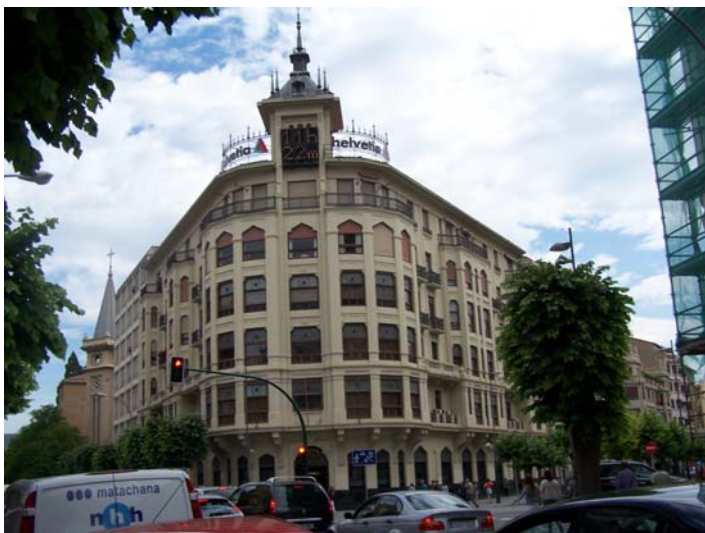
Fig. 243, 244, 245 y 246 Edificio "La Vasco Navarra". 1924-26 Detalles de elementos de cerrajería, puerta lateral a la Av. De S. Ignacio y Vista del estado actual del edificio. (JFPS 2011)
