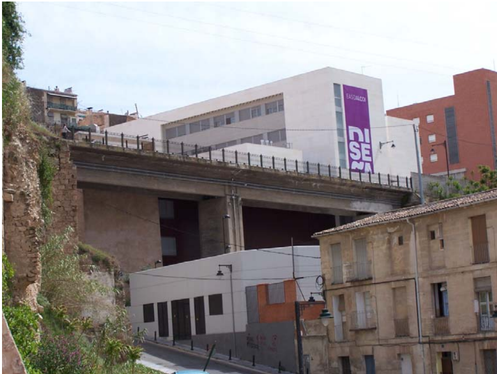
Fig. 393 Vista del Pontón de San Jaime desde aguas abajo. Alcoy. (JFPS 2012)
