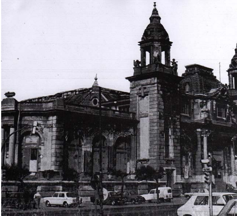
Fig. 235 Edificio Gran Kursaal. San Sebastián. 1921. Detalle de la parte izquierda de la fachada principal. (NF)
