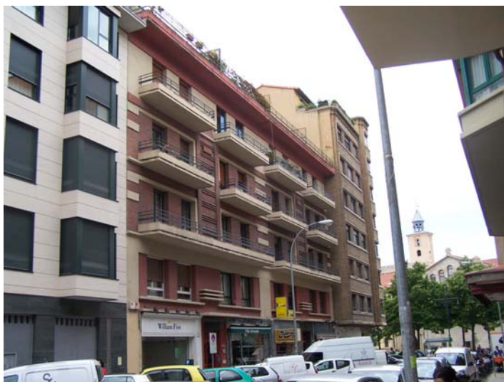
Fig. 313 Edificio de viviendas en calle García Castañón 2 y 4. Pamplona. 1932 (JFPS 2011)
