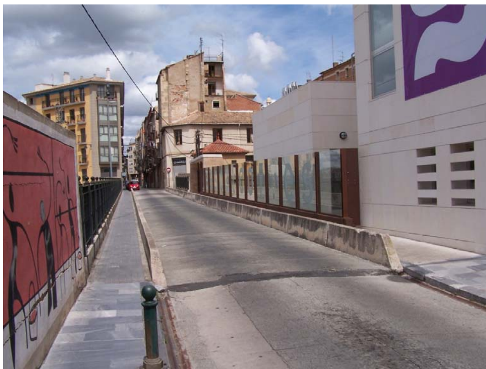
Fig. 409 Vista del tablero del Pontón desde la llegada a la plaza del Pintor Emilio Sala. Obsérvese la alineación del nuevo edificio de l'Escola d'Art. (JFPS 2012)
