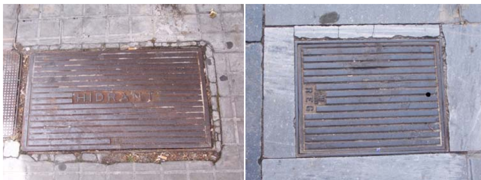
Fig. 646 y 647 Vista de algunas tapas de registro de distintas instalaciones (JFPS 2010)
