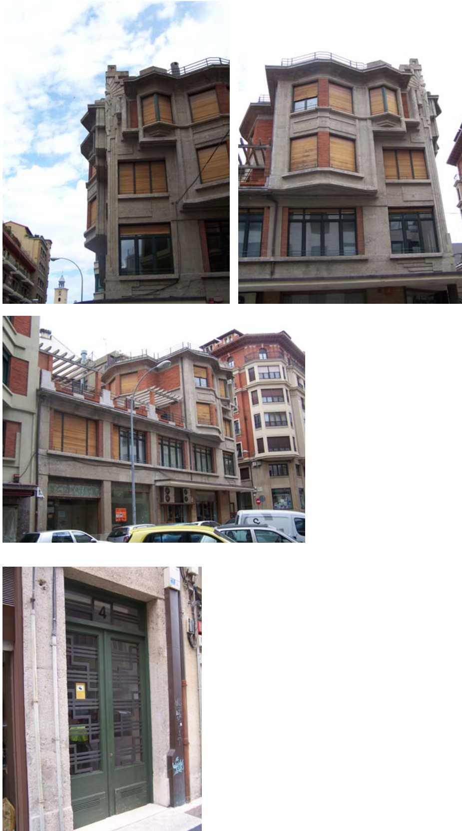
Fig. 291, 292, 293 y 294 Detalles del Edificio de viviendas en la calle Fernández Arenas ,4, esquina calle García Castañón. Pamplona. 1930. (JFPS 2011)
