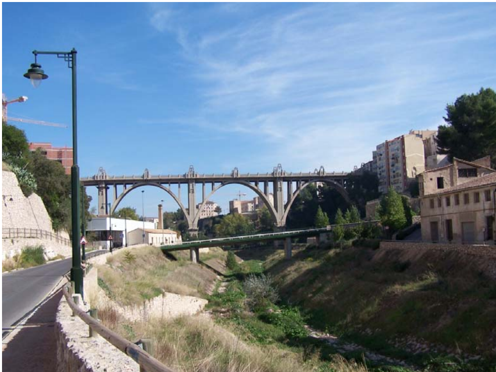
Fig. 331 Vista Sur del puente de San Jorge desde el nivel del río Riquer. (JFPS 2009)
