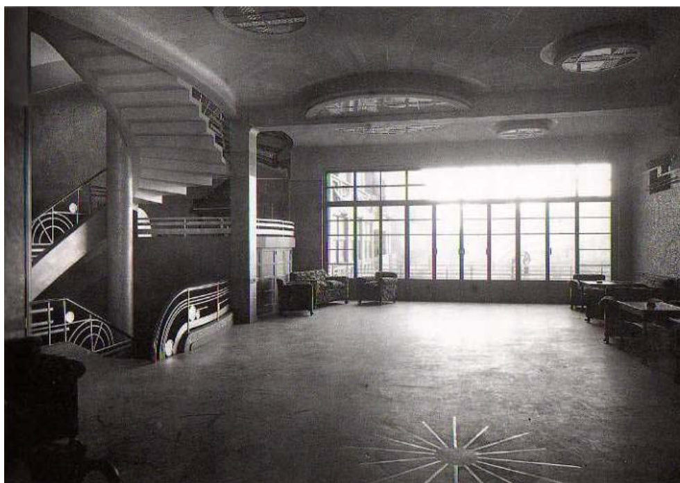
Fig. 301 Casino Eslava, Plaza del Castillo, 16. Pamplona. 1931. Salón de baile en planta primera. Véase la posición de la orquesta en el nivel del descansillo de la escalera. (VE)
