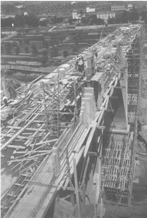
Fig. 218 Puente de San Jorge en construcción. Alcoy Obsérvense los trabajos de encofrado de las barandillas y columnas. (JN)
