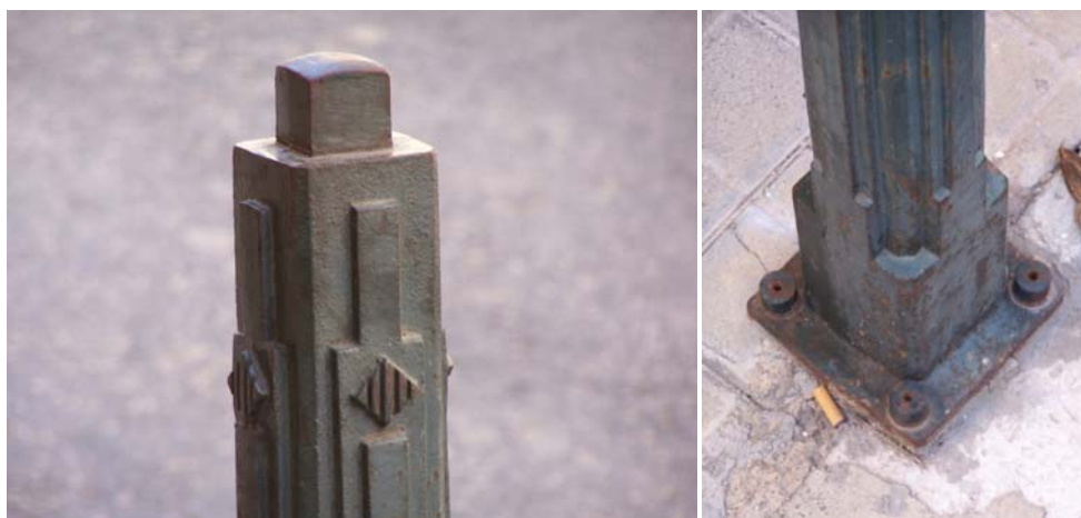
Fig. 654 y 655 Detalle del remate y de la base del bolardo modelo Alcoy (JFPS 2010)
