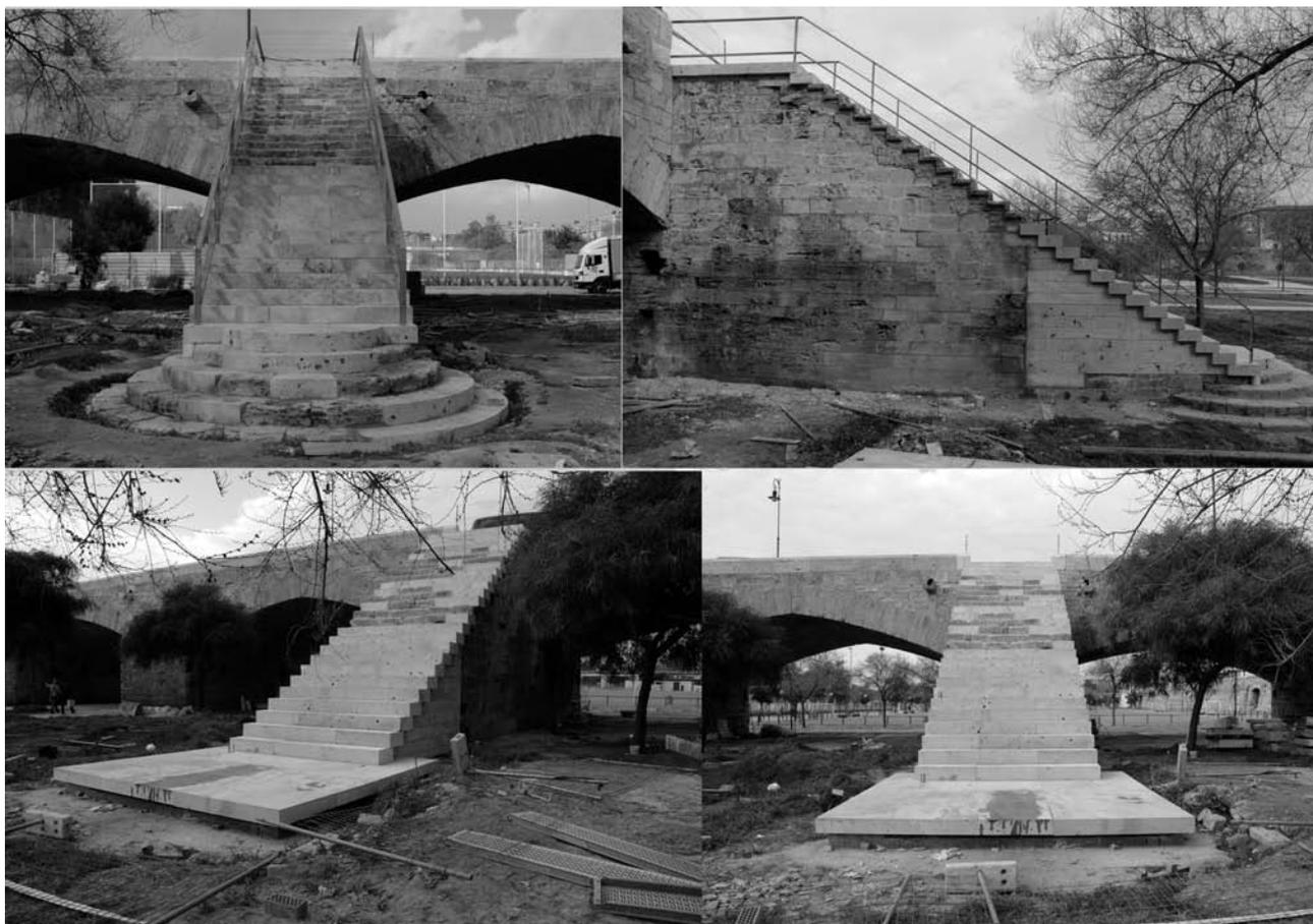
Figura 10 Reconstrucción de las escaleras Puente de la Trinidad
