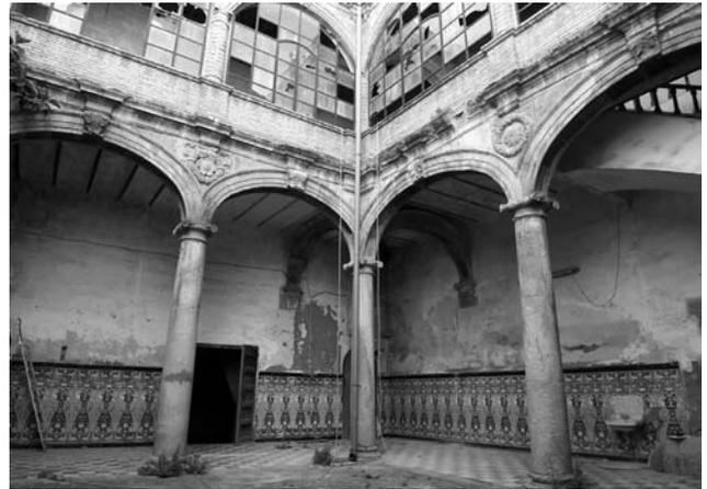
Figura 3 Sobre la arquería renacentista se levanta a principios del XX la galería superior de ladrillo.
