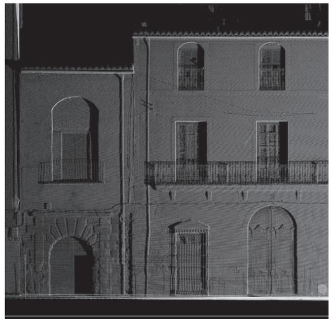
Figura 10 Fachada principal y portada. Nube de puntos realizado por el escáner-láser 3D
