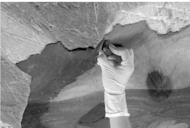
Figura 4. Detalle del proceso de limpieza en seco con Wishab®
