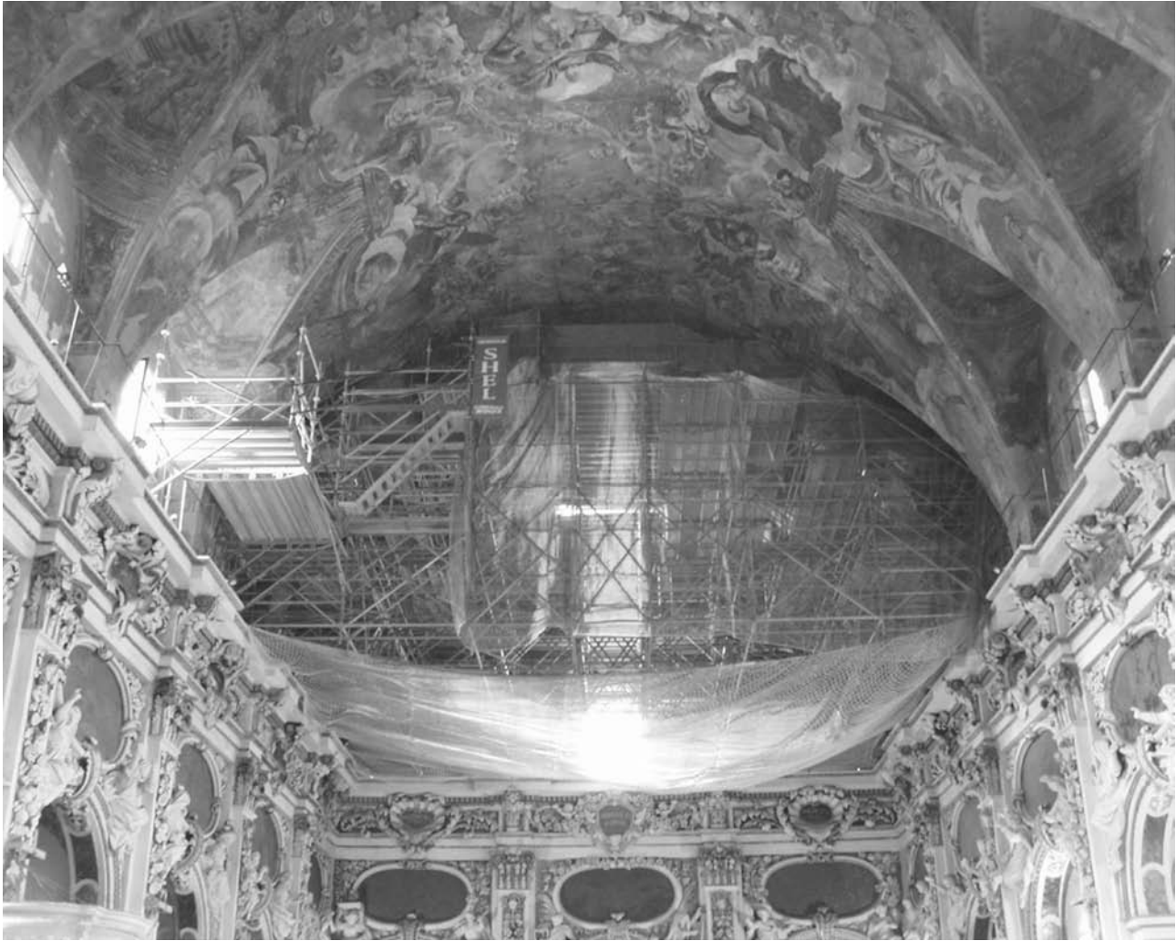
Figura 1. Aspecto general de la bóveda de la Iglesia de los Santos Juanes
