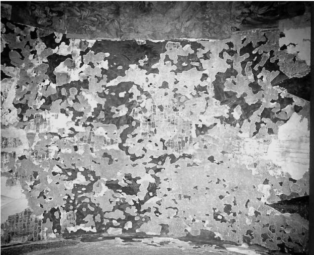
Figura 2. Estado inicial de la zona de bóveda en la que se está interviniendo
