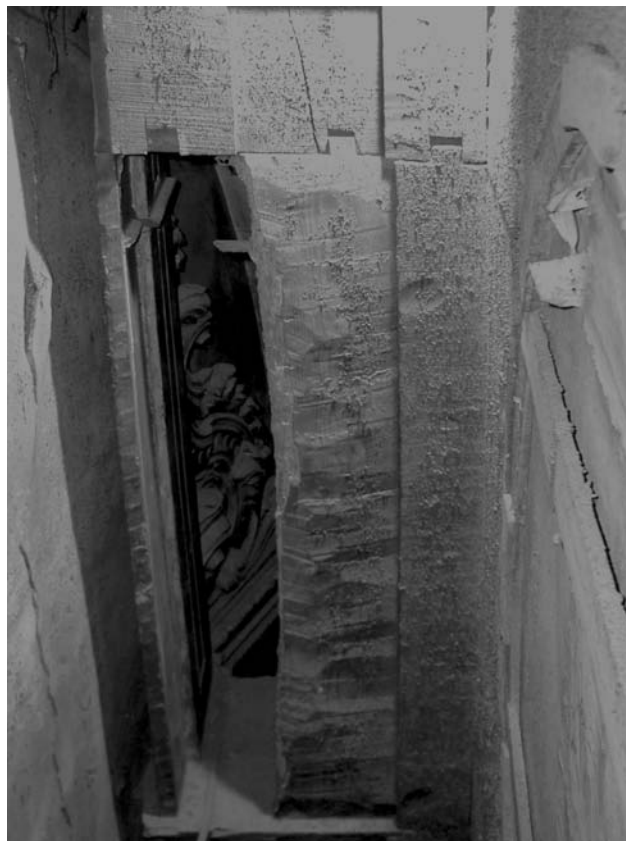
Figura 4: detalle de las uniones de paneles en la trasera de un retablo barroco
