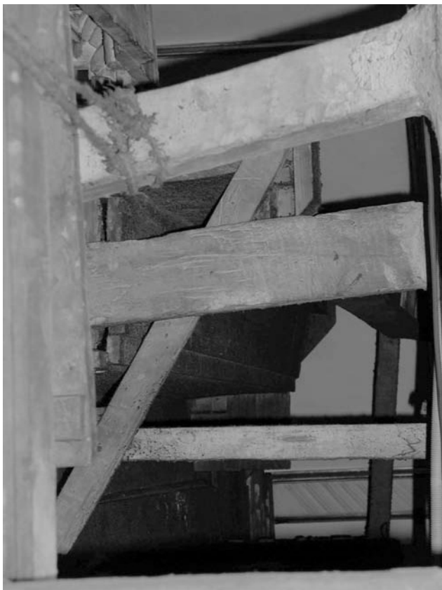
Figura 3: detalle de tirantes de madera en la trasera de un retablo barroco
