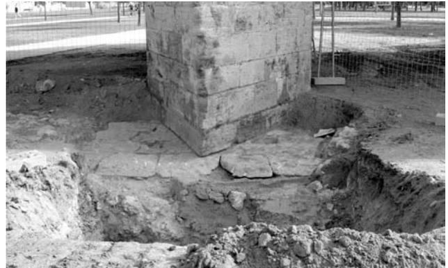
Figura 17. Cata arqueológica sobre la cimentación del puente de Trinidad
