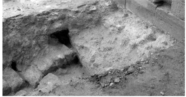
Figura 8. Restos de dovelas del primitivo puente de piedra anterior al de Serranos, construido en 1349 y destruido parcialmente en las riadas de 1358, 1408 y 1427
