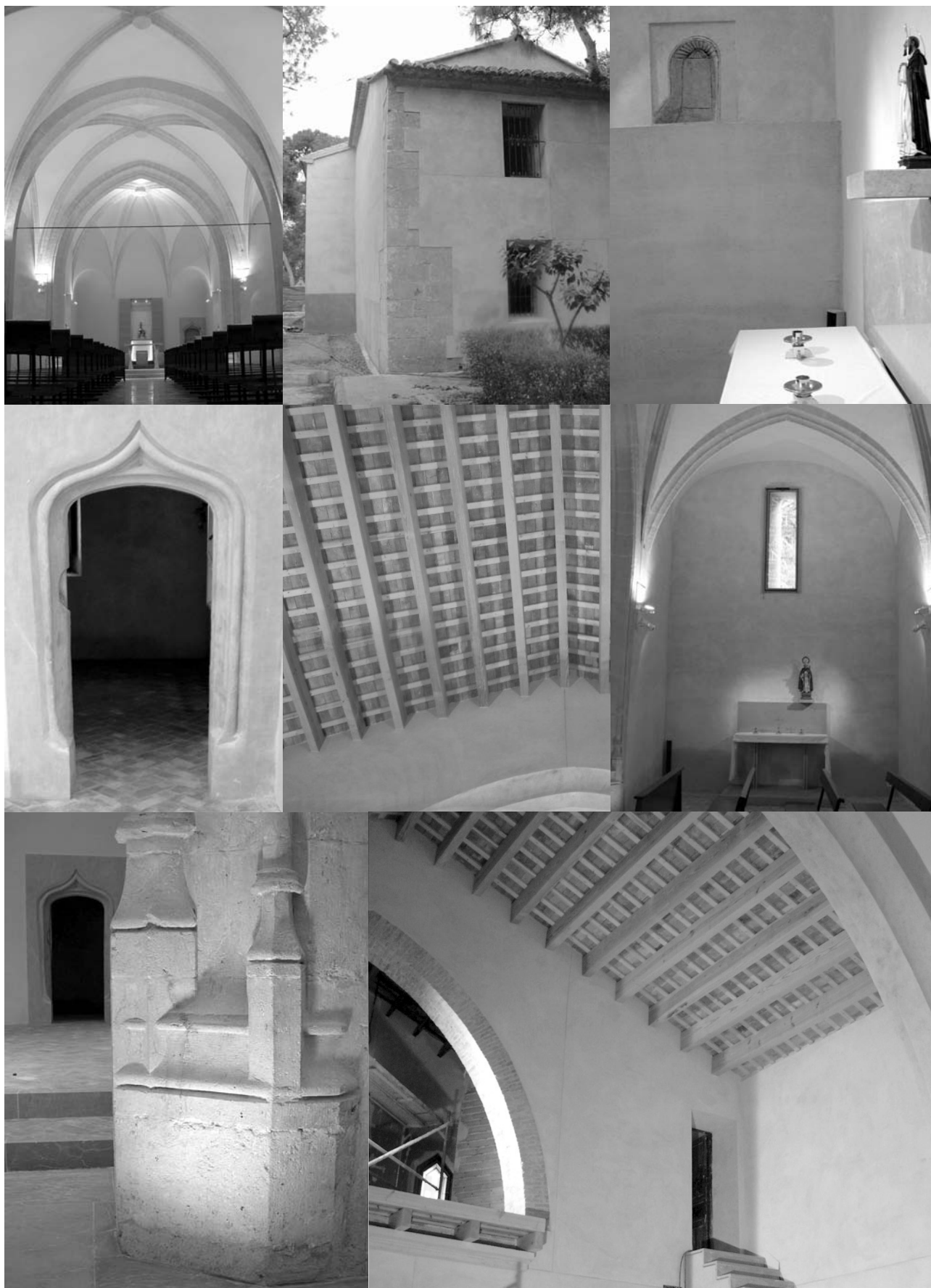
Figura 8. Detalles de acabados
