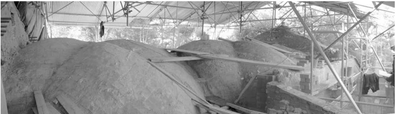
Figura 6. Restauración de las bóvedas
