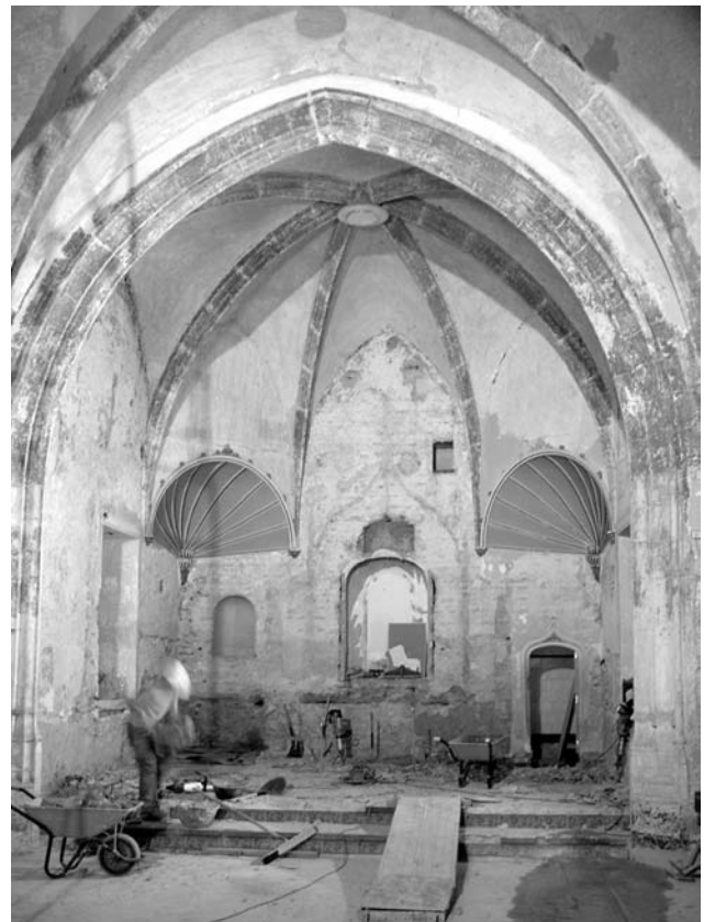
Figura 4. Estado intermedio de la obra de restauración: nave principal
