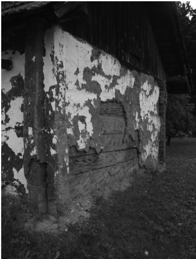
Figura 3. Austria, Heiligenbrunn: detalle de revestimiento en tierra en una construcción tradicional (Vegas-Mileto)
