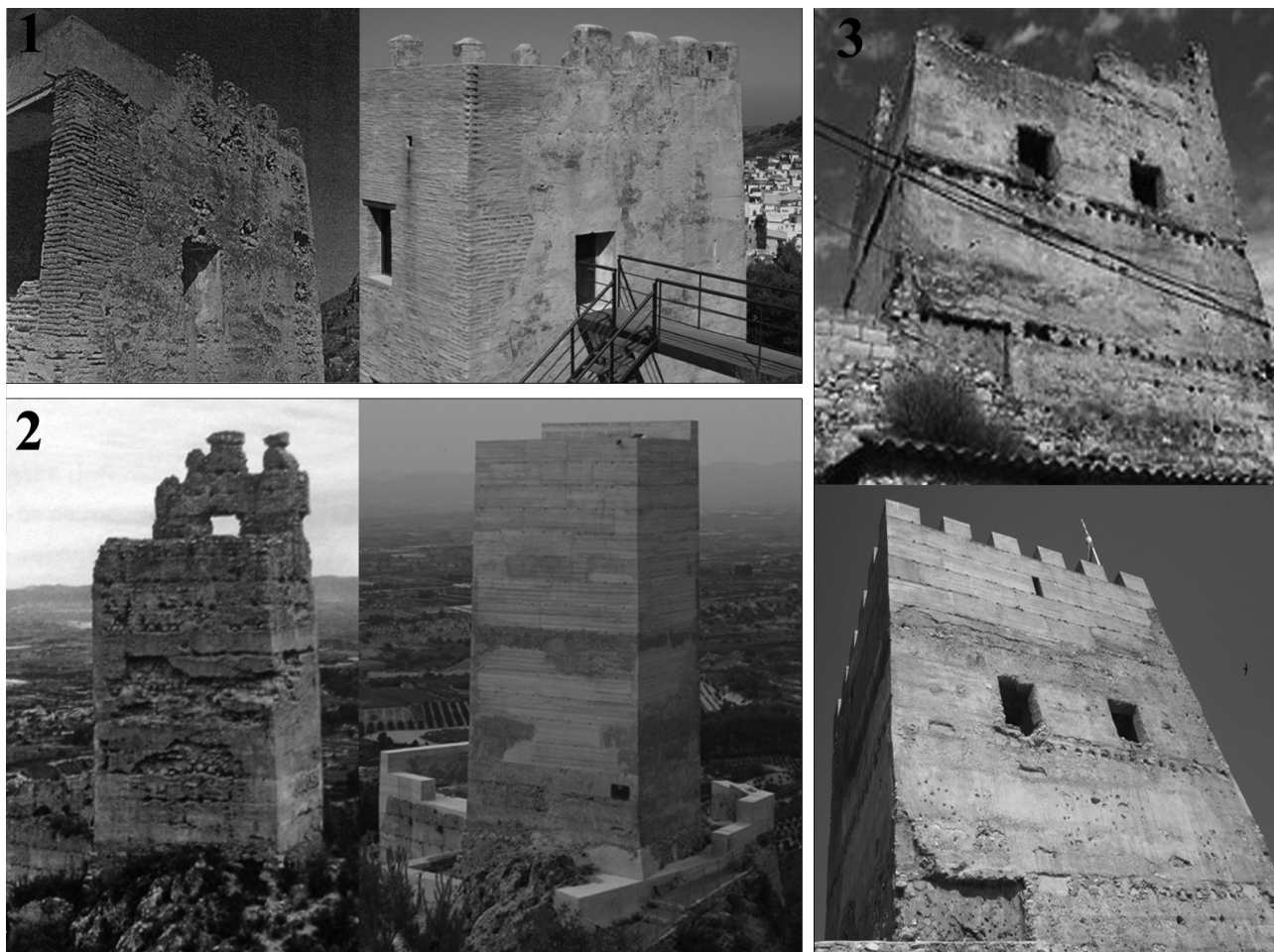
Figura 4. Imágenes del estado antes y después de las intervenciones llevadas a cabo en la Torre de la Reina Mora (1), en el Castillo de Carricola (2) y en la Torre de Sot de Chera (3)
