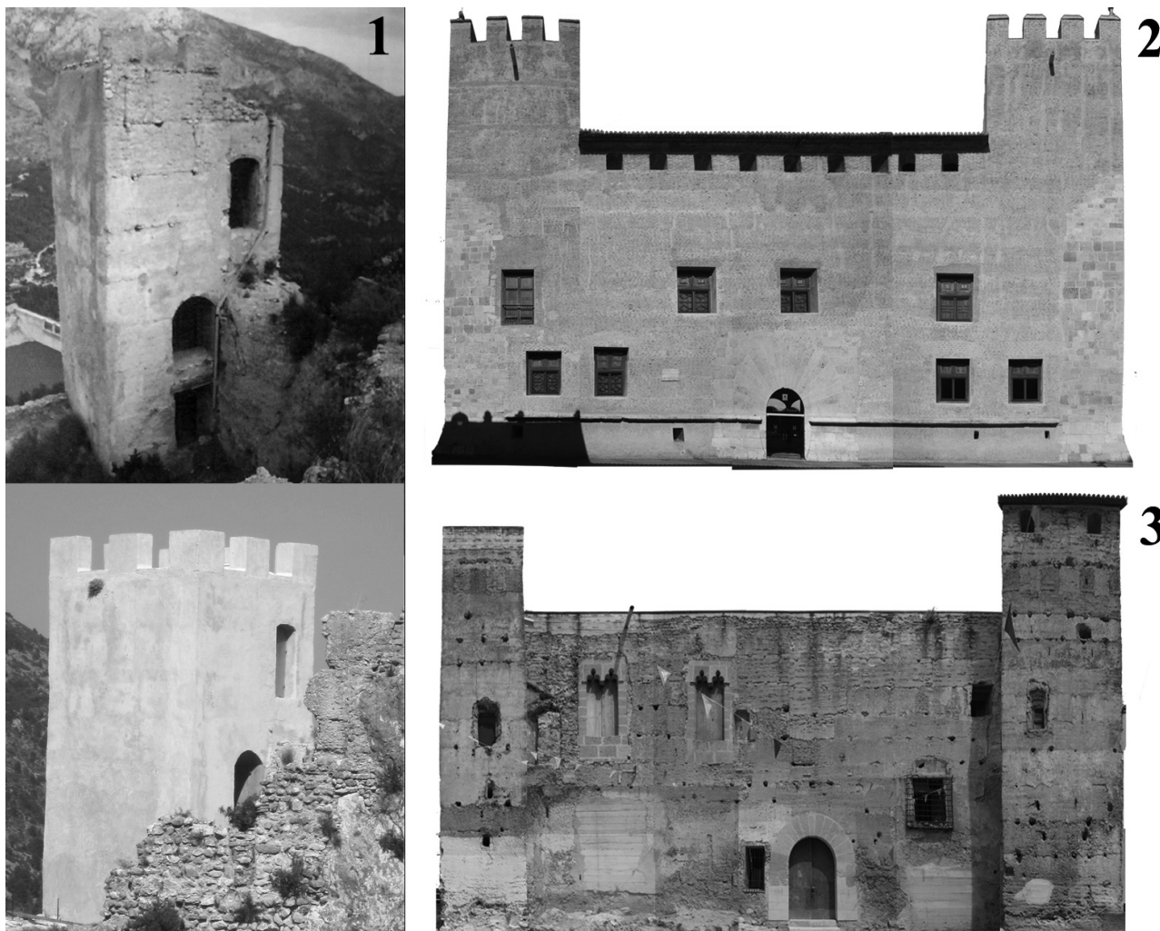
Figura 9: Fotos antes y después de la intervención en la Torre Vigia del Castell de Guadalest (1) y fotoplanos del Castillo de Alaquás (2) y del Palau Vell de Llutxent (3). La fotografía del estado antes de la intervención son reproducciones obtenidas en el Archivo correspondiente (Archivo de la Diputación de Alicante). Foto del estado actual y fotoplanos: Stefania Sanna.
