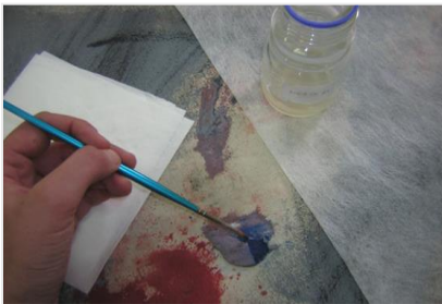
Fig. 250. Detalle consolidación puntual "a la gota" zona obra Peris y Alemany.
