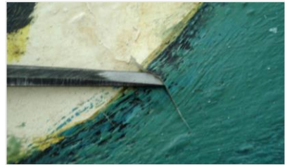
Fig. 221 y 222. Aplicación adhesivo por inyección y mediante espátula.
