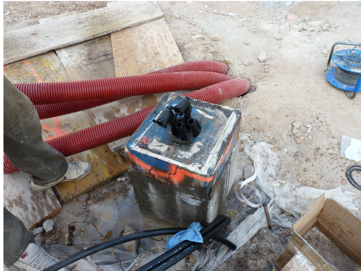
Figura 1.9: Elementos de un pilote termoactivo
