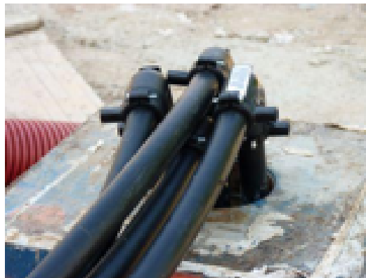
Figura 3.13: Conexión mediante codos a la tubería horizontal
