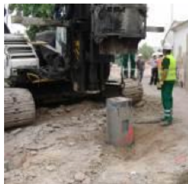
(d) Finalización primer tramo
