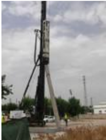
(a) Izado del pilote
