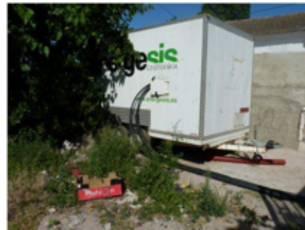
(d) Inst. generadora térmica
