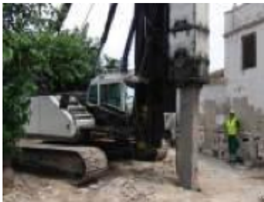
Figura 3.9: Proceso de hincado del segundo tramo
