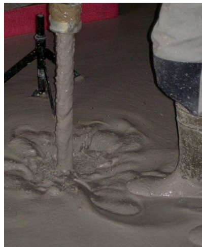
Figura 3.7 .Bombeado y aplicación mediante manguera
