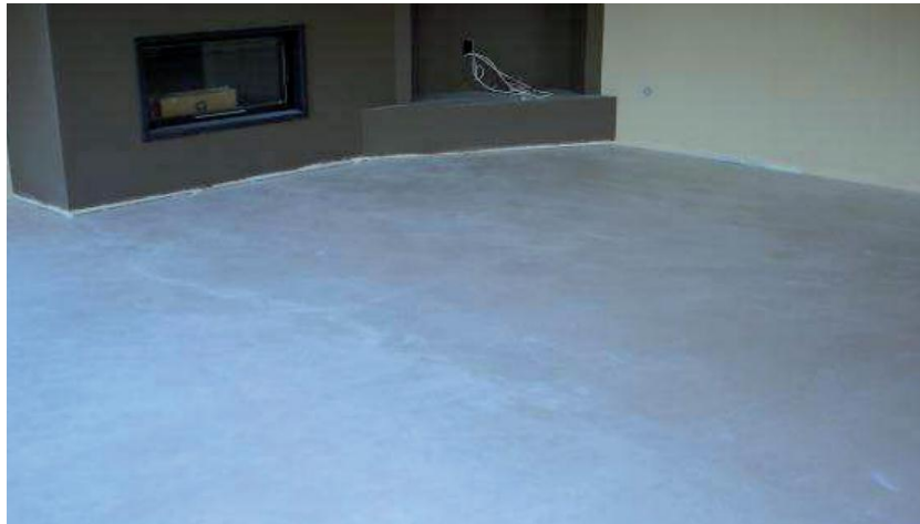
Figura 3.9. Acabado pavimento con mortero autonivelante
