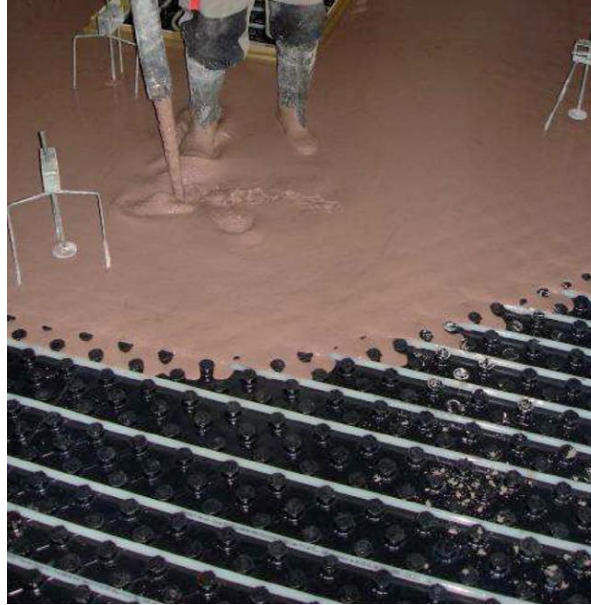
Figura 3.8. Aplicación por bombeo de mortero autonivelante con anhidrita
