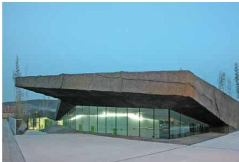
Figura 3.22. Edificio integrado en el paisaje gracias a su estructura mineral
