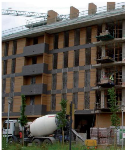
Figura 3.6. Transporte del mortero a obra
