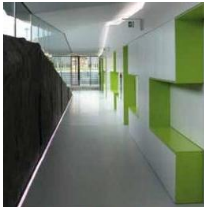
Figura 3.23. Acabado de suelo radiante con mortero autonivelante
