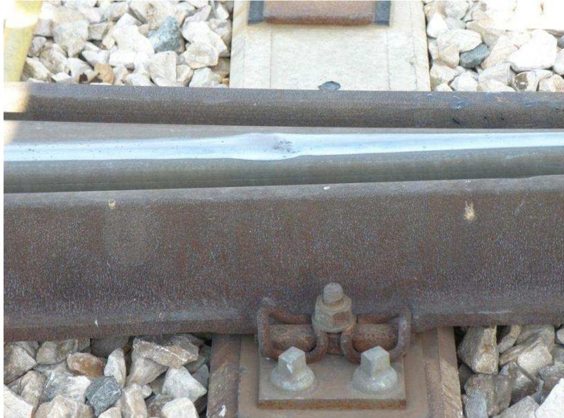
*Fig. 62. Plastificación de la cabeza del carril en la punta del corazón de un desvío. Sentido de avance del tren de izquierda a derecha.*
