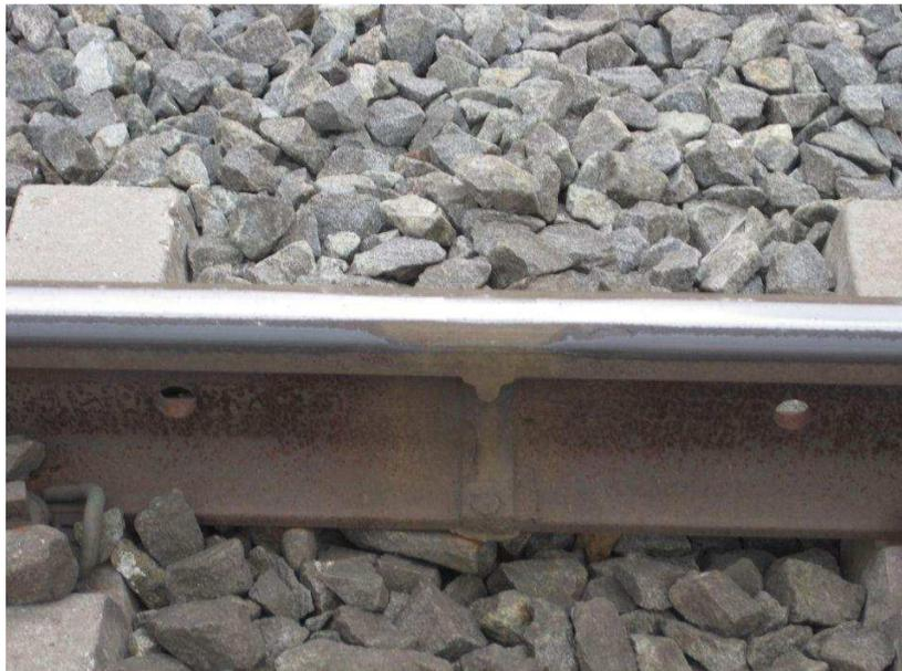
*Fig. 61. Junta soldada mediante soldadura aluminotérmica*
