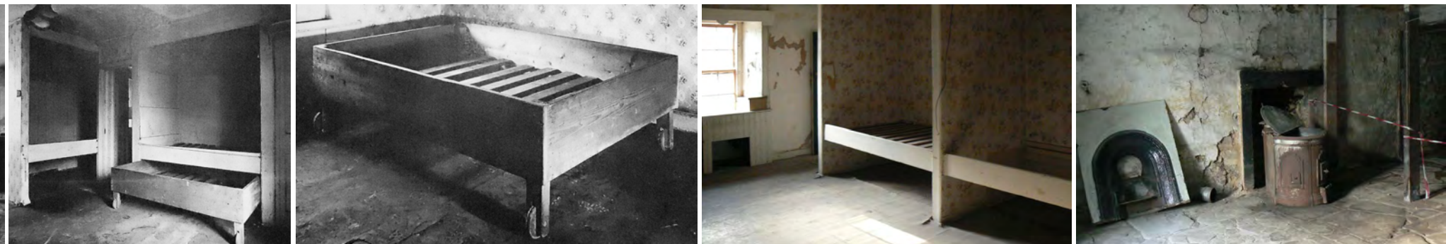
Figura nº 236. (abajo) 1: Dos 'Set-in bed' 'Box bed' o camas integradas instaladas en todas las casas de New Lanark junto con una 'Hurley bed' o cama deslizante. 1961. Rosedale Row, nº131. 2 y 3: 'Hurley bed' o cama deslizante. 1961. Long Row, nº12. (fuente: National Monuments Record of Scotland. NS84-SE.58) 4 y 5: Fotografías del estado actual de dos 'set-in bed' y hogar (fuente: New Lanark Search Room, Mill nº3)
