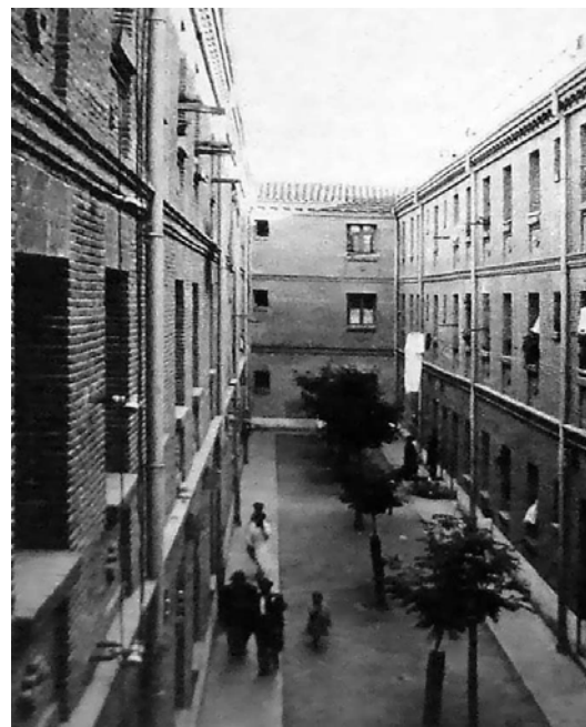
Figura nº016a. Madrid, año 1929. Vista del interior del conjunto de 12 casas colectivas, con 64 viviendas calificadas como casas baratas, edificado por la 'Constructora Benéfica' en las calles Tenerife y Carlos Rubio, barriada de Cuatro Caminos. Madrid. Las casas eran de doble planta, en dos hileras cerradas por los extremos laterales que formaban un patio interior, y estaban dotadas de agua corriente y luz eléctrica, reuniendo cuantas condiciones higiénicas exigía el reglamento. Tanto las viviendas, como las dos escuelas construidas como anexos fueron proyectadas y dirigidas por el arquitecto Ignacio Aldama y Elorz (fuentes: Informe sobre la inspección de casas calificadas en la provincia de Madrid, 1925 . Archivo General de la Administración. Caja A.G.A. 2430; y La Construcción Moderna nº 6, 30 de Marzo de 1922)
