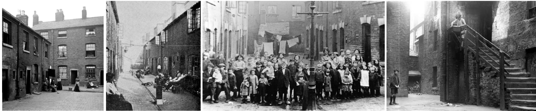
Figura nº007. 1.Patio interior ( court ) en William Street, Birmingham, 1905. (fuente: UPTON, Chris. Living Back to Back , portada) 2.Ruston's Place en Bellar Gate, Nottingham, típico patio interior (fuente: CHAPMAN, Stanley. The history of working-class housing: a symposium , p. 198). 3.Patio interior de las casas back-to-back de Birmingham en Summer Lane, aproximadamente 1920 (fuente: Birmingham Libraries & Archives). 4.Govan, Glasgow, 1925, fotografía de una joven utilizando el lavabo comunal. Tras ella se reconoce la puerta de la letrina, una constante en los barrios obreros hasta finales del siglo XIX, cuando un retrete por rellano de escalera comenzó a ser incluido en el interior de los bloques de nueva planta (fuente: WORBS, Dietrich. The Berlin Mietskasernen and Its Reforms )
