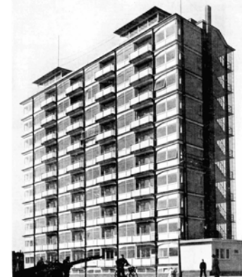
proyecto_ PLAASLAN emplazamiento_ rotterdam arquitecto_ w. VAN TIJEN y h.a. MAASKANT año_ 1937-38
