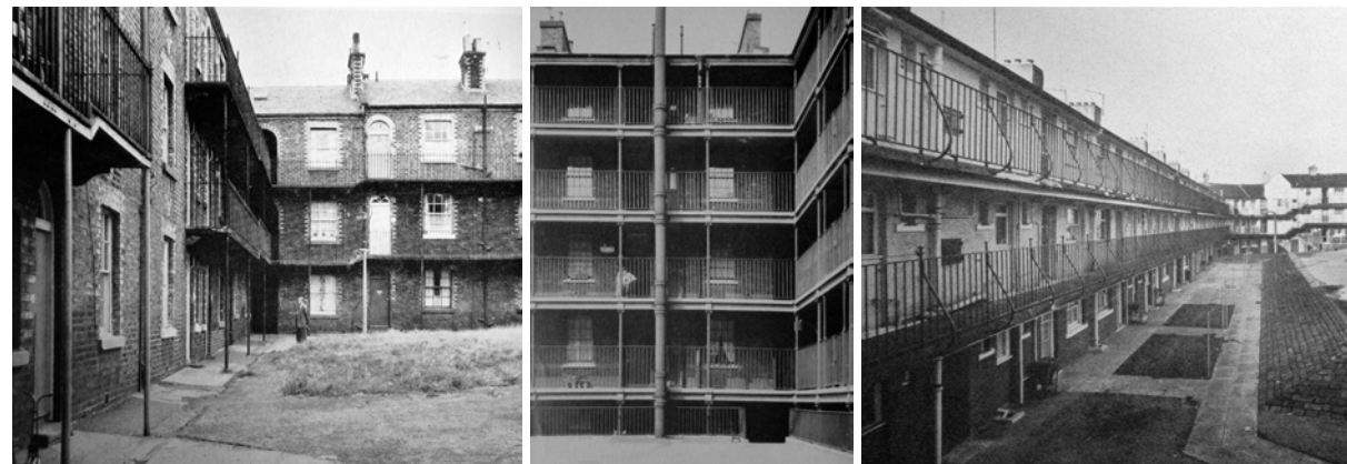
Figura nº 014b. 1.Fotografía del espacio en torno a los corredores exteriores del edificio Rosemount, en Edimburgo, alrededor de 1859. (fuente: TARN, ref. figura 010, p.88); 2.Edificio Gatliff, en la calle Gatliff, 1867, del arquitecto Frederick Chancellor. (fuente: TARN, ref. figura 010, p.62); 3.Viviendas de protección oficial en Longlands Improvement area, 1910, Bradford. (fuente: CAFFYN, Lucy. Workers' Housing in West Yorkshire, 1750-1920 , p. 140); 4 y 5.Planta y fotografía de las viviendas para obreros de la calle Woolman, 1902, Leeds. (fuente: CAFFYN, ref. figura 011, pp. 136-137); 6 y 7.Planta y fotografía de las viviendas de Marsh Lane Garth, en Leeds (fuente: CAFFYN, ref. figura 011, p. 138)
