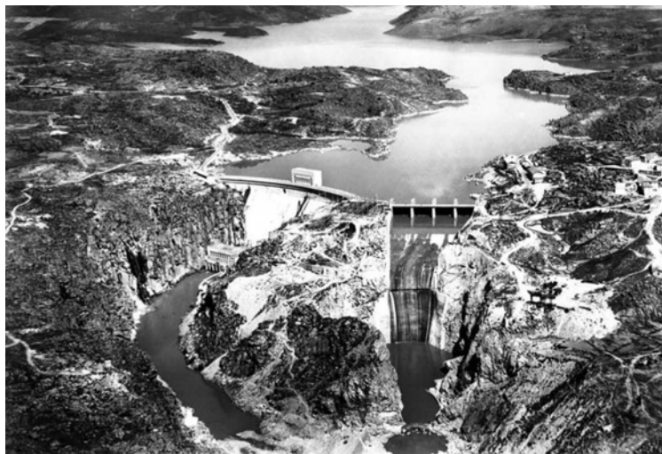
Figura nº023. Presa del salto de Jose Mª Oriol, Alcántara, Cáceres. HE (fuente: GARCÍA ADÁN, Juan Carlos. Fotografía de profesionales y aficionados en la industria eléctrica: Otto Wunderlich versus empleados de la empresa. Actas de las Terceras Jornadas Archivo y Memoria . Madrid, 21 y 22 de Febrero de 2008)
