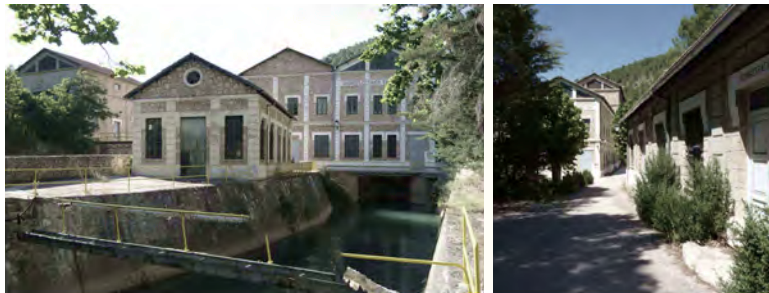
Figura nº 058. Instalaciones de la central de Lucas Urquijo. Son de acceso restringido, por lo que no se ha podido acceder al interior. En la fotografía de la izquierda se muestra la casa de máquinas y el volumen de la derecha es la antigua administración. (fuente: de la autora, 2010)
