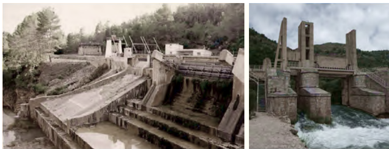
Figura nº 062. Presa de Villora (fuente: José Saíz Valero, 1998) Presa de La Lastra. (fuente: de la autora, 2010)
