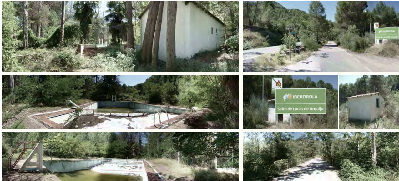
C01. GARITA DE CONTROL y PISCINA.
