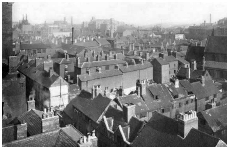
Figura nº 004. Vista aérea del densificado barrio obrero de Narrow Marsh, en Nottingham, año 1919. Se distinguen las 'casas ciegas' ( blind-back ) y las 'espalda con espalda' ( back-to-back ). (fuente: Nottingham City Council. NTGM001896. Publicada en The History of Working-class Housing , de S.D. Chapman. 1971. p. 198)
