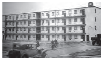
proyecto_ WESTHAUSEN emplazamiento_ frankfurt arquitecto_ ferdinand KRAMER año_ 1929
