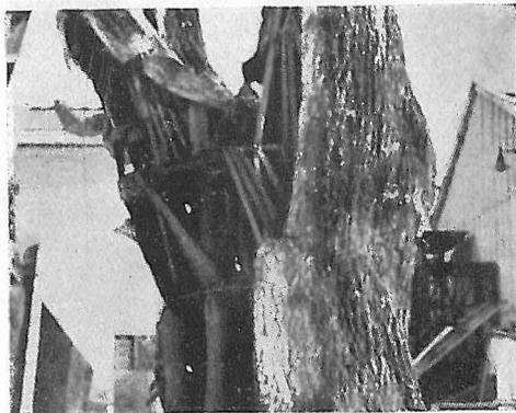
Hasta los objetos naturales, como las mismas plantas, pueden ser imitados a la perfección. Un tronco de corpulento árbol—como tantos otros—se ha construido con una armazón de madera recubierta convenientemente con una capa de escayola para imitar la corteza.
