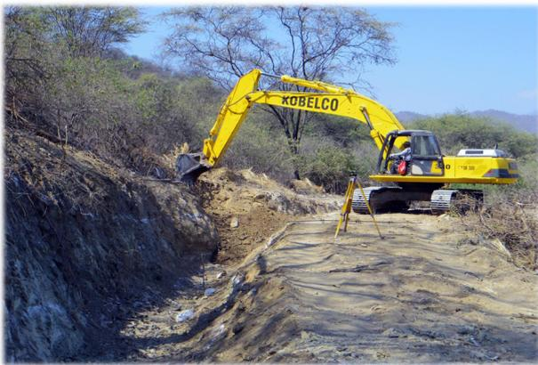
Replanteo Topográfico en el canal.
