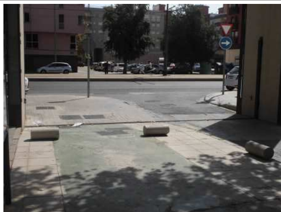
La acera se ensancha en el tramo más próximo al acceso I, sin embargo en el propio acceso los peatones disponen de muy poco espacio segregado, que además está obstaculizado por bolardos.
