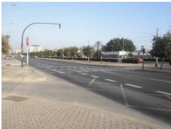
Paso de peatones (nº 2). Señalización horizontal y regulación semafórica. Isleta intermedia sin protección para los peatones. Conexión de las aceras a ambos lados de la Avda Naranjos de forma continua.
