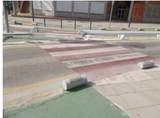
Paso de peatones antes de la rotonda con C/Princesa Muna
