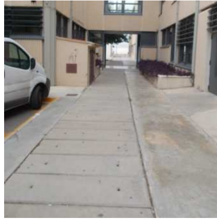
Aceras C/Dario Maravall: Irregularidades en tipo pavimento
