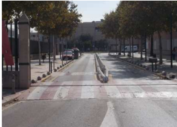
Paso de peatones del vial, en el inicio del mismo en el Acceso A.
