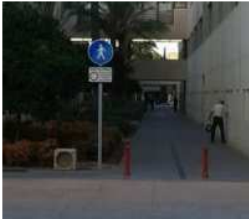
Señal vertical de zona peatonal. Bolardos al inicio de la calle peatonal para impedir el acceso de vehículos a motor
