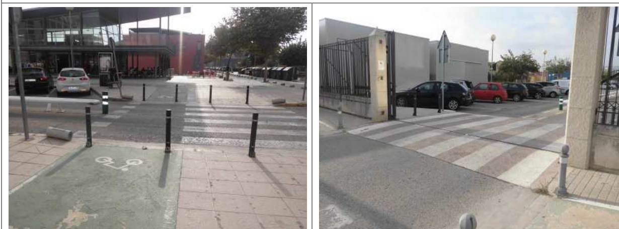
Paso de peatones que permite el cruce del vial conectando las aceras en Kisshomaru Uesiba
