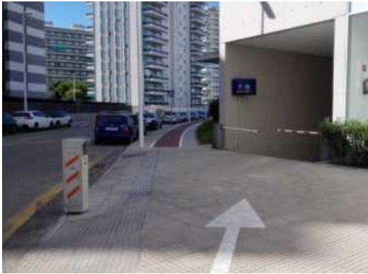
El itinerario peatonal se estrecha/interrumpe en la zona de acceso del parking subterráneo de la UPV P0G2
