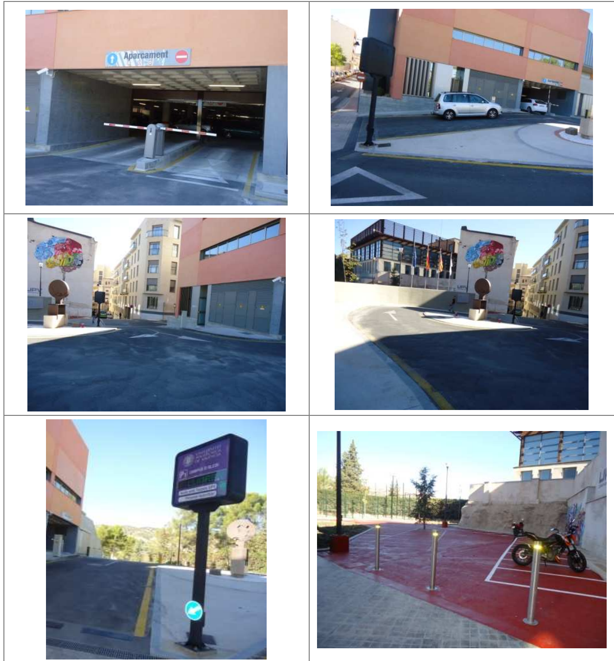
Fotografías del acceso a aparcamientos de Pabellón Polideportivo – Centro de Innovación e Investigación
