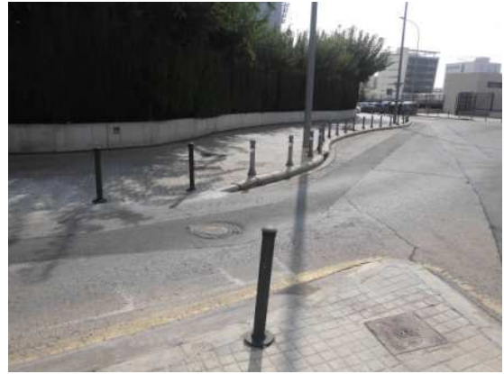
Acera protegidas con bolardos para evitar el estacionamiento indebido
