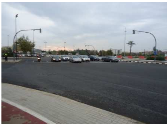
No señalizados los sentidos de circulación de la rotonda
