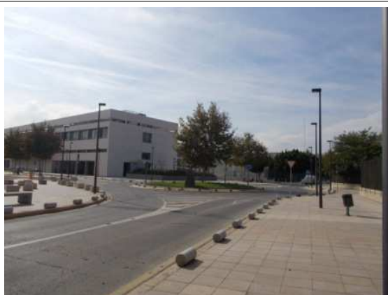
Bolardos de separación aceras peatonales y calzada
