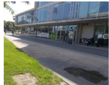
Acera C/ José Saramago: amplia y libre de obstáculos
