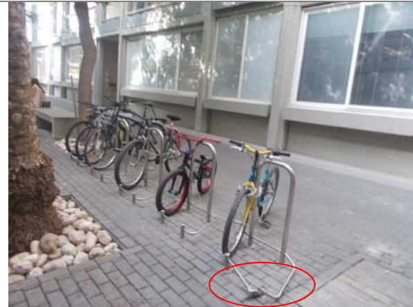
Aparcamiento nº 29: Entre edif. 3H y 5F -Sur . 1 soporte roto
