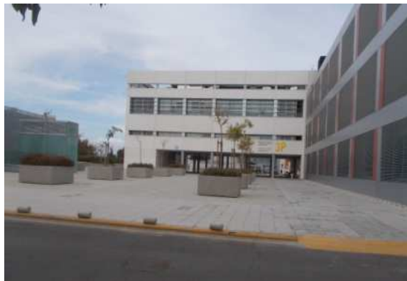
Aceras peatonal frente a edificio 3P: gran amplitud para tránsito peatonal
