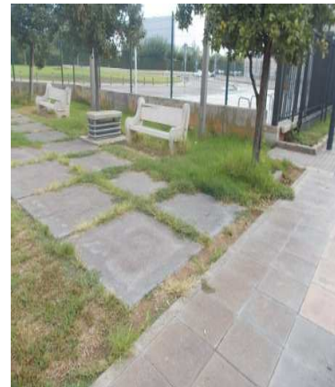
Fin de acera en la valla perimetral del campus (en acceso F)
