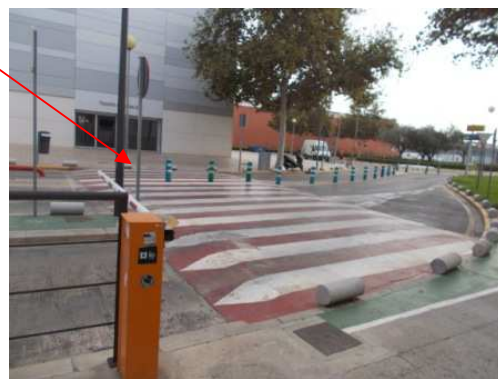
A la altura del paso de peatones frente a edificio 3K (en calle Gianluigi Colalucci) el vial ciclista se interrumpe
