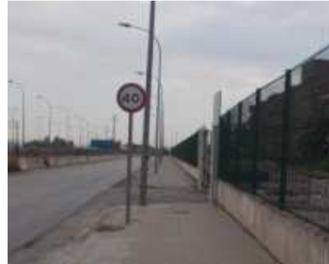
Señal vertical de limitación velocidad en el tramo
