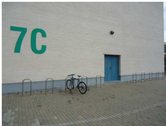
Aparcamiento nº 75: Edificio 7C Sur
