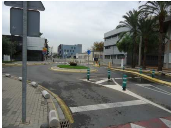
Vista general de la vía en la zona de ubicación de la rotonda. Adecuada señalización horizontal
