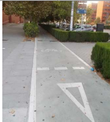
Tramo de carril a su paso por acceso M
