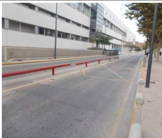
Mediana de separación de carriles y bolardos de separación vial circulación-acera peatonal
