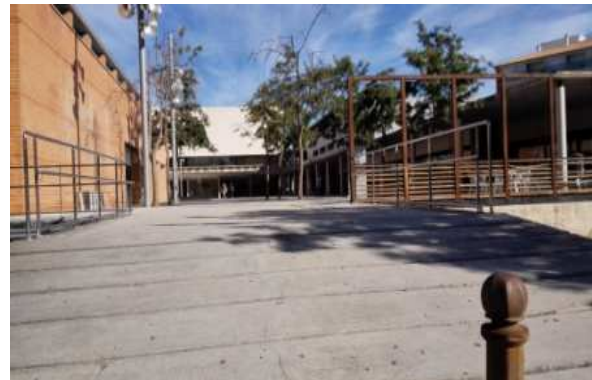
Inicio de la pasarela a Acceso B desde esta zona peatonal
