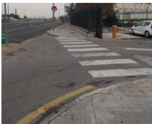
Conexión acera en acceso S mediante paso de peatones
