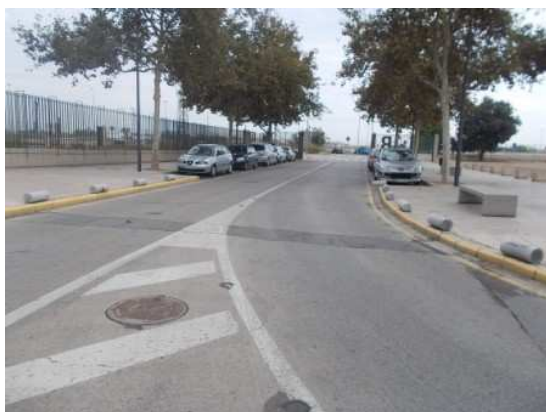
Vista del vial hasta el acceso B
