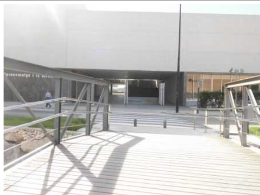
Vista detalle del pavimento de la pasarela: tablas de maderas; existencia de bolardos antes del segundo tramo de paso peatonal.
