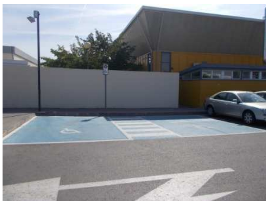
Plazas reservadas para personas con movilidad reducida. Correcta se~nalizaci3n de las mismas
