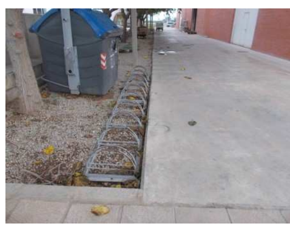
Aparcamiento nº 41: C/Montserrat Caballé
