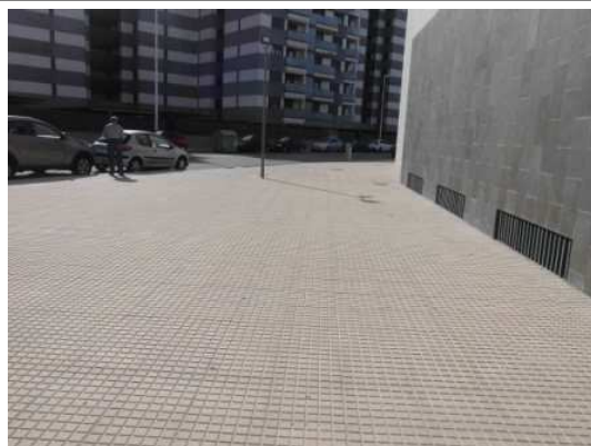
Acera hacia el lado este desde el acceso al edificio H hasta conectar con acera de Ronda de l'Agora: anchura libre suficiente para circulaci3n peatonal
