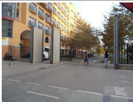
Vista general del acceso; Incorrecto acceso de peatones por zona de paso de vehículos a motor
