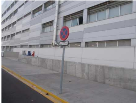
Acera oeste edificio 3N: anchura adecuada y libre de obstáculos. Continuidad peatonal de la acera
