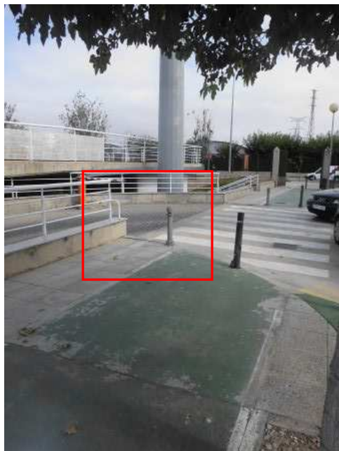
Paso de peatones dando continuidad al itinerario peatonal en el cruce con un acceso al parking P7A. Bolardo que dificulta el paso.
