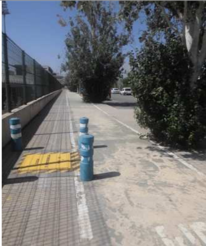
Tramo desde acceso G a acceso F: pintura muy deteriorada y presencia de obstáculos (salida de emergencia y árboles cuyas ramas invaden el carril)
