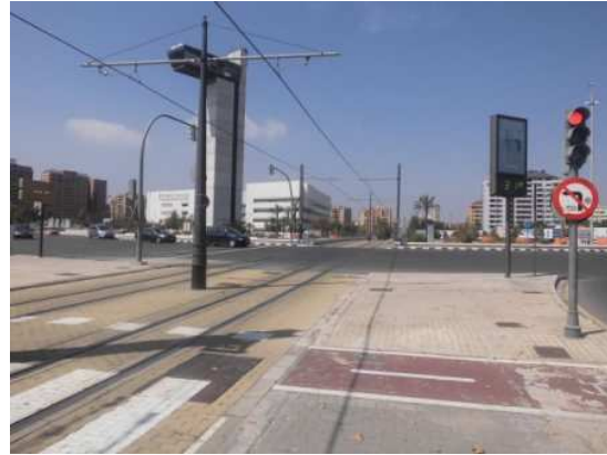
Paso de peatones (nº 1). Señalización horizontal y regulación semafórica. Isleta intermedia sin protección para los peatones. Conexión de las aceras a ambos lados de la Avda Naranjos de forma continua.
