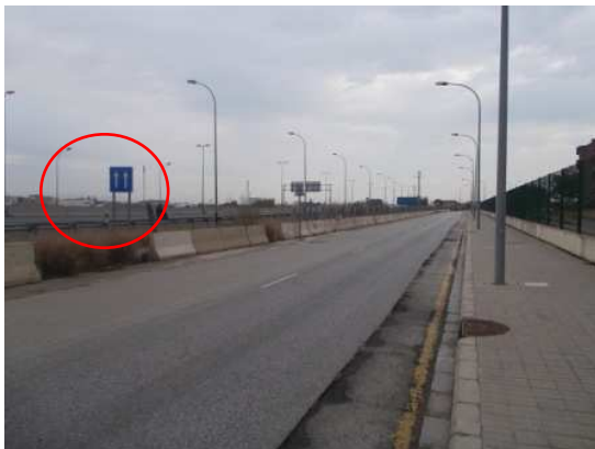
Señalización de obligación de sentido de circulación único en los dos carriles
