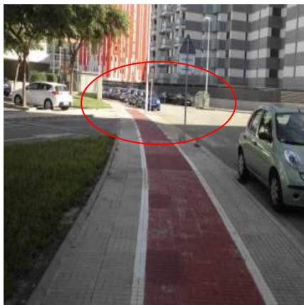
Tramo de acceso al aparcamiento
