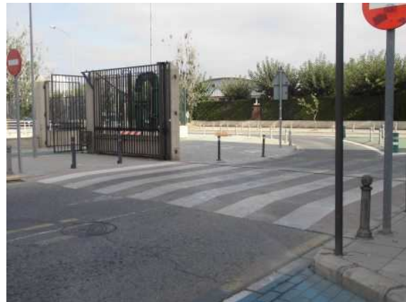
Paso de peatones elevado conectando aceras en Jose Calavera Ruiz, junto al acceso G.
