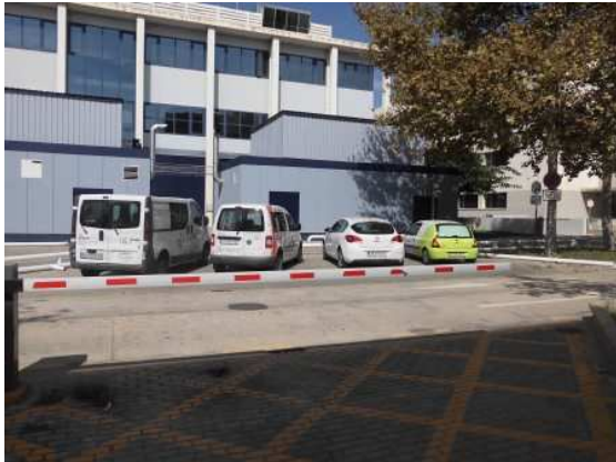
Ocupación Zona C/D nº 10 - Cara este edificio 6D
