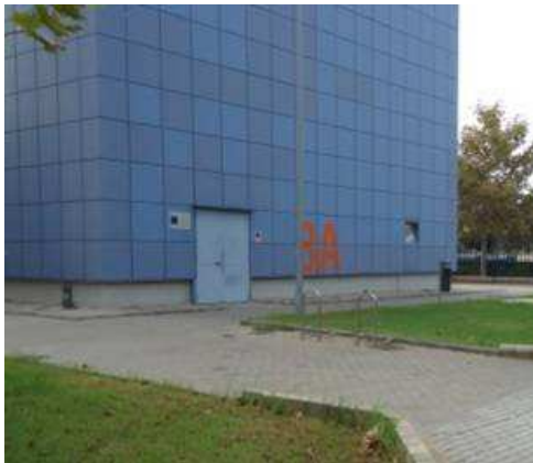
Aparcamiento nº 87: Edificio 8A Oeste (C/ James H Whitelaw)
