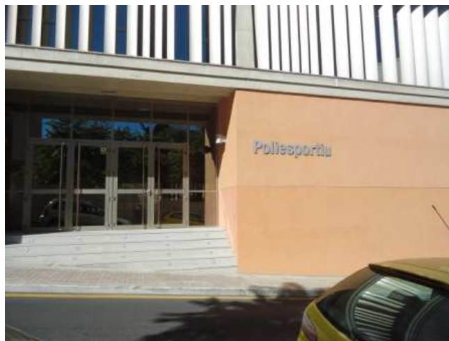
Acceso (este) peatonal desde acera de esta calle
