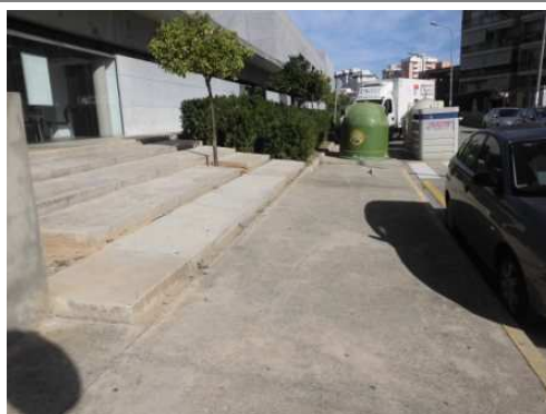
Vista de la acera frente al acceso a la cafetería:
