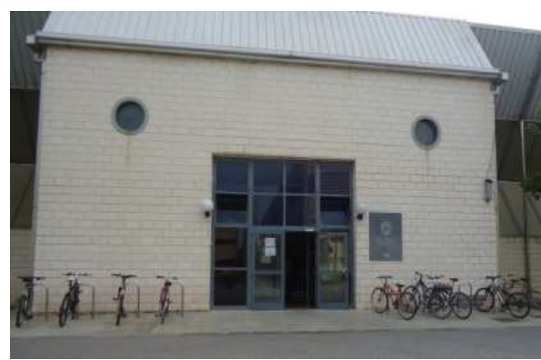
Aparcamiento nº 68: Cara oeste Edificio piscina cubierta
