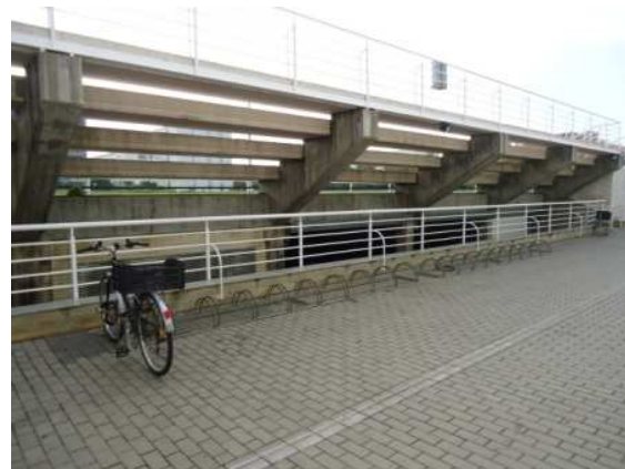
Aparcamiento nº 76: Edificio 7C Este
