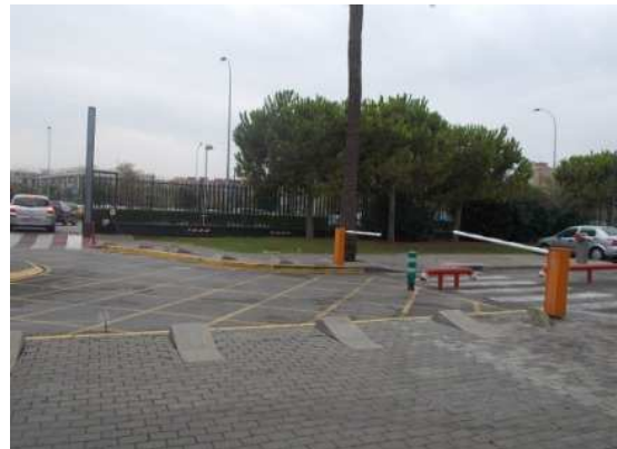
Aparcamiento cerrado mediante el uso de barreras, tanto en las entradas como salida del parking
