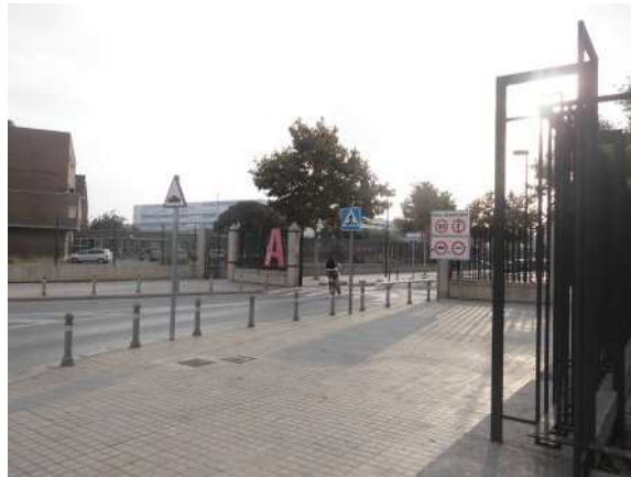
Bolardos en la acera para impedir que los vehículos invadan la zona peatonal
