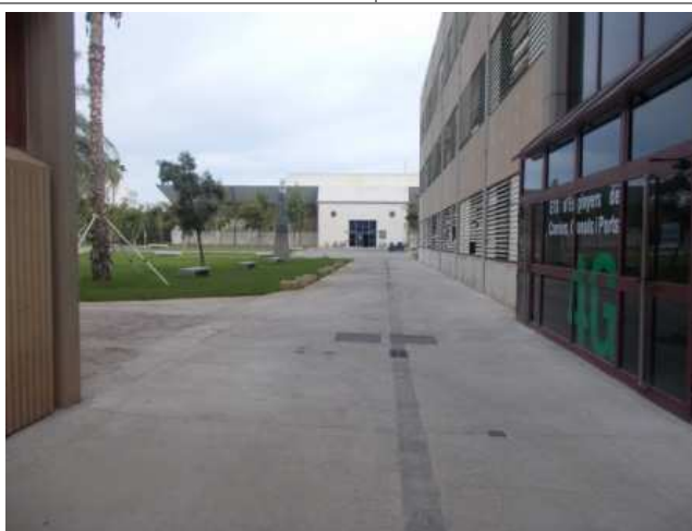
Tramo peatonal entre edificios 4J-4K y 4G: Amplitud y libre de obstáculos; Continuidad para circulación peatonal al conectar con la zona peatonal ZP3
