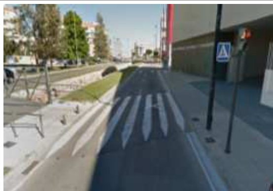
2 o tramo de paso de peatones: se1alizi3n horizontal y vertical; regulaci3n con semàforo
