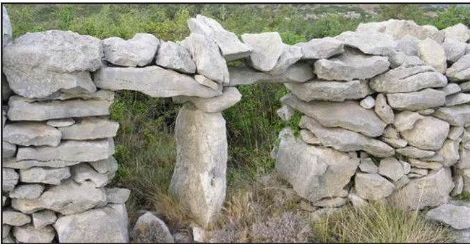
Fig. 6. 5. Foto de perforación en el muro para su recuento y control en la Belladona de Ares.
