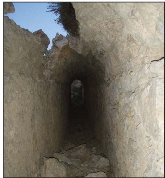
Fig. 6.25. Foto del interior de la conducción del acueducto medieval en Morella (1315-59).
