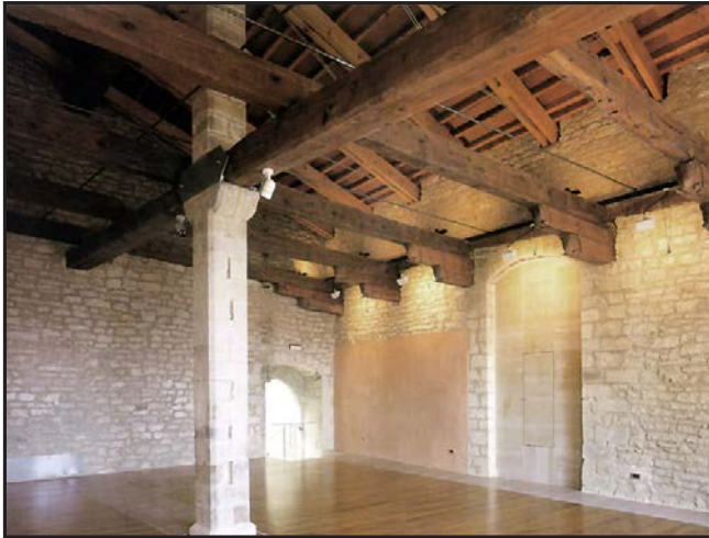
Fig. 4. 81. Vista interior sala del consell de la casa comunal de Morella.
