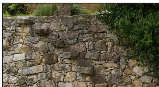
Fig. 4. 37. Escalera en muro de piedra en el "Molinar" de Xert.
