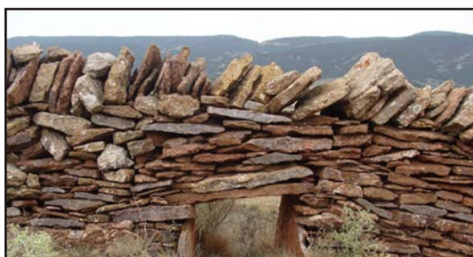
Fig. 4. 38. Remate de muro de piedra en seco en Villafranca.
