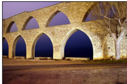
Fig. 6.26. Foto de uno de los tramos del acueducto de Morella (1315-59).
