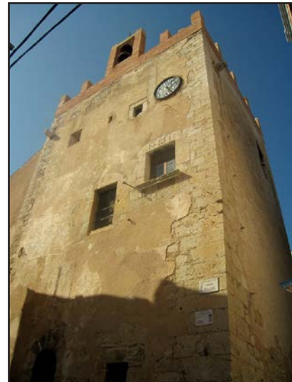
Fig. 4. 107. Torre de Calig.
