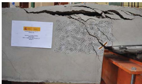
VISTA GENERAL DEL APOYO TRAS LA ROTURA
