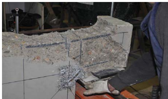
HORMIGÓN DESPRENDIDO EN EXTERIOR ZONA DE CONFINAM.
