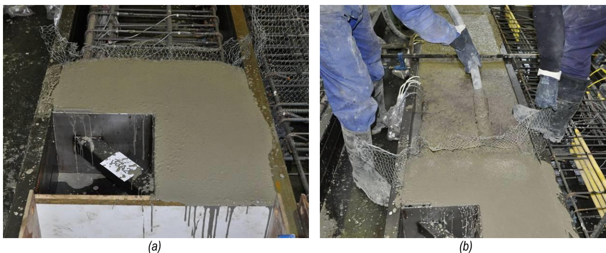
Figura III.8: Puesta en obra de las piezas con HRFA: (a) Hormigonado del apoyo con HRFA; (b) Hormigonado con hormigón convencional y vibrado para conexión de hormigones
