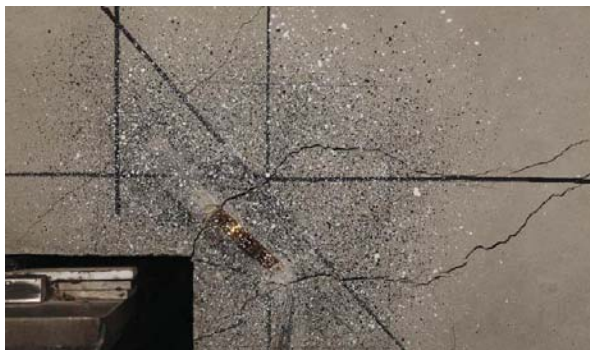
DETALLE DE FISURACIÓN A LA CARGA MÁXIMA
