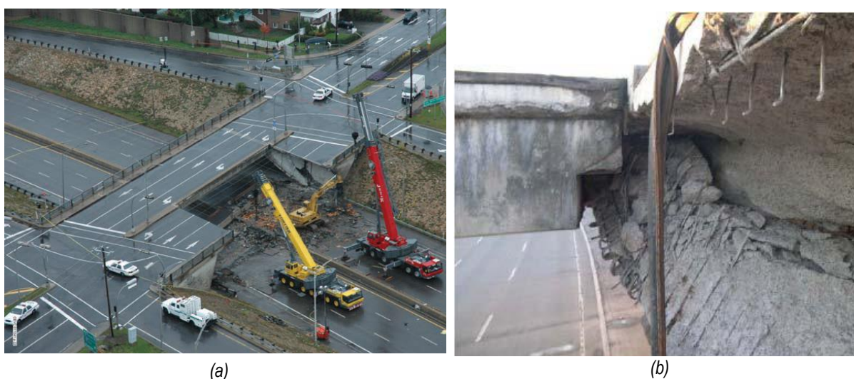
Fotografía I.3: Fallo del paso superior Concorde en Quebec en 2006 [3]: (a) Vista general del colapso; (b) Detalle de los AMM tras la rotura
