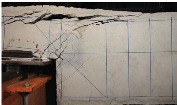
VISTA GENERAL DEL APOYO TRAS LA ROTURA
