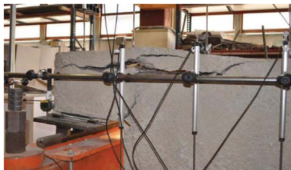
DETALLE DE LA ZONA DE FISURACIÓN TRAS LA ROTURA
