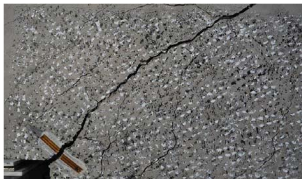
DETALLE DE FISURACIÓN A LA CARGA MÁXIMA
