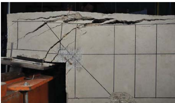
VISTA GENERAL DEL APOYO TRAS LA ROTURA
