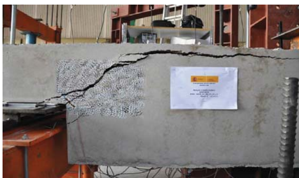
VISTA GENERAL TRAS EL ENSAYO DE RECARGA
