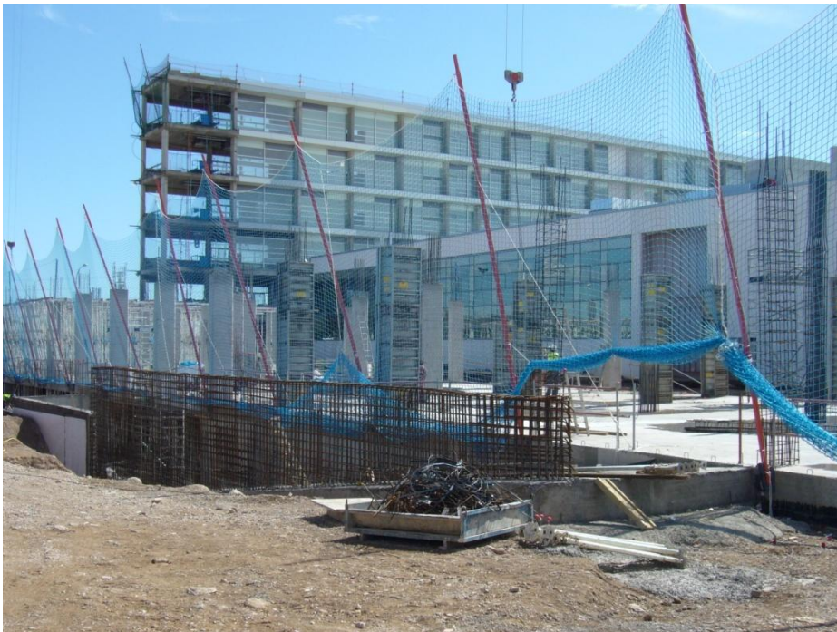
Fig. II.46 Pilares y elementos de seguridad del forjado 2
