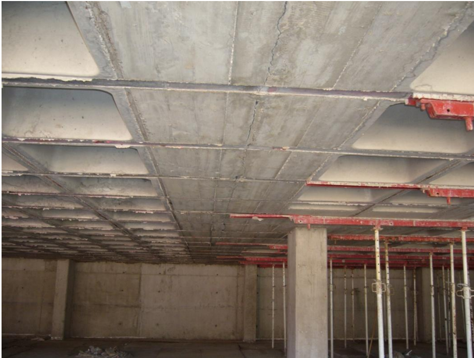
Fig. II.53 Descimbrado del forjado 1
