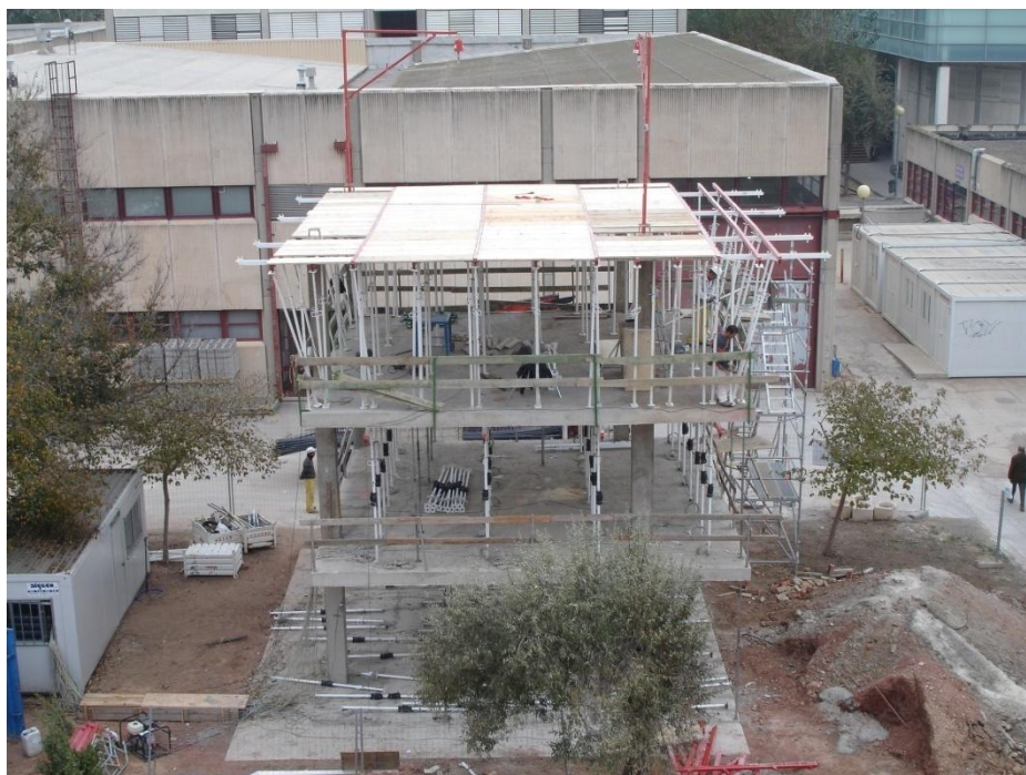
Fig. II.25 Instalación del sistema de cimbrado del forjado 3
