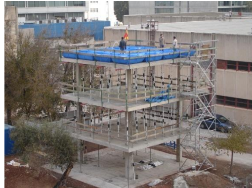
Fig. 3.9 Proceso constructivo día “24”
