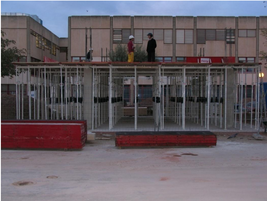
Fig. II.6 Sistema de cimbrado forjado 1
