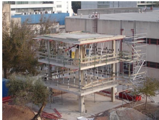
Fig. 3.8 Proceso constructivo día "20"
