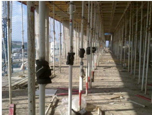
Fig. 5.7 Proceso constructivo día “17”
