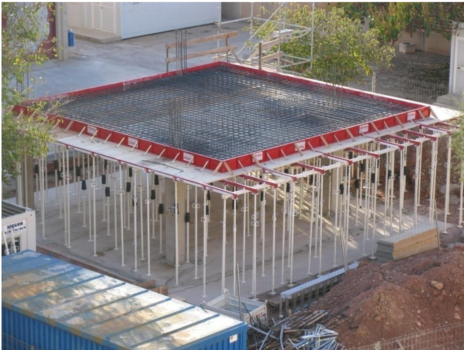
Fig. II.7 Armado del forjado 1
