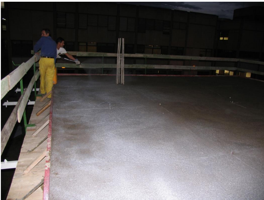
Fig. II.19 Curado del forjado 2
