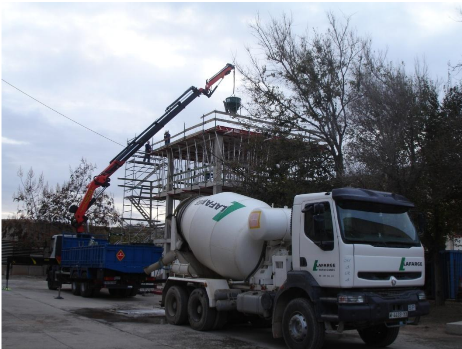
Fig. II.27 Hormigonado del forjado 3
