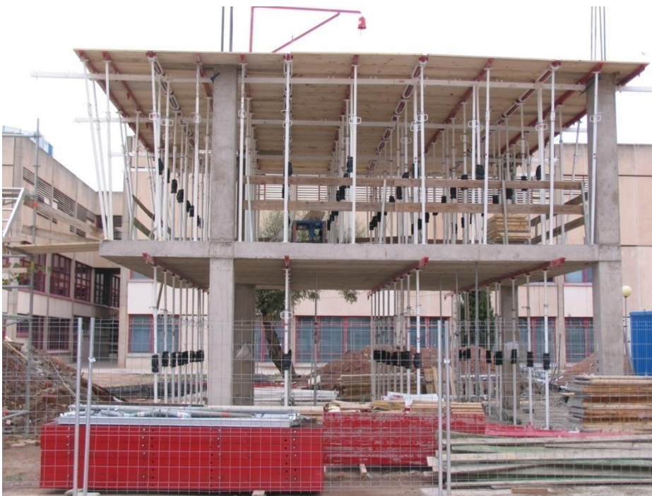
Fig. II.15 Clareado del forjado 1
