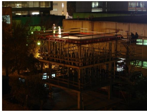
Fig. 3.7 Proceso constructivo día "17"
