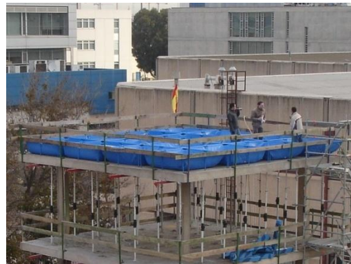
Fig. 3.10 Proceso constructivo día “25”
