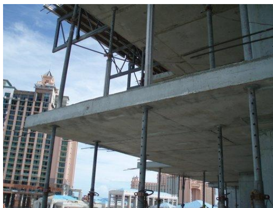
Fig. 2.6 Proceso de cimbrado, recimbrado, descimbrado
