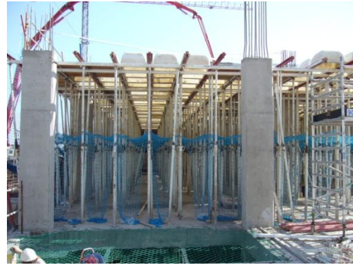
Fig. 5.3 Proceso constructivo día "7"
