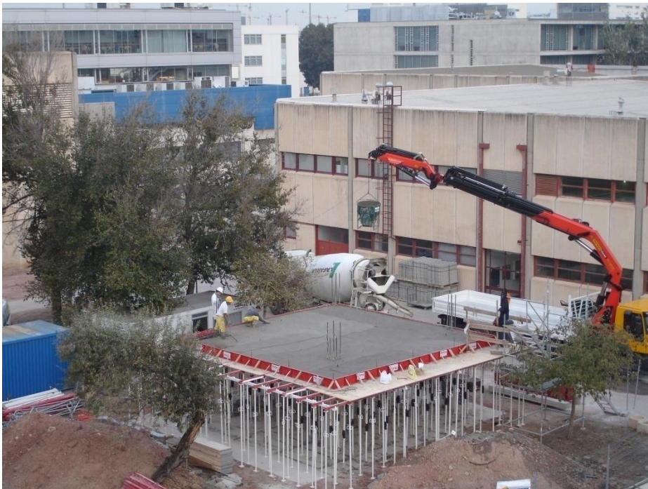
Fig. II.11 Hormigonado del forjado 1
