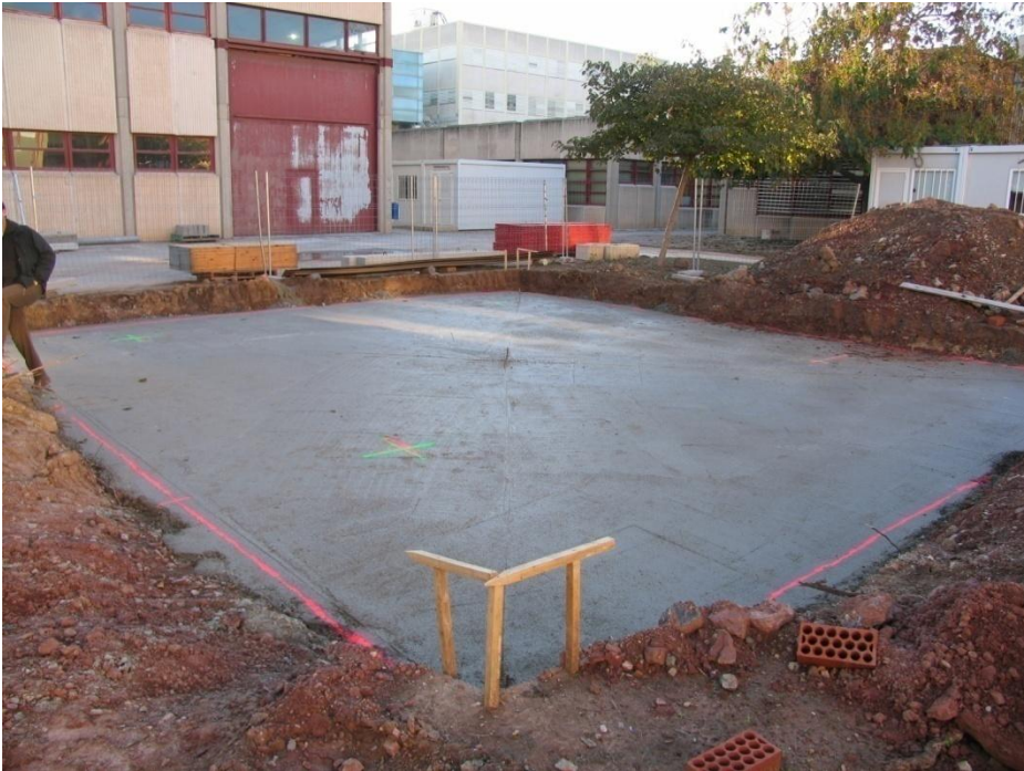
Fig. II.2 Hormigón de limpieza y replanteo de la cimentación
