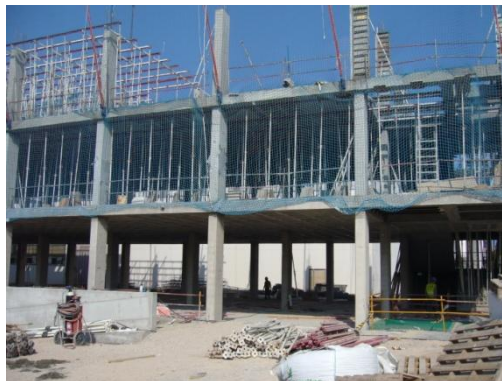
Fig. 5.8 Proceso constructivo día “18”
