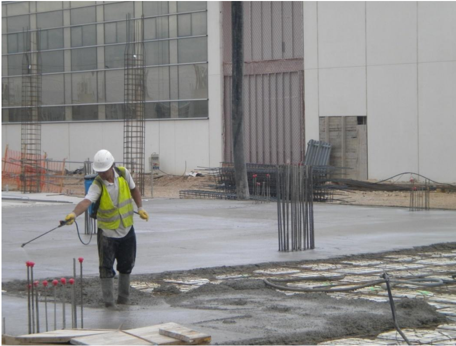
Fig. II.45 Curado del hormigón del forjado 1
