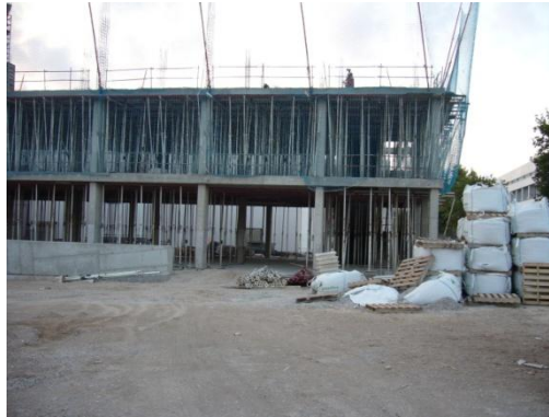
Fig. 5.6 Proceso constructivo día “14”
