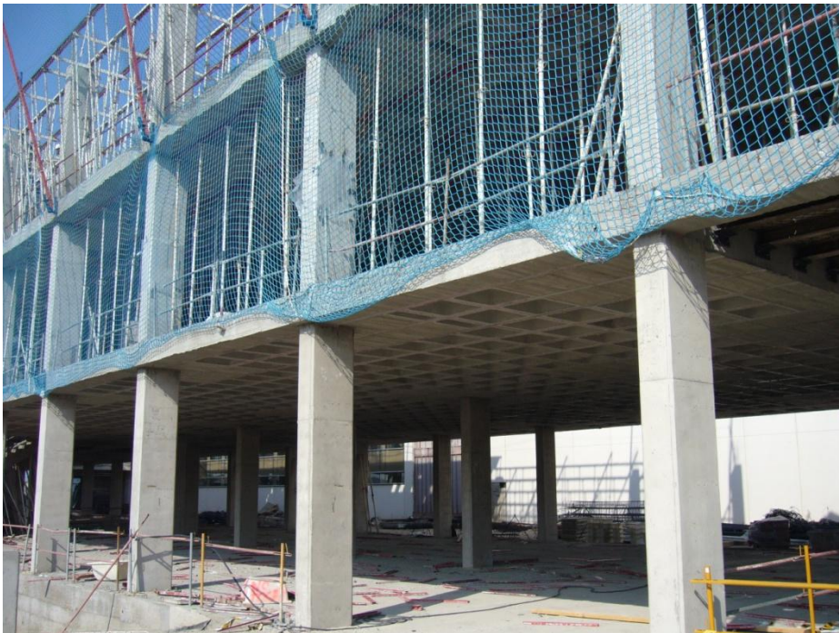
Fig. II.58 Descimbrado del forjado 2
