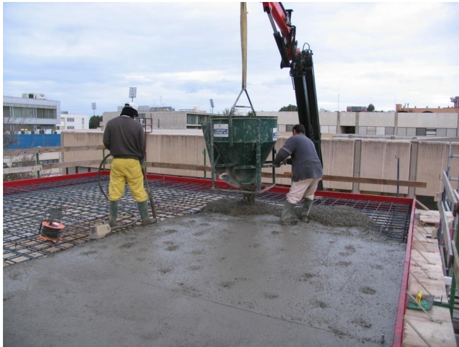
Fig. II.28 Hormigonado del forjado 3
