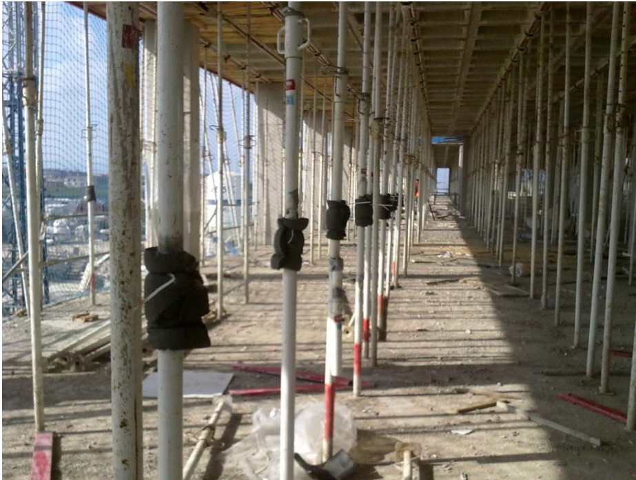
Fig. II.57 Clareado del forjado 3
