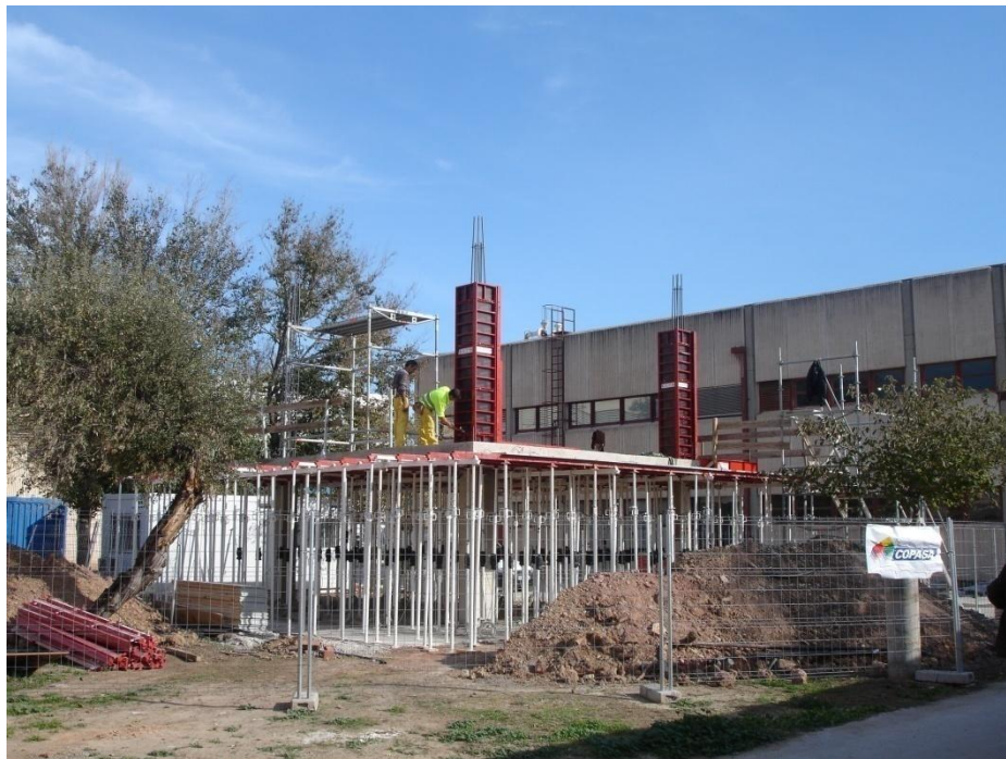
Fig. II.12 Montaje del encofrado de los pilares del forjado 2
