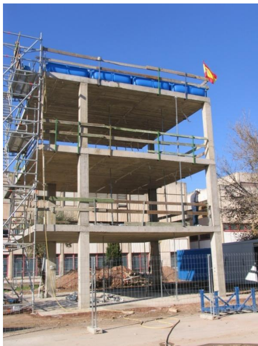
Fig. II.38 Descimbrado del forjado 3
