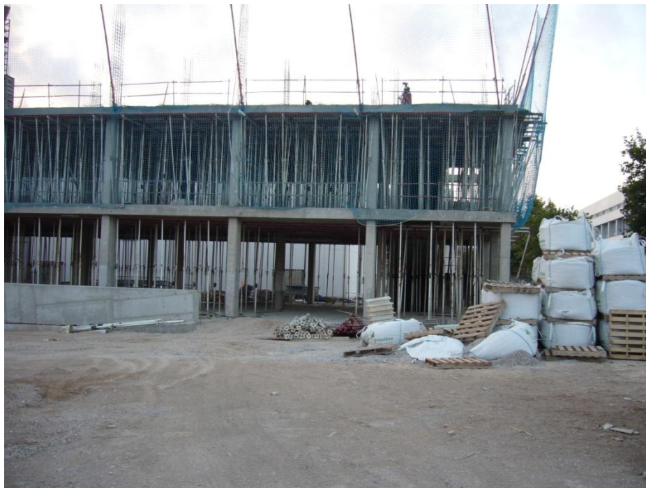
Fig. II.56 Hormigonado del forjado 3
