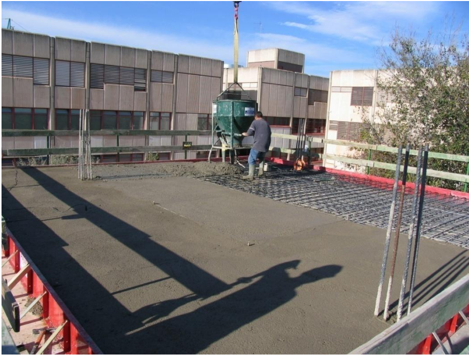
Fig. II.18 Hormigonado del forjado 2
