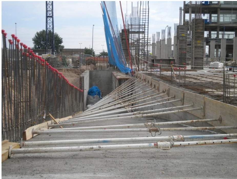
Fig. II.43 Hormigonado del forjado 1 y ejecución de pilares del nivel 2
