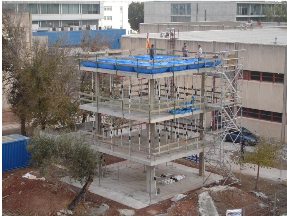
Fig. II.36 Aplicación de la carga en el forjado 3
