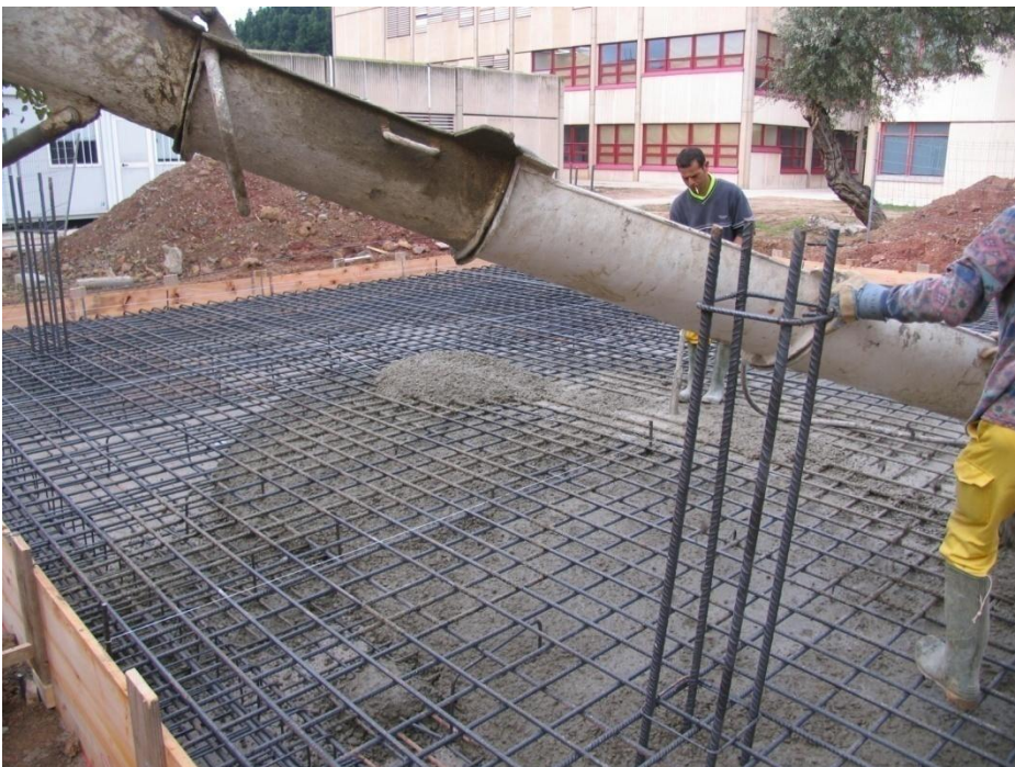
Fig. II.3 Hormigonado de la losa de cimentación
