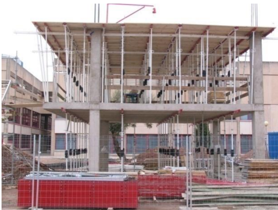
Fig. 2.7 Proceso de cimbrado, clareado y descimbrado
