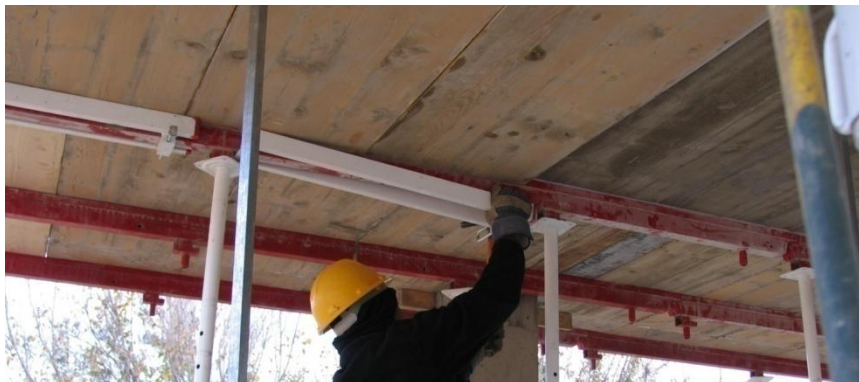
Fig. 3.15 Extracción del basculante de las sopandas principales
