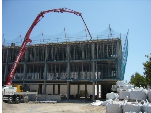
Fig. 5.9 Proceso constructivo día “21”
