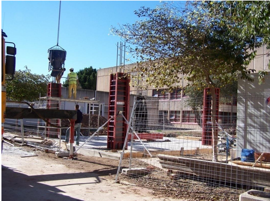
Fig. II.4 Hormigonado de los pilares del primer forjado
