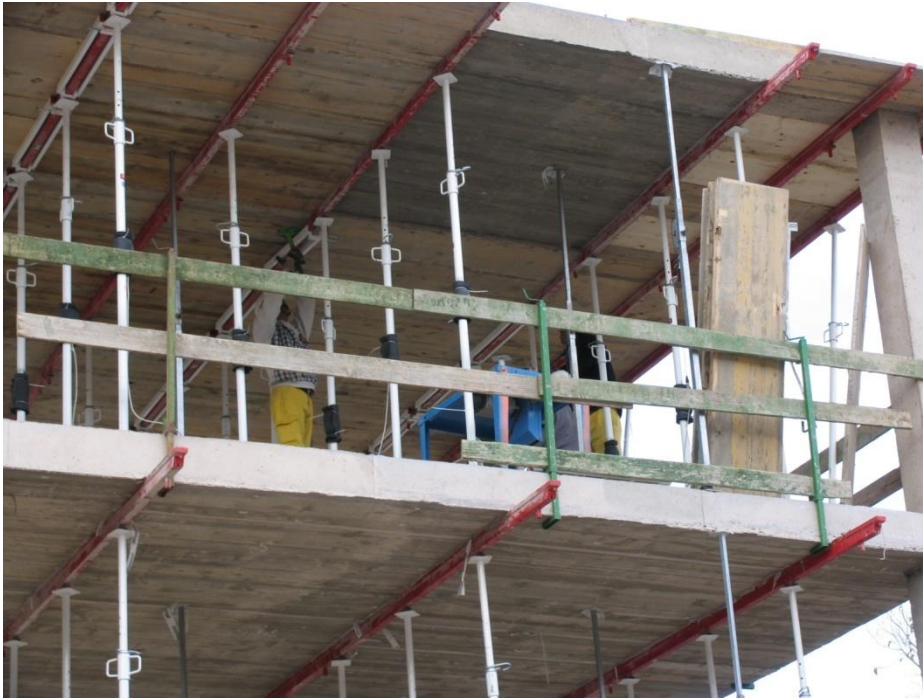
Fig. II.30 Clareado del forjado 3
