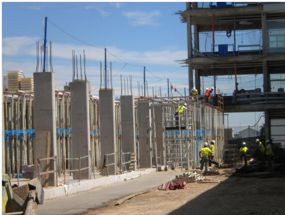
Fig. II.48 Instalación del sistema de cimbrado del forjado 2
