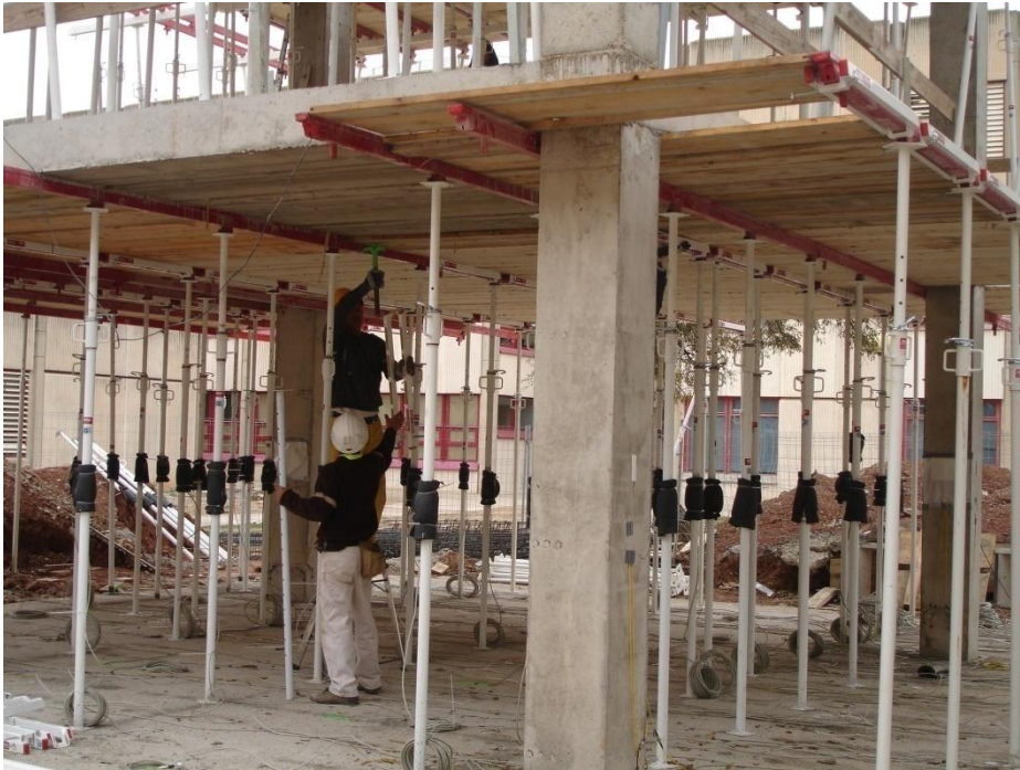
Fig. II.14 Clareado del forjado 1
