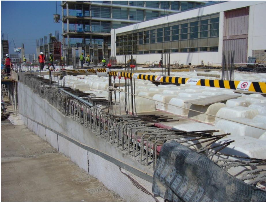
Fig. II.41 Conexión muro-forjado
