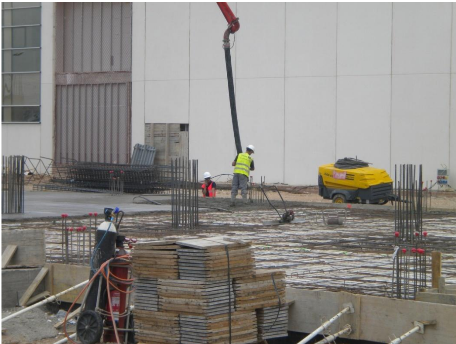
Fig. II.42 Hormigonado del forjado 1
