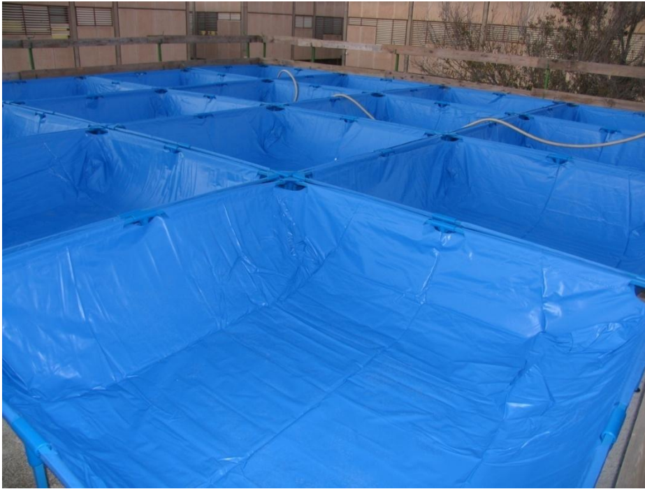
Fig. II.34 Balsas plásticas para aplicar la carga en el forjado 3
