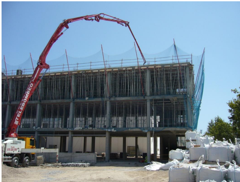
Fig. II.59 Hormigonado del forjado 4
