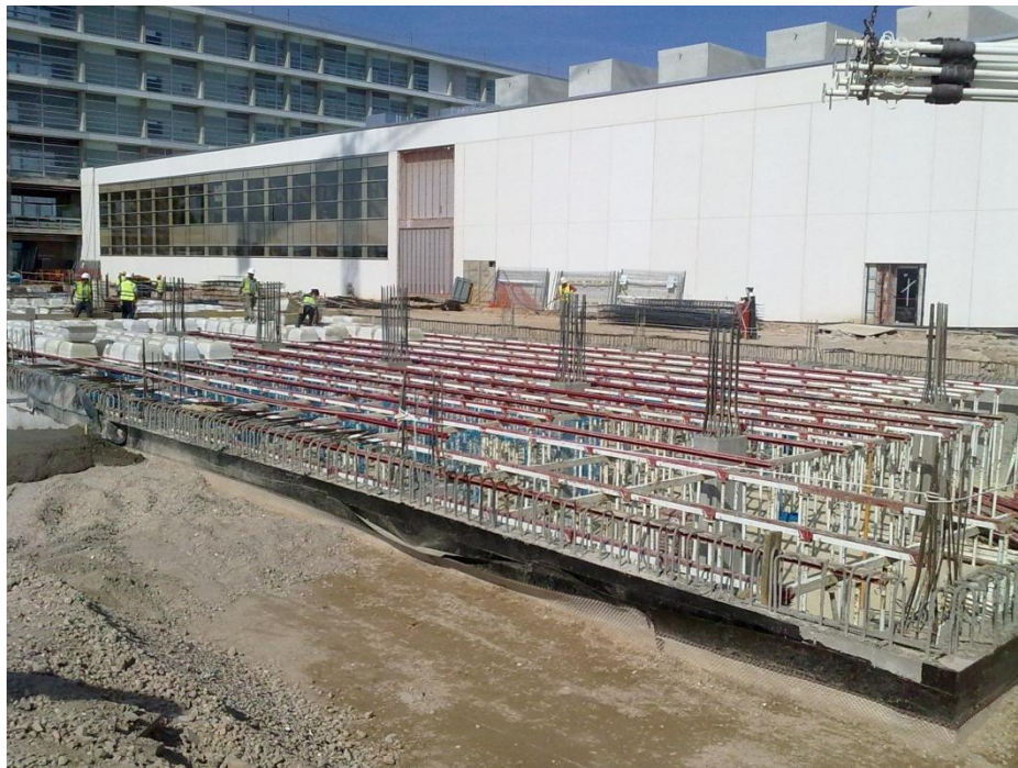
Fig. II.40 Instalación de casetones recuperables del forjado 1
