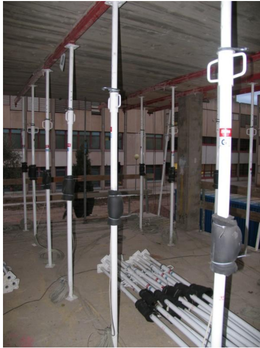
Fig. II.22 Clareado del forjado 2
