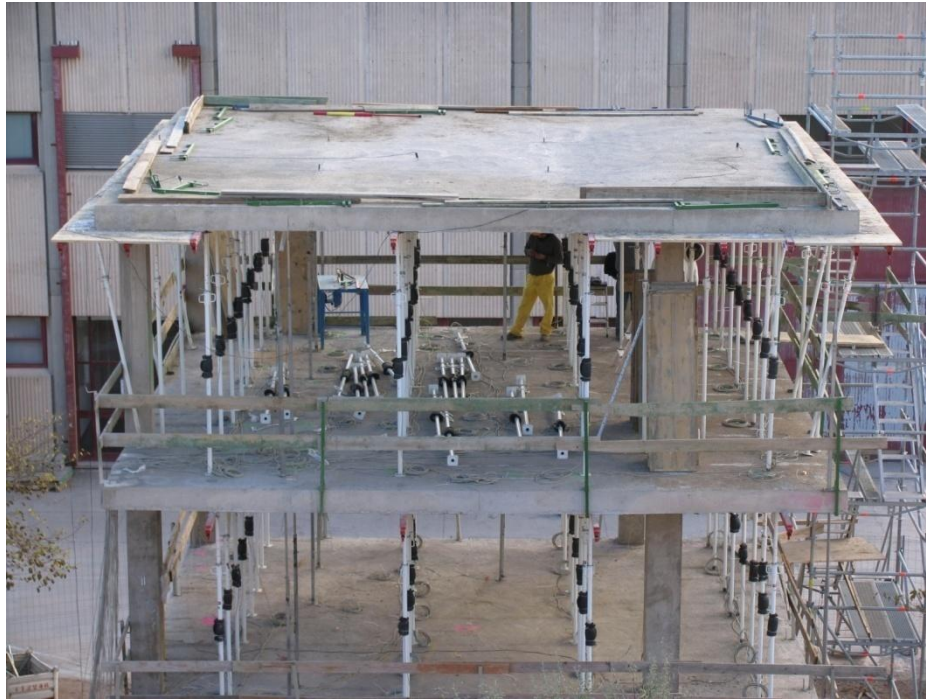
Fig. II.32 Clareado del forjado 3
