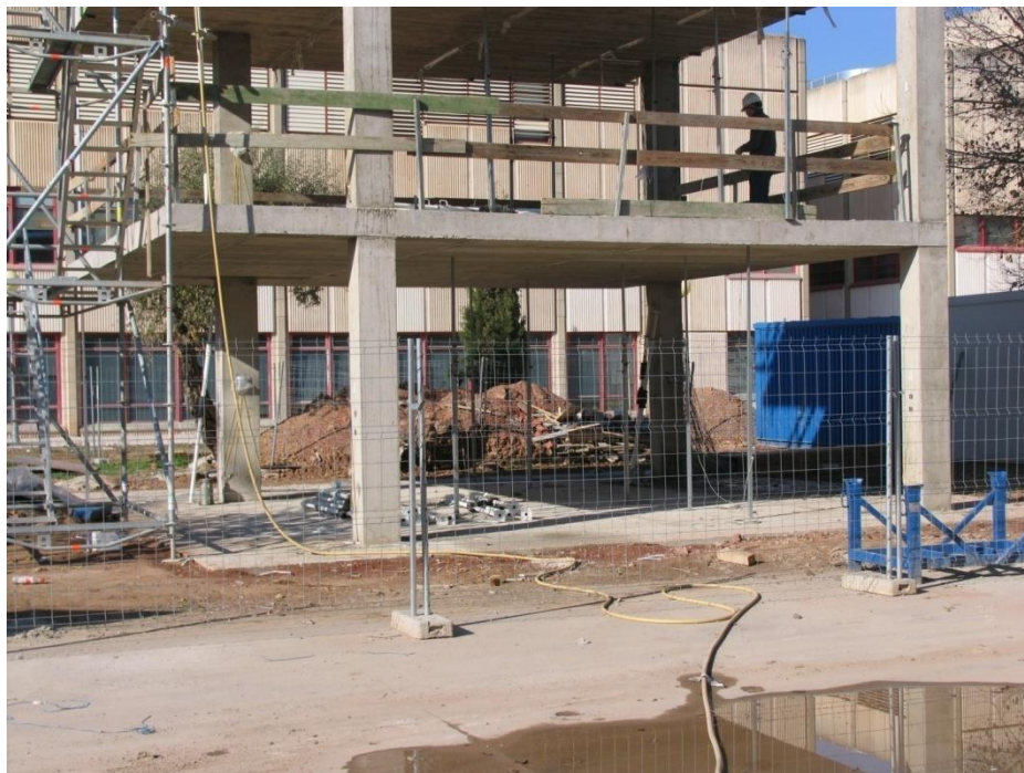
Fig. II.37 Descimbrado del forjado 2
