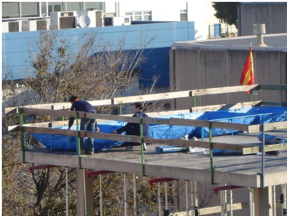
Fig. II.33 Instalación de balsas plásticas para aplicar la carga en el forjado 3
