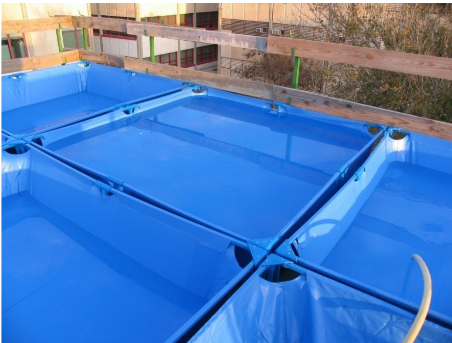
Fig. II.35 Llenado del las balsas plásticas para aplicar la carga en el forjado 3
