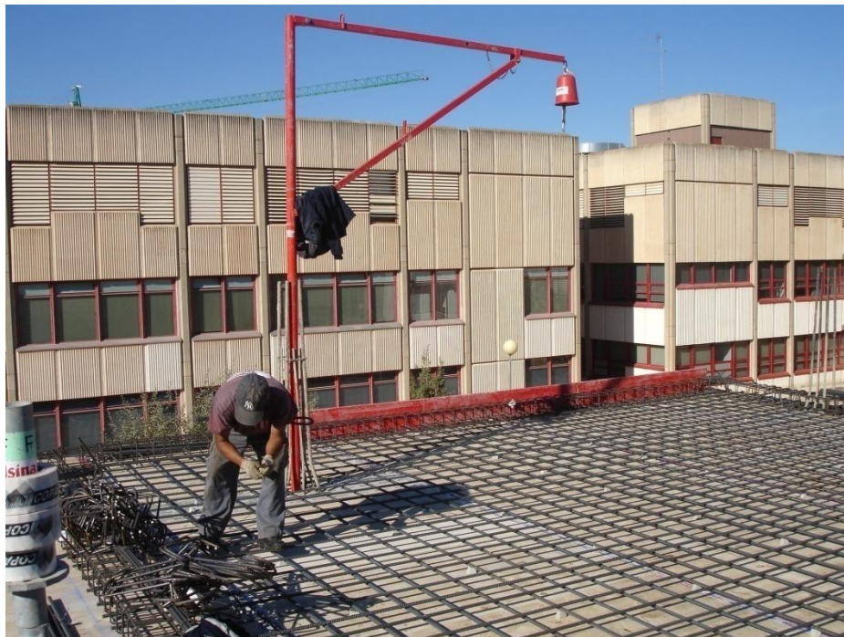
Fig. II.16 Armado del forjado 2
