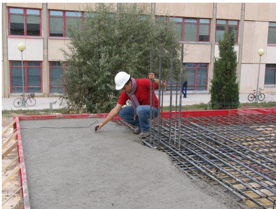
Fig. II.9 Instalación de termopares en el hormigón del forjado 1
