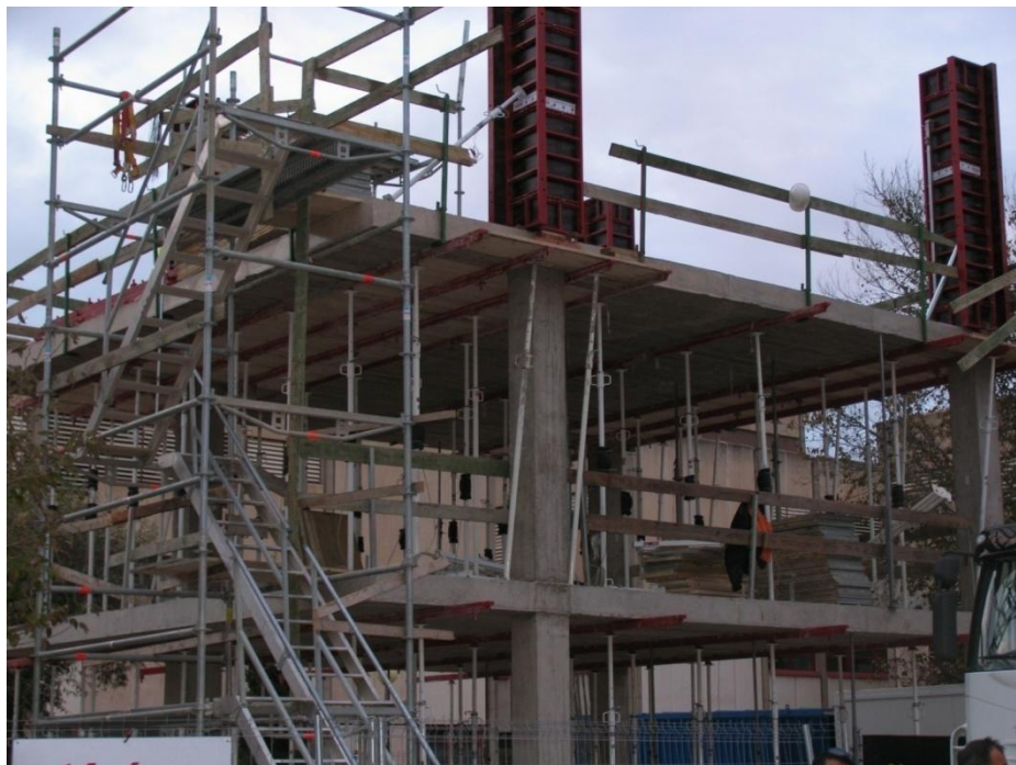
Fig. II.21 Clareado del forjado 2
