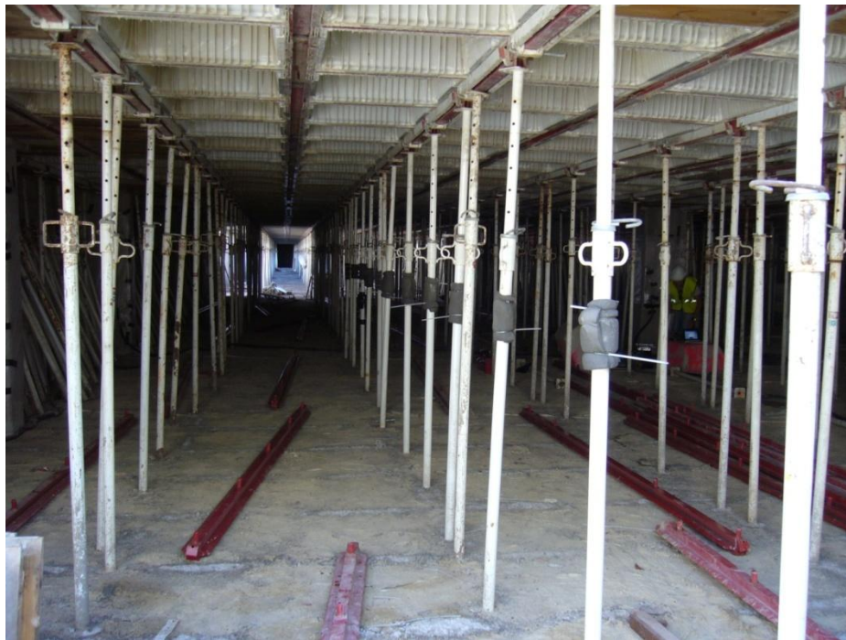
Fig. II.47 Clareado del forjado 1
