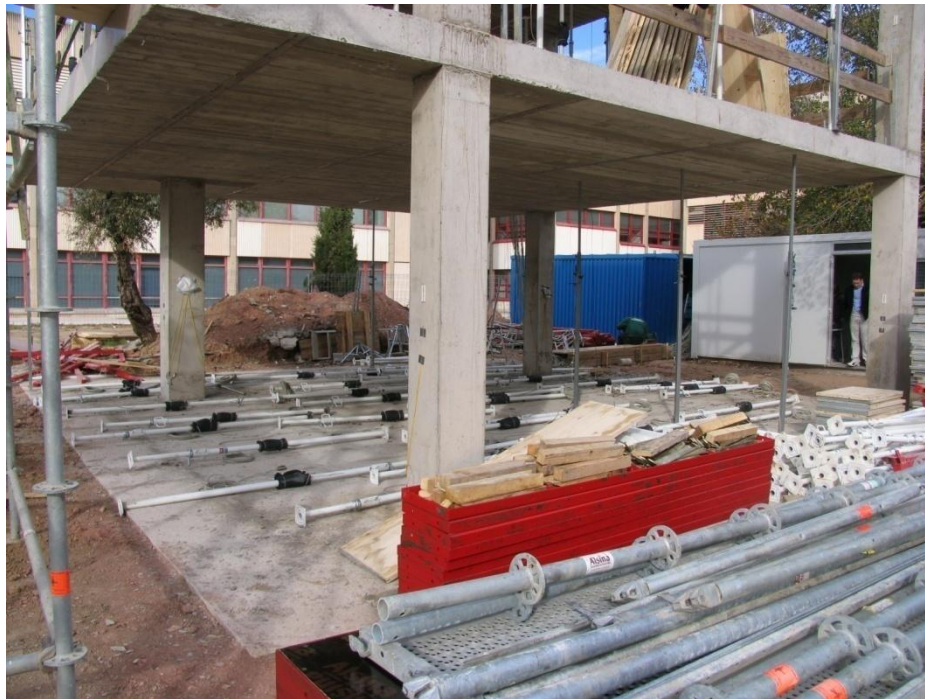
Fig. II.24 Descimbrado del forjado 1
