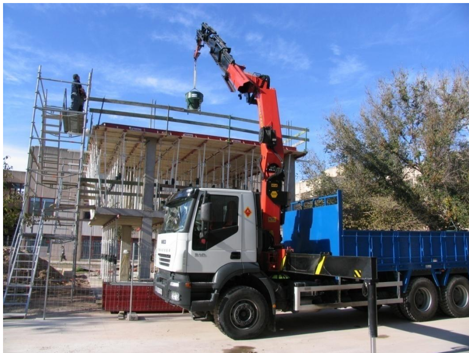
Fig. II.17 Hormigonado del forjado 2
