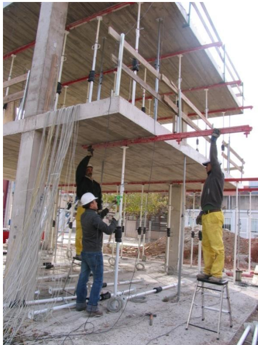
Fig. II.23 Descimbrado del forjado 1
