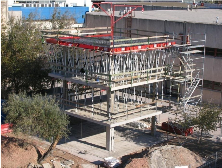
Fig. II.26 Armado del forjado 3
