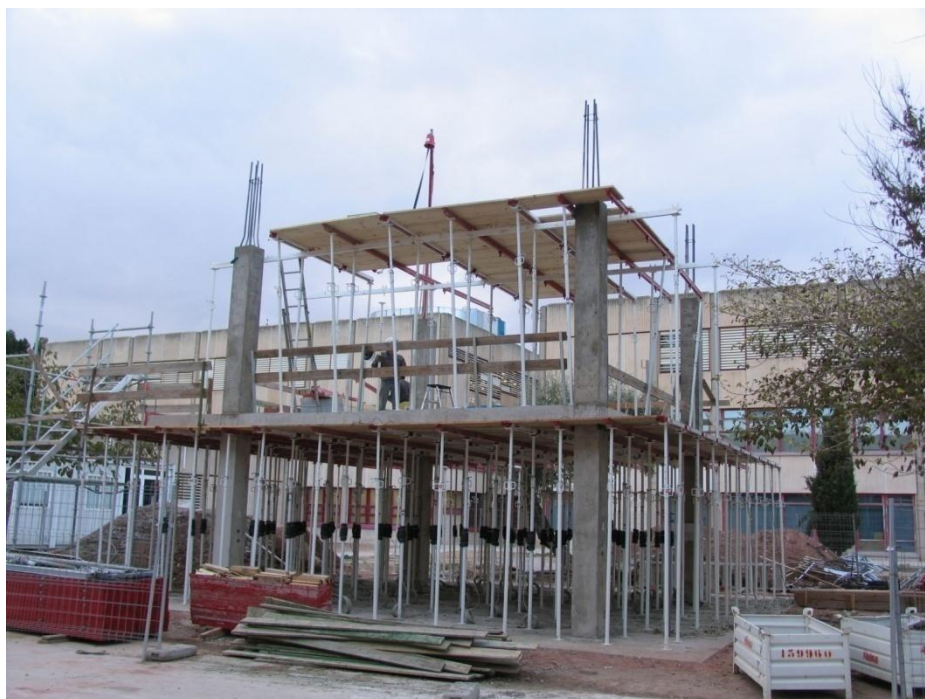
Fig. II.13 Instalación del sistema de cimbrado del forjado 2
