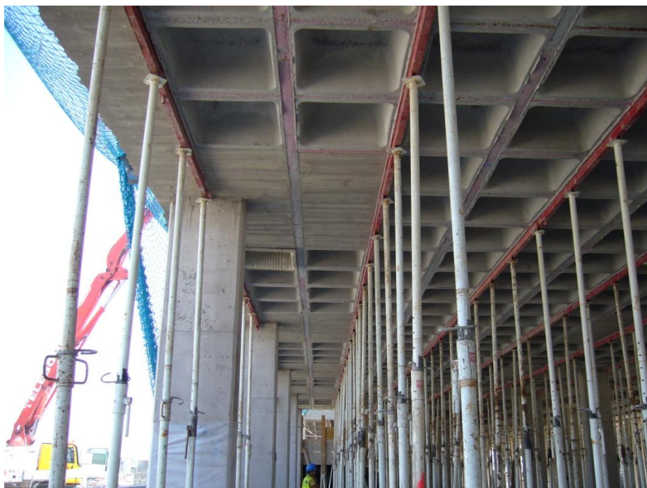
Fig. II.52 Clareado del forjado 2
