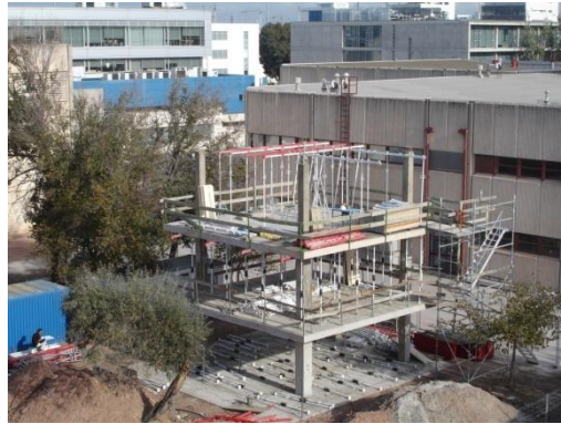
Fig. 3.6 Proceso constructivo día "14"
