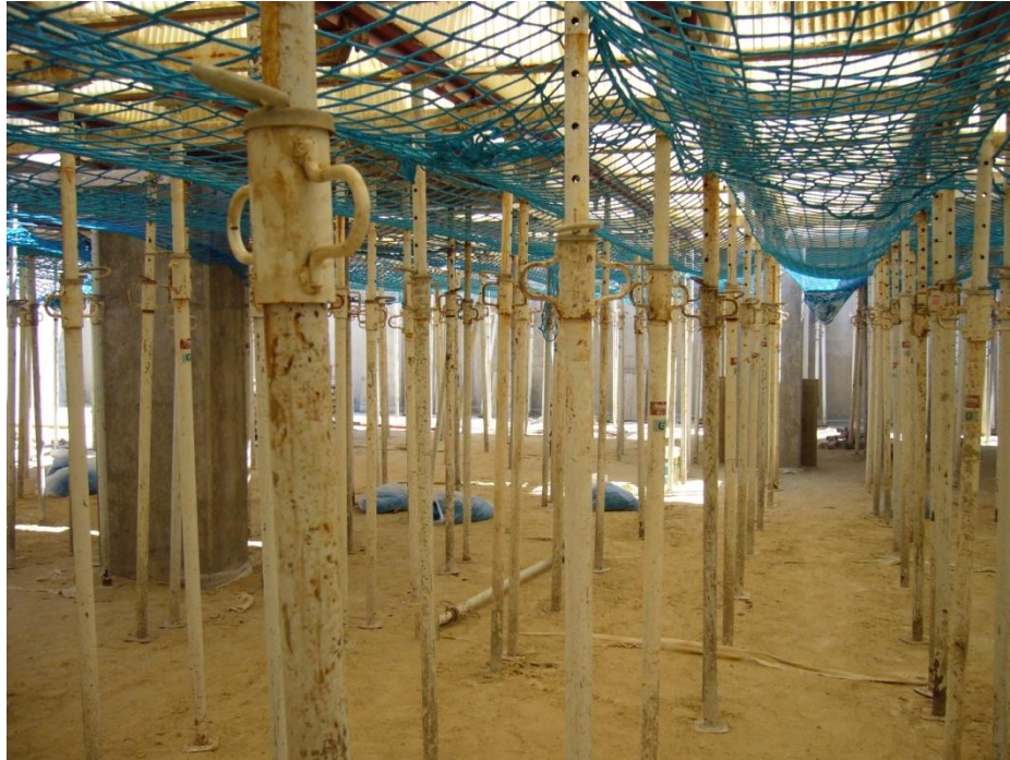
Fig. II.39 Instalación del sistema de cimbrado del forjado 1
