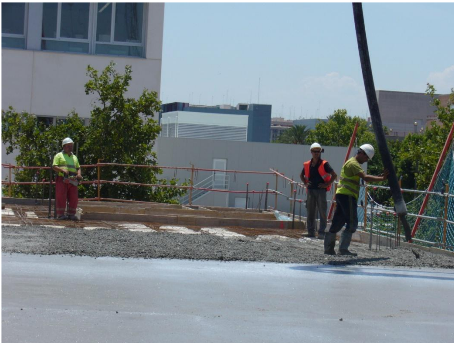
Fig. II.50 Hormigonado del forjado 2
