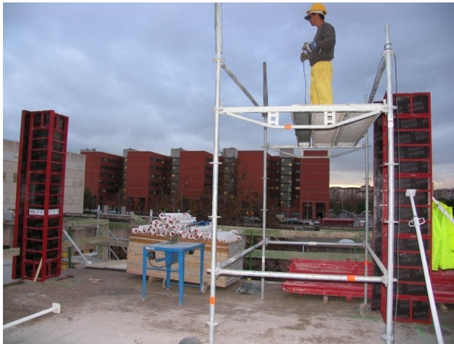
Fig. II.20 Hormigonado de los pilares del forjado 3
