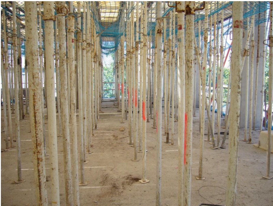
Fig. II.54 Instalación del sistema de cimbrado del forjado 3
