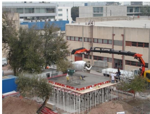
Fig. 3.2 Proceso constructivo día “0”
