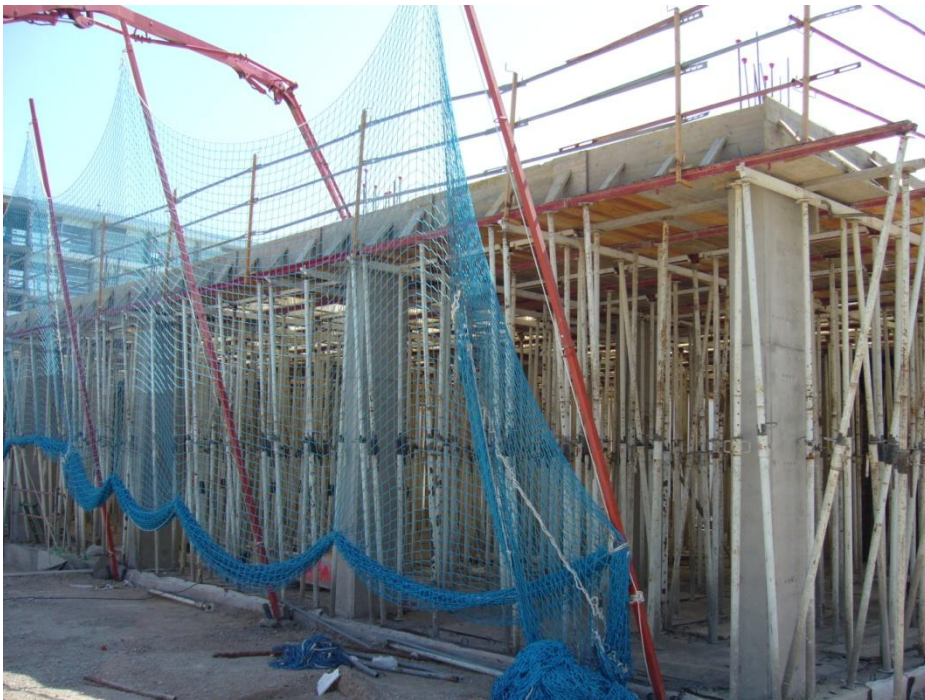
Fig. II.49 Hormigonado del forjado 2
