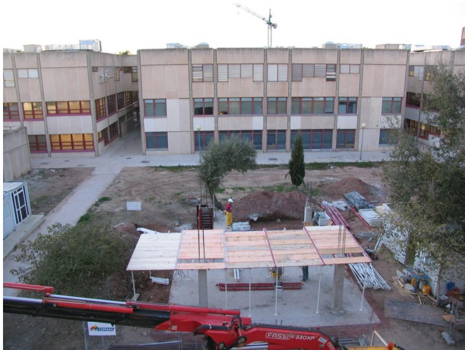
Fig. II.5 Instalación del sistema de cimbrado del forjado 1
