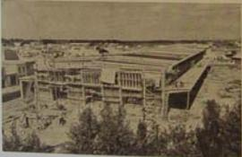
*Las características fundamentales de la obra debían ser la ausencia de pilares en toda la superficie interior ocupada por la nave central, por lo cual el elemento básico de la cubierta lo constituyen 18 vigas de hormigón pretensado de 34 m de luz.*
