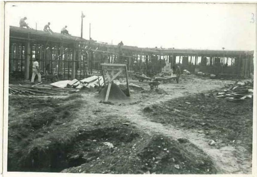
AFCCV. Detalle del montaje del forjado de cubierta de la zona de acceso público para el posterior hormigonado.
