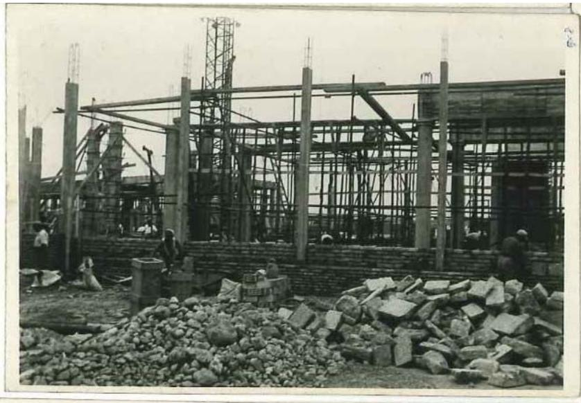
AFCCV. Detalle de la construcción de los zócalos del edificio y la hoja interior del cerramiento del mismo.
