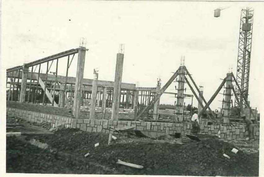
AFCCV. Pilares de hormigón a la espera del montaje del forjado mientras se ejecutaba la hoja exterior del cerramiento del edificio sobre el zócalo ya trasdosado con piedra del país.
