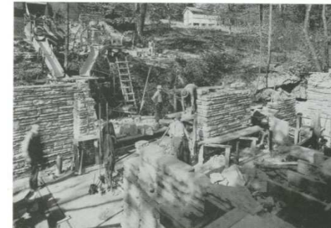
Imagen 33: Construcción de los muros de piedra
