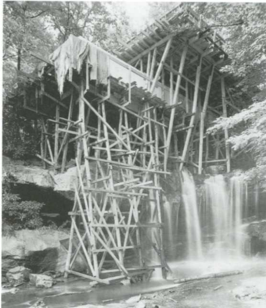
Imagen 32: Encofrado de la losa del primer piso
