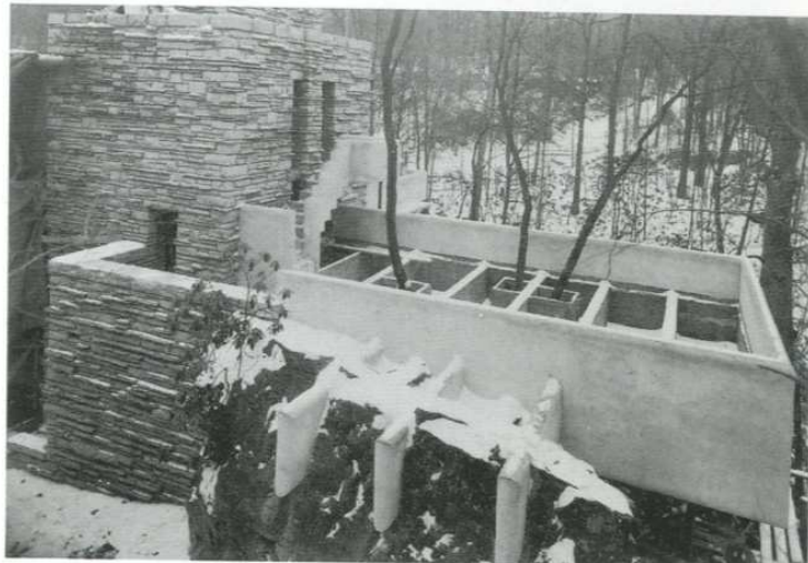
Imagen 34: Estructura reforzada de vigas de hormigón
