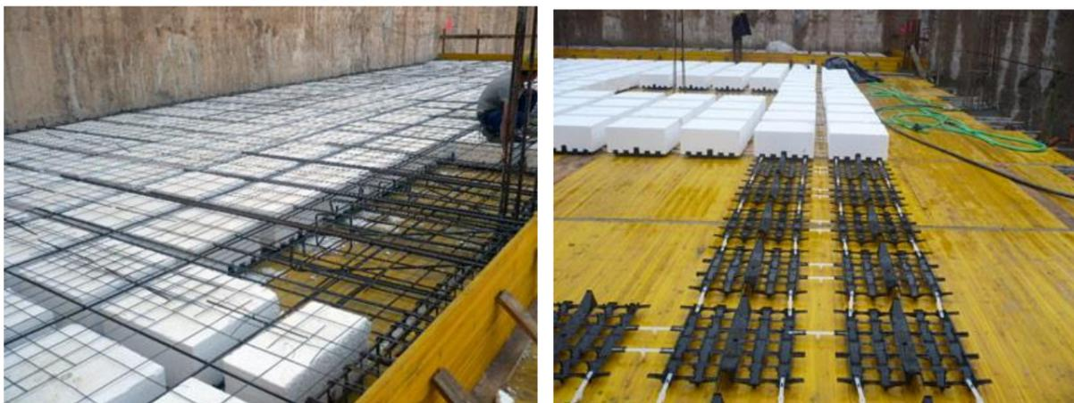
Imagen 16 – Sistema Basenet® para forjados reticulares de bloques perdidos de DALIFORMA S.L. Fuente: Catálogo de forjados reticulares de la empresa DALIFORMA S.L
