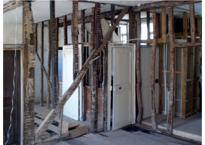
13. Interior del siglo XVIII de una casa catalogada Grado II, donde se ha quitado el entramado y enlucido sin permiso
