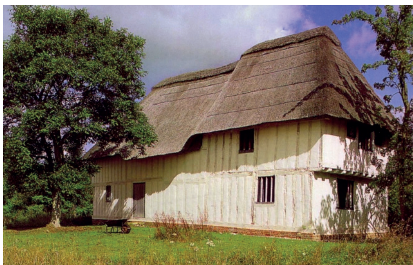
Casa comunal en Purton Green (Inglaterra), Foto: Warren Hall House in Purton Green (England), Photo: Warren
