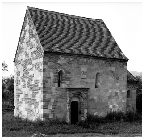
Fig. 22. La iglesia de Váraszó después de la reconstrucción.
