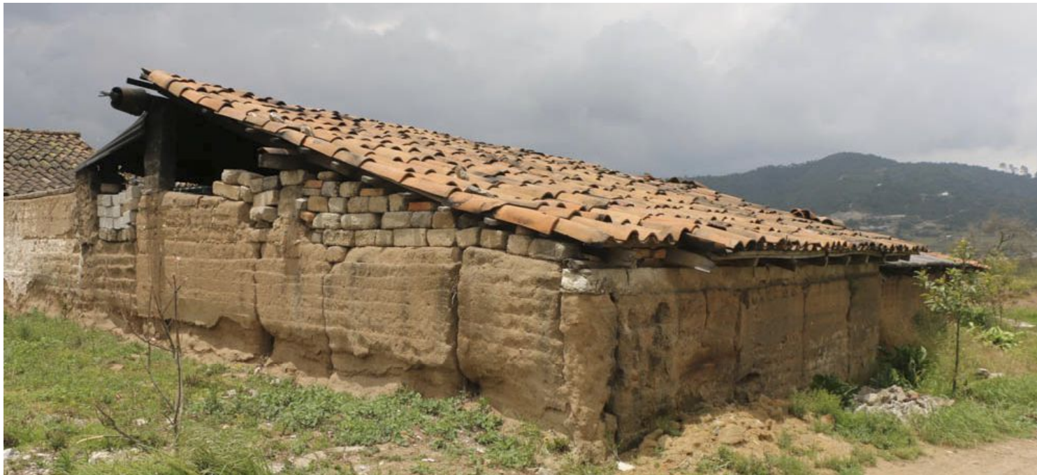
Vivienda con muros de tapia y con cubierta en pendiente. Zona del altiplano central. Imagen: (LAB, 2016)
