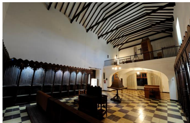
Figura 3: Vista general del estado actual del coro del convento de Santa Clara, Toro (Zamora).
