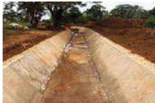
Figura N° 29 Cuneta perimetral pluvial típico de un vertedero controlado.
