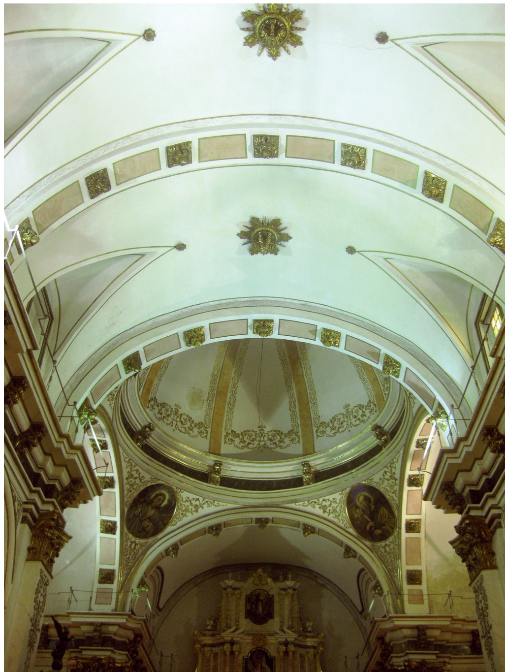
Fig. 2. Volta de canó de la nau.
