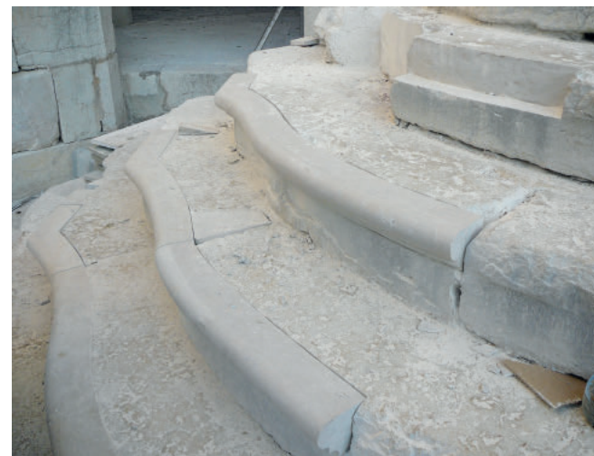
9. Trabajos en la escalinata de acceso 9. Work on the access staircase
