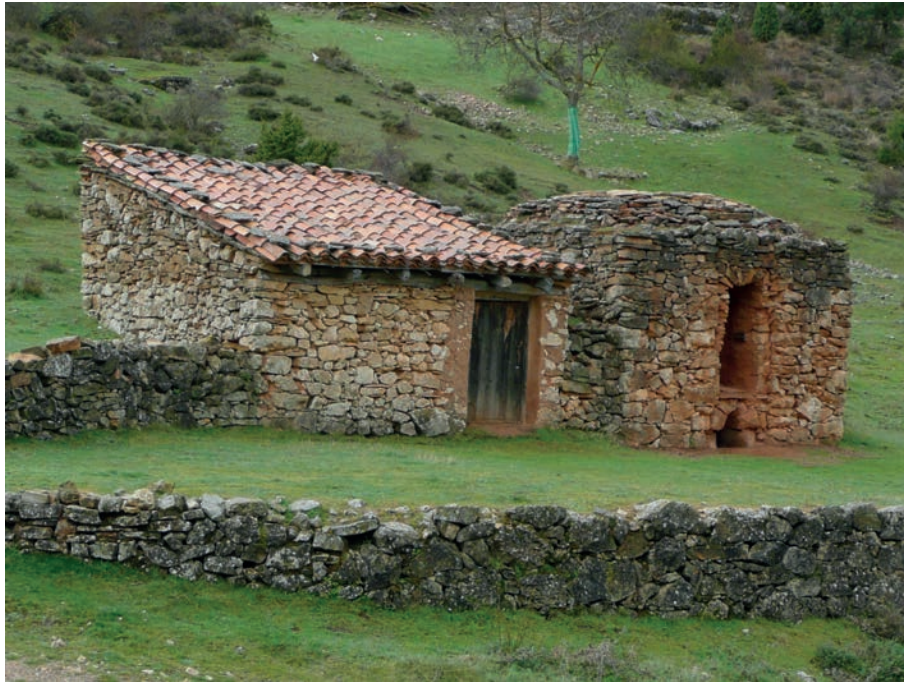
La tejería de la aldea de Sesga y su almacén, después de la restauración (Vegas & Mileto)
