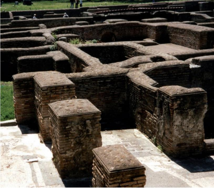
6 y 7. Ostia, Italia. Se utilizó la técnica los “baúles” para proteger la parte superior de los muros a través de la confección de una mezcla de cemento Portland con distintas piedras como guijarros y ladrillos.
