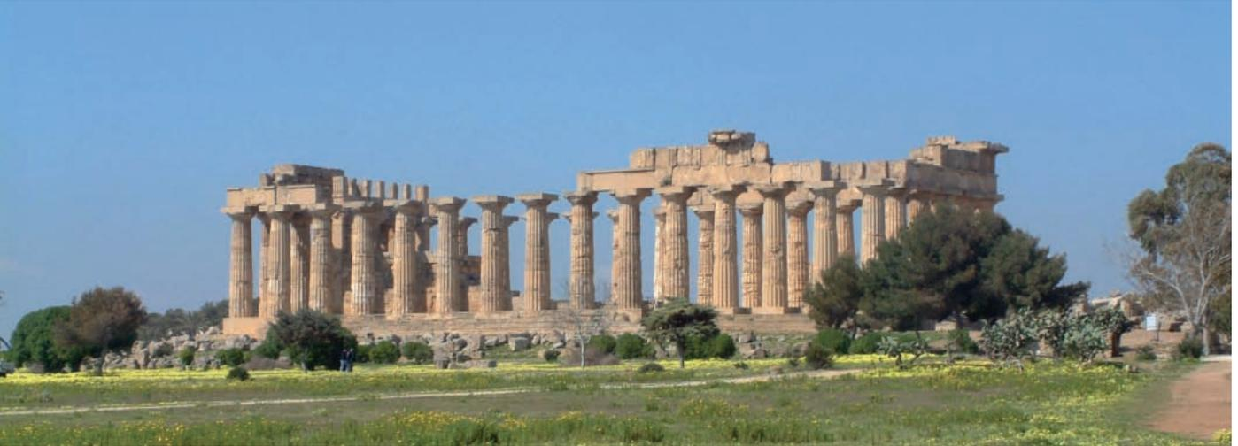
14. Selinunte, Italia. Templo E por J.Bovio Marconi (1950). Levantaron 15 columnas, por anastilosis y sobre ellas recolocaron un largo tramo del entablamento con estructura interior de hormigón armado.
