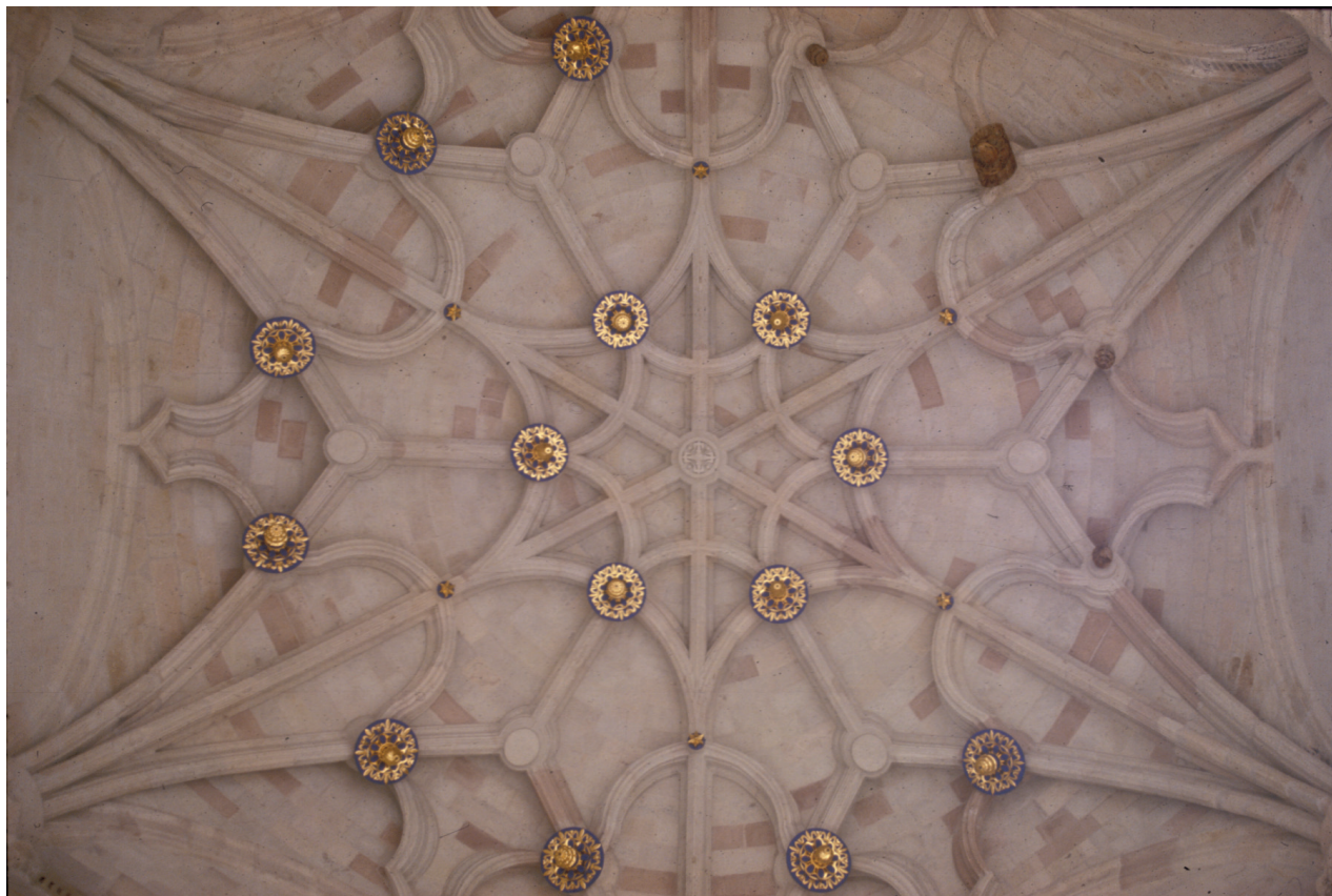
39. Aspecto de la bóveda ya terminada (foto: Benjamín Ibarra Sevilla)
