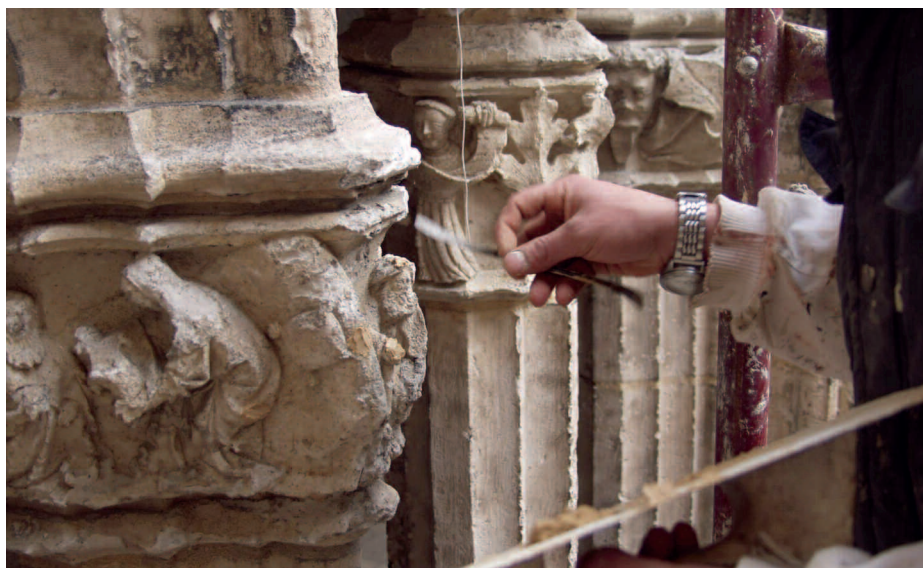
25. La última etapa de intervención en el claustro de la catedral ha sido la hidrofugación de los capiteles
