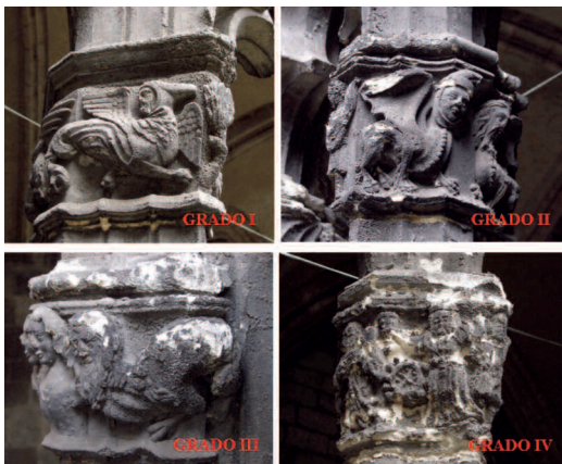
11. Ejemplo de capiteles con diferentes grados de deterioro
