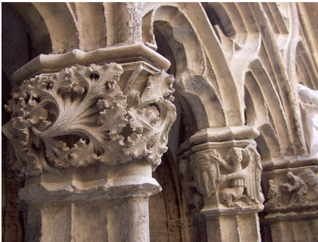
Detalle de capiteles en el claustro de la Catedral de Oviedo
