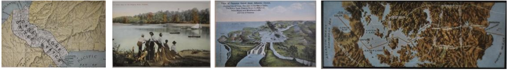
Fig. 4- Immagini storiche, risalenti all'inizio del secolo, relative alla costruzione del canale.
