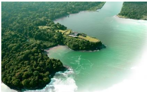
Fig. 3- Veduta aerea del forte di San Lorenzo sulla foce del Chagres. (J. Kingston Photo)
