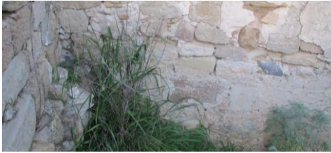
Fig. 6- Tessitura muraria dove sono visibili le malte di allettamento, gli intonaci e le litologie.
